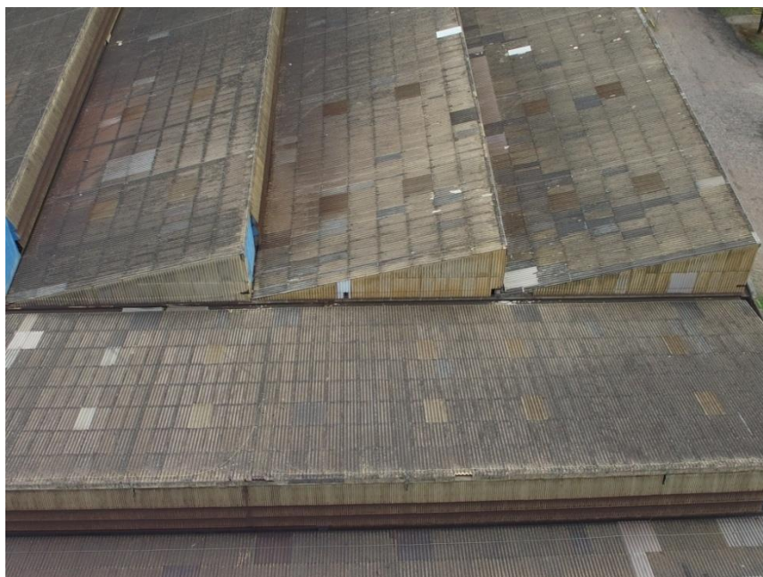
Figura 7. Foto tirada pelo drone durante o voo de inspeção do telhado
