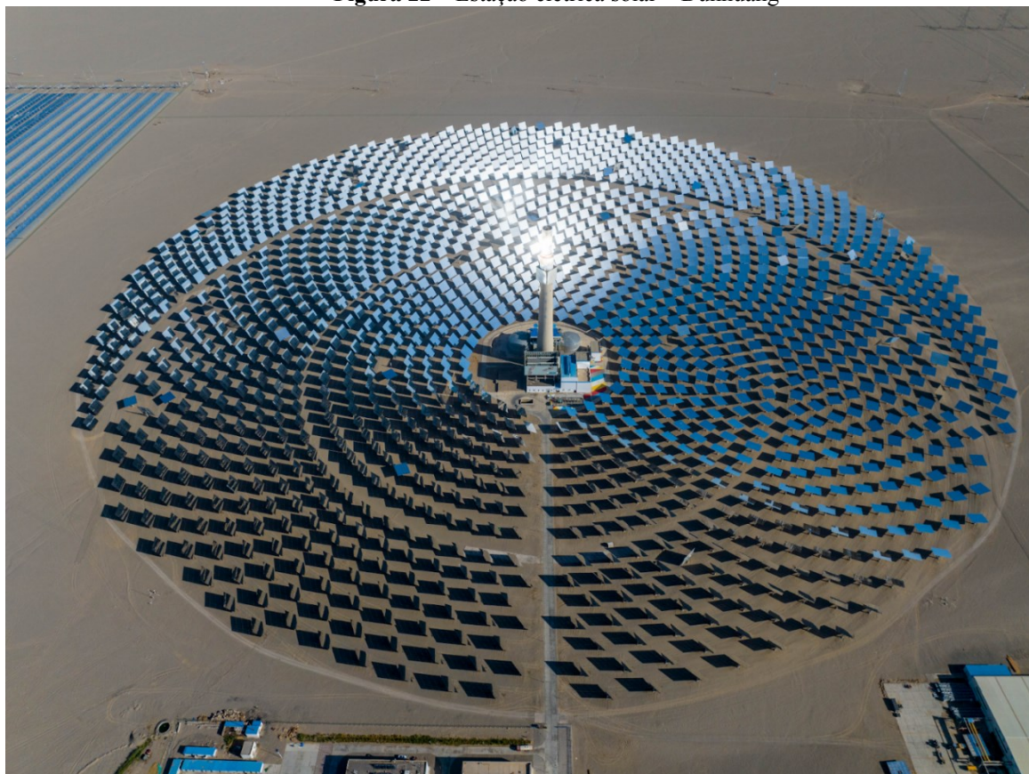
Figura 22 – Estação elétrica solar – Dunhuang 10
