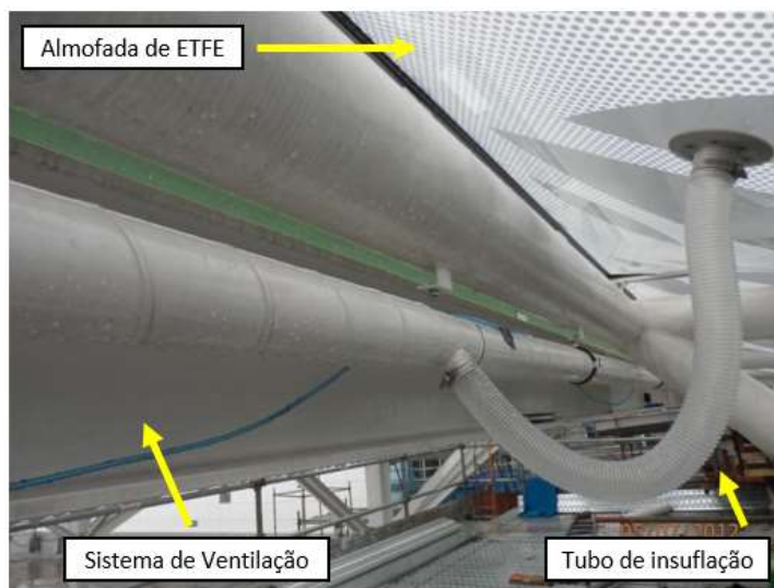
Figura 16: Mecanismo de insuflação das almofadas de ETFE
