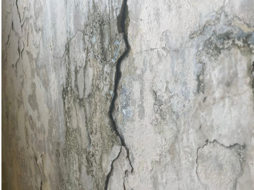
Figura 43: manifestação patológica Figura 42 após 67 dias
