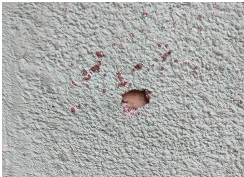
Figura 30: vesícula, pátio interno 2
