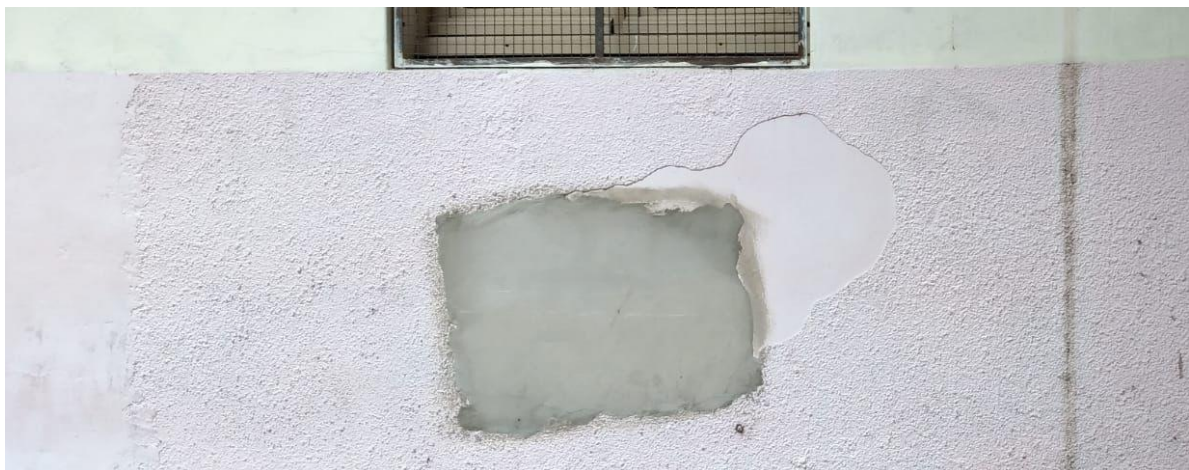
Figura 29: manutenção no descolamento, pátio interno 2
