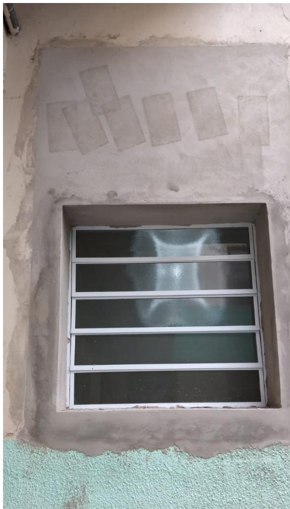
Figura 24: manutenção em esquadrias, pátio 1
