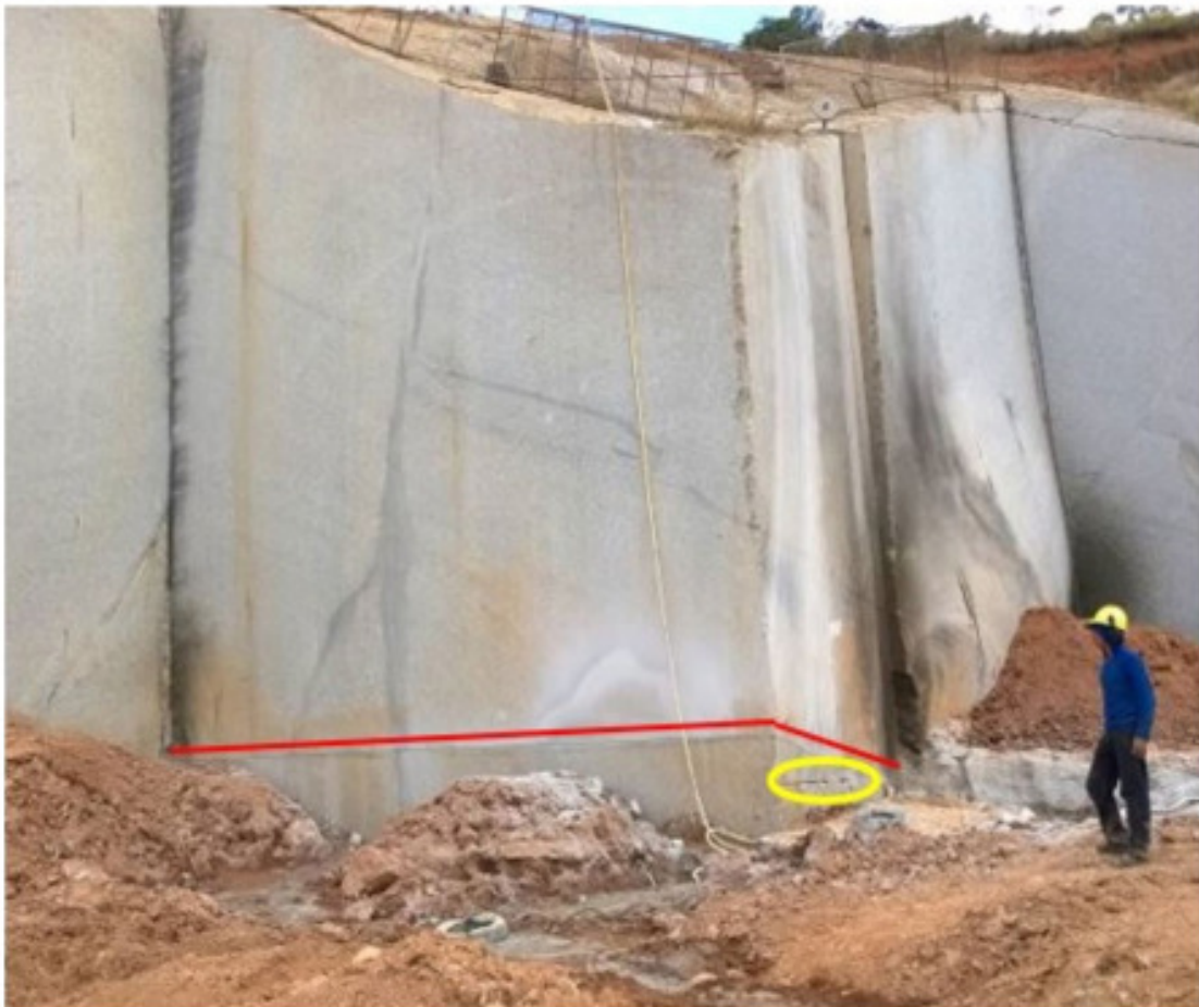
Figura 11 – Em vermelho a boca de lobo cortada e em amarelo os furos para realização do desmonte da mesma.
