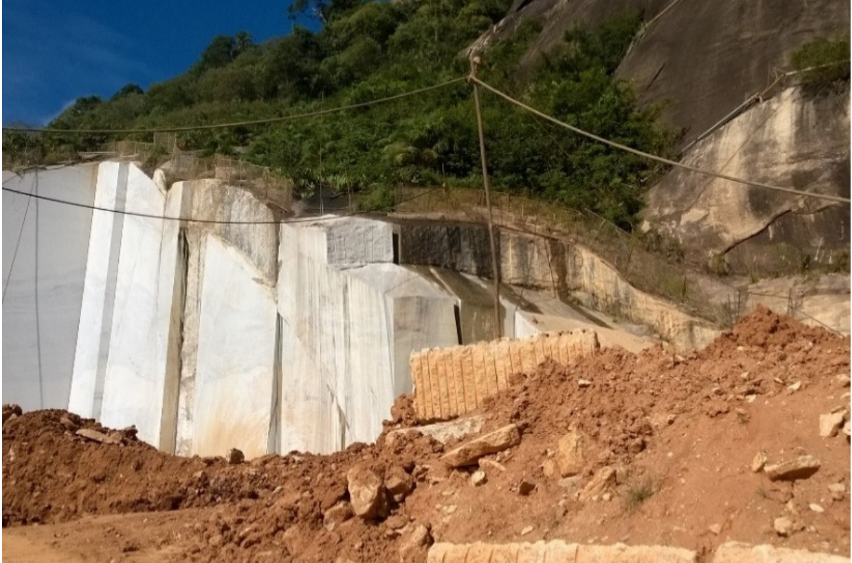
Figura 51 - Descontinuidade na direção da topografia do maciço.
