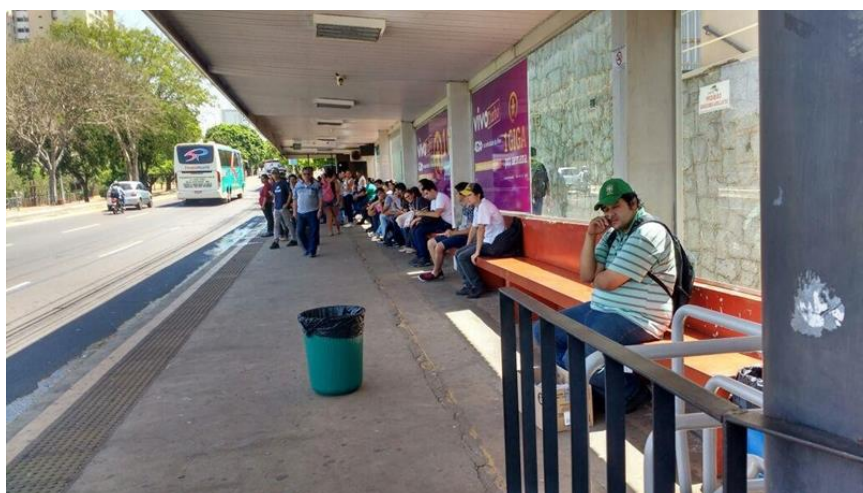
Figura 05 – Análise geral do ponto de paradas (bancos, lixeira, câmeras, iluminação e piso tátil).
