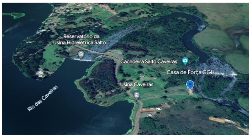
Figura 2: Vista da casa de força e reservatório da CGH Caveiras.
