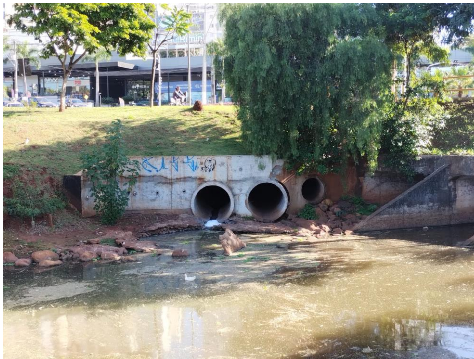
Figura 8: Bueiro de greide tubular triplo lago Igapó II. Fonte: Autores, 2023.
