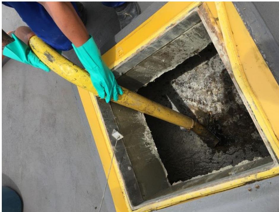
Figura 7 - Retirada de espuma com caminhão de sucção. Fonte - David Garcia
