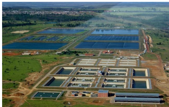
Figura 3: Vista área da ETE-Melchior (abaixo) e ETE-Samambaia (acima), fonte (CAESB,2023)
