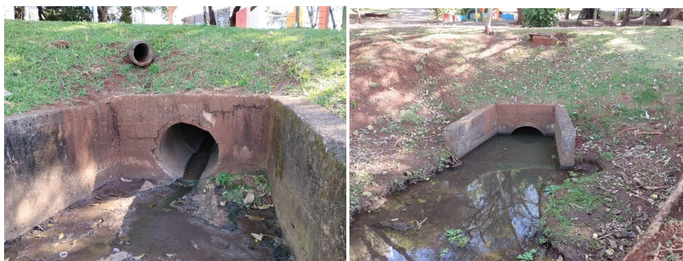
(a) (b) Figura 6: Bueiros do lago Igapó II (a) greide e (b) grota. Fonte: Autores, 2023.
