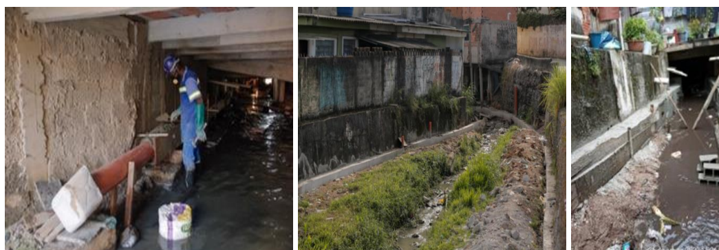
Figura 30: Exemplo de execução de solução alternativa, com assentamento de rede coletora de esgoto nas margens dos córregos.
