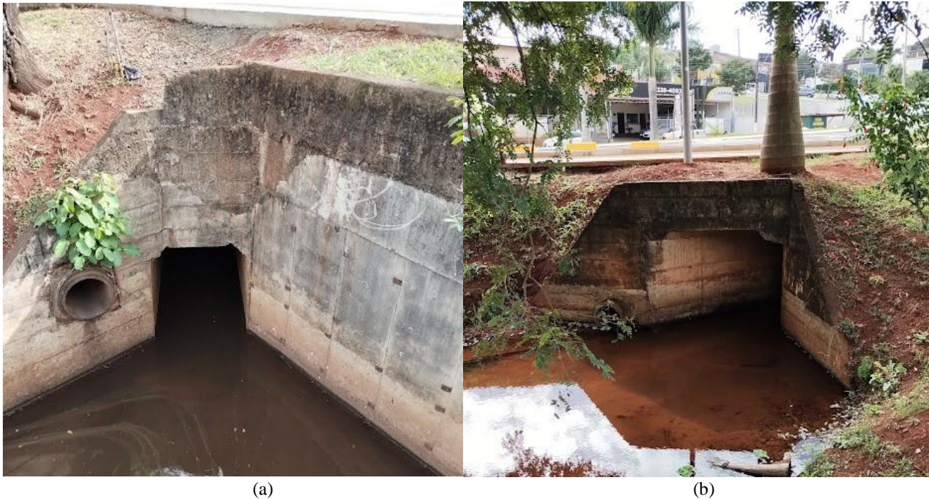
(a) (b) Figura 9: Bueiros de grotá entre o Lago Igapó II e o córrego ao lado do aterro. Fonte: Autores, 2023.
