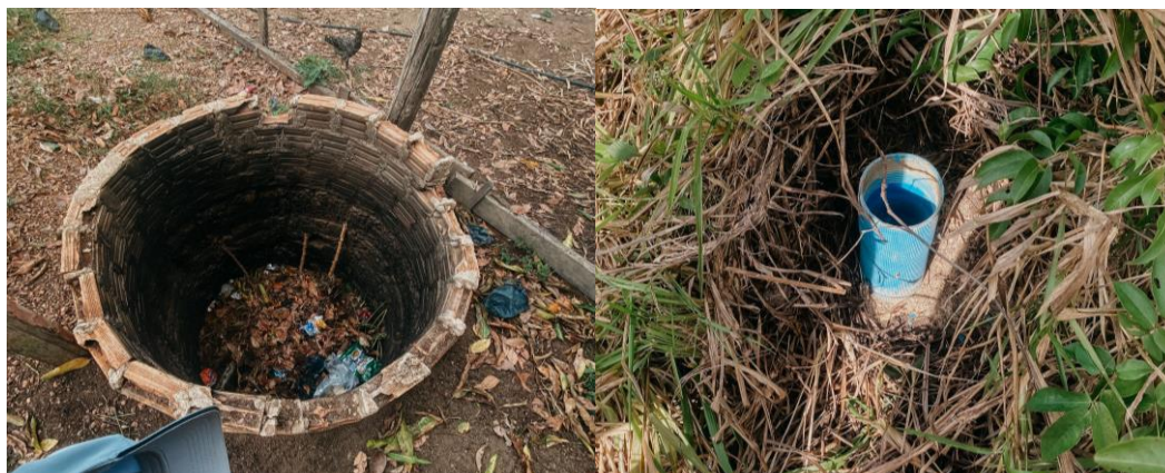
Figura 2: Reconhecimento da área, (a) poço desativado, utilizado como reservatório de resíduos sólidos e (b) Tubulação aberta. Fonte: Os autores.
