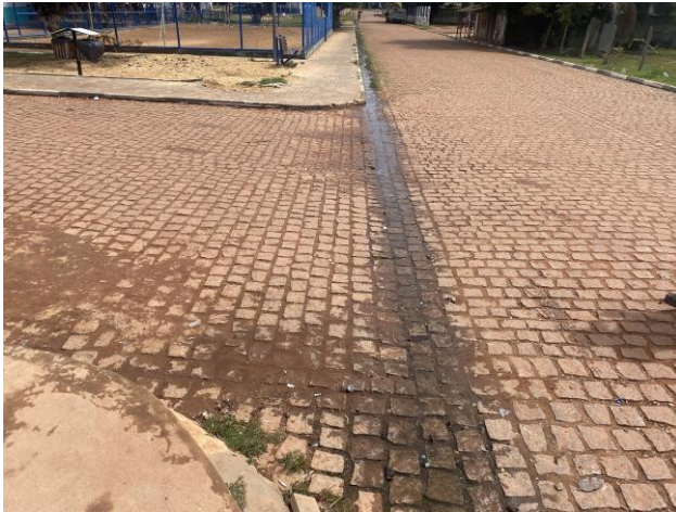
Figura 12 e 13: Esgoto escoando por diversas ruas e rede de drenagem irregular
