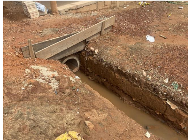
Figura 12 e 13: Esgoto escoando por diversas ruas e rede de drenagem irregular
