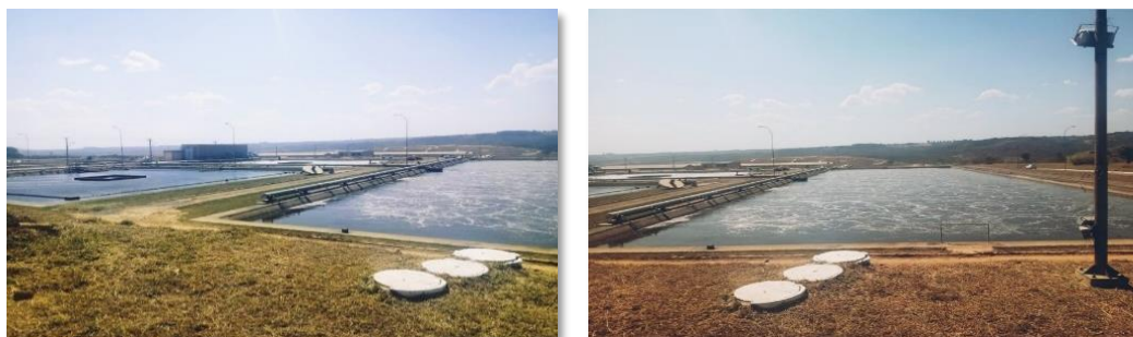
Figura 5 e 6 - Reatores Aerados Difusos da ETE-Melchior, fase de aeração e decantação, fonte: acervo pessoal.
