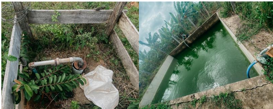
Figura 4: Reconhecimento da área, (a) sistema de aquisição de água para consumo pelo poço da associação e (b) Tanque de abastecimento para mecanismo de irrigação. Fonte: Os autores.
