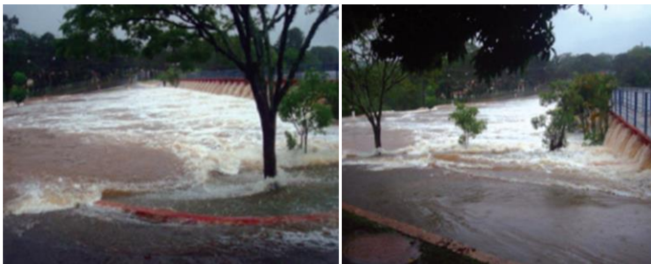
(a) (b) Figura 5: Nível d'água extravasando nos bueiros após enchente. Fonte: Alves Junior e Pereira Neto, 2020
