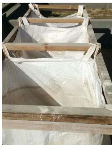
Figura 2 - Big Bags instalados sobre o leito de secagem (estruturas em madeira iniciadas para ensaio)
