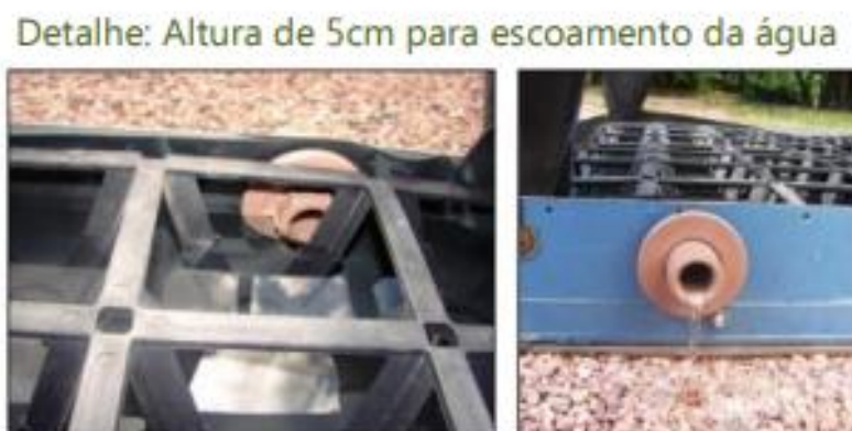
Figura 22 – Detalhe Dreno para escoamento de água do sistema Laminar Médio
