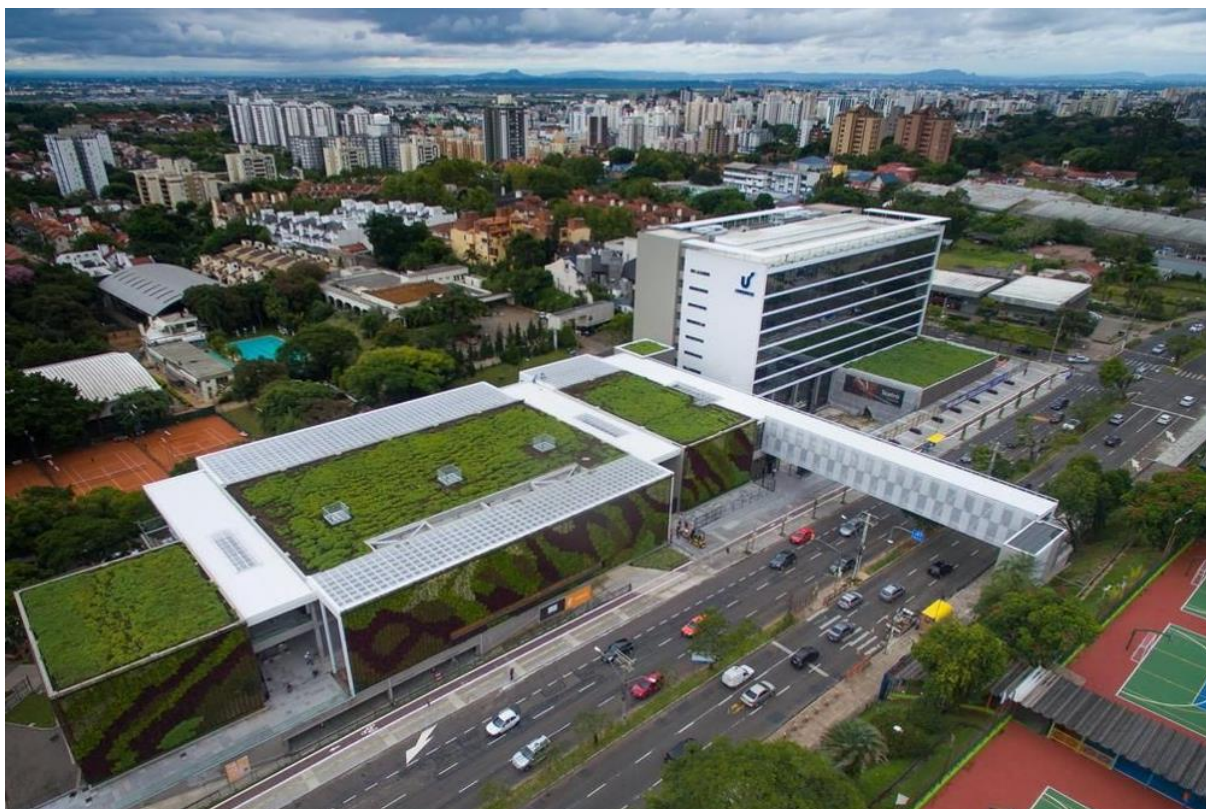
Figura 2 – Telhado Verde na Cidade de Porto Alegre.
