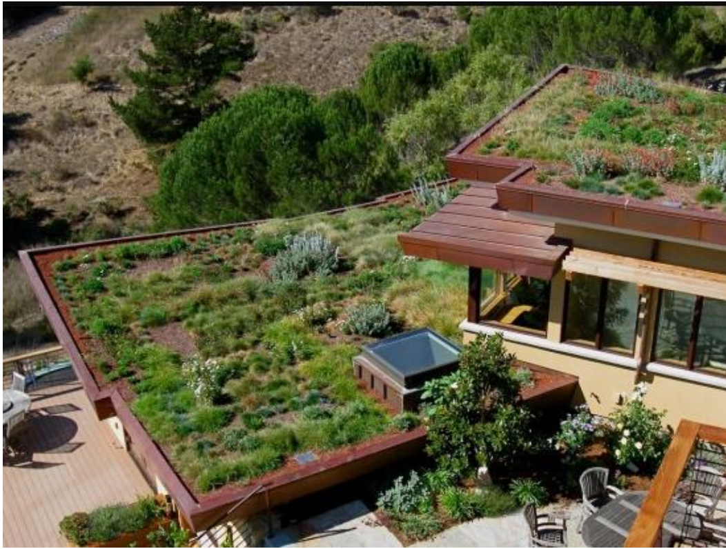
Figura 3 – Dificuldade em executar cobertura vegetada desde o momento inicial.
