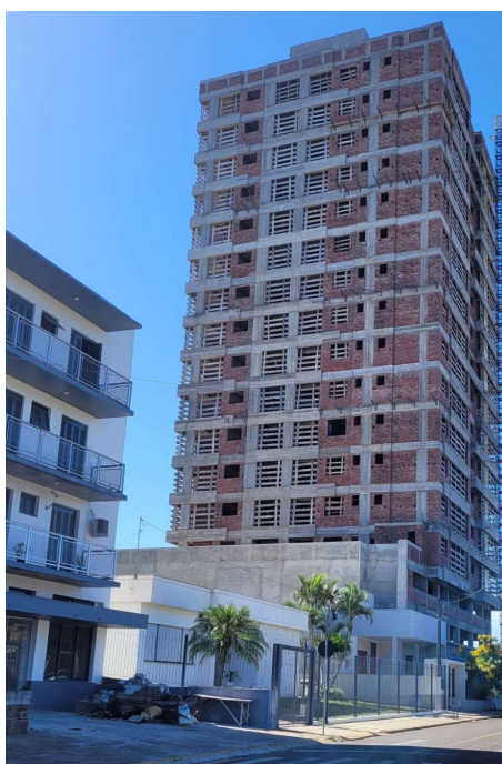
Figura 5 – Vista da execução da obra.
