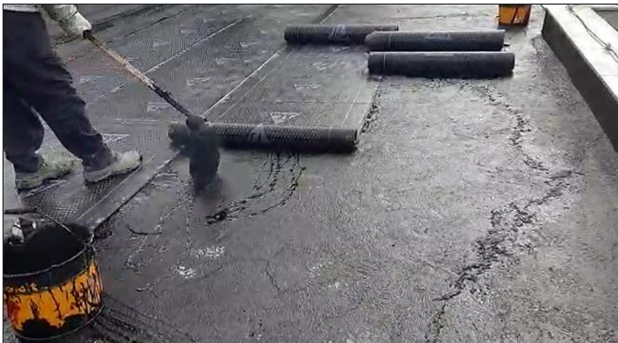
Figura 20: Aplicação do asfalto quente
