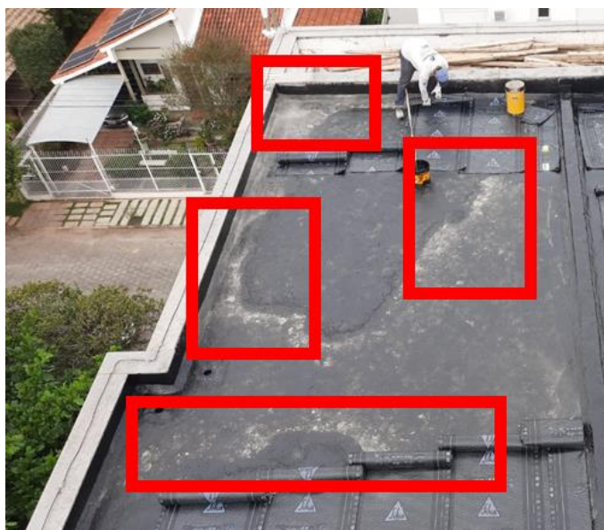
Figura 19: Aplicação do promotor de aderência
