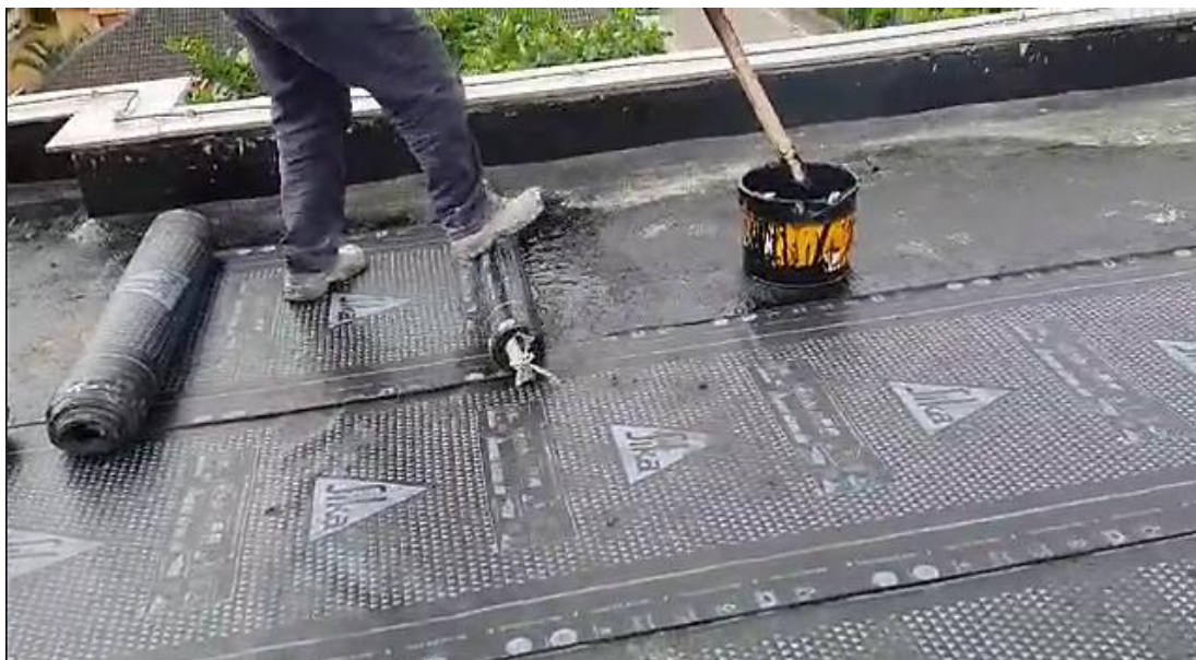
Figura 21: Aplicação da manta asfáltica
