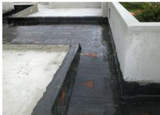
Figura 8: Teste de estanqueidade
