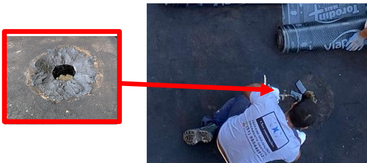
Figura 15: Detalhamento do ralo.
