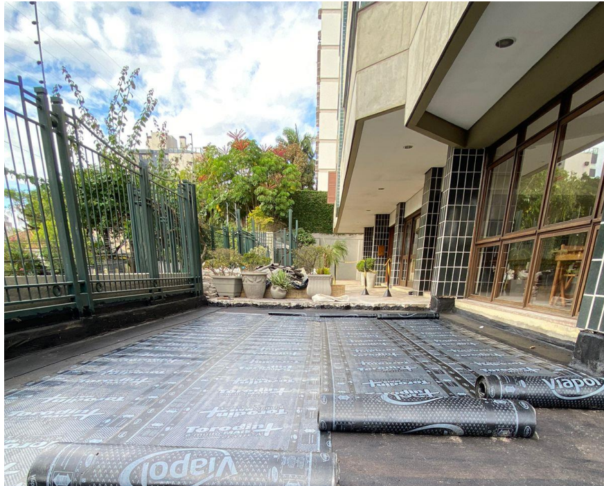
Figura 11: Bobinas sendo desenroladas e alinhadas
