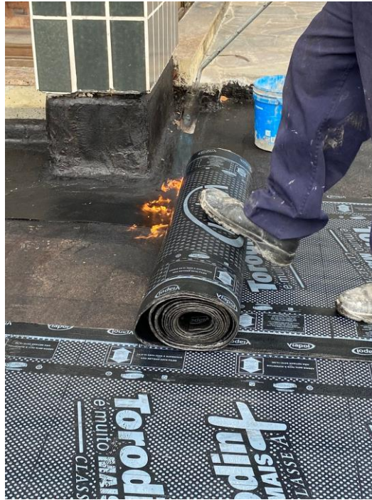
Figura 13: Colagem com a chama direcionada para a manta e o substrato simultaneamente
