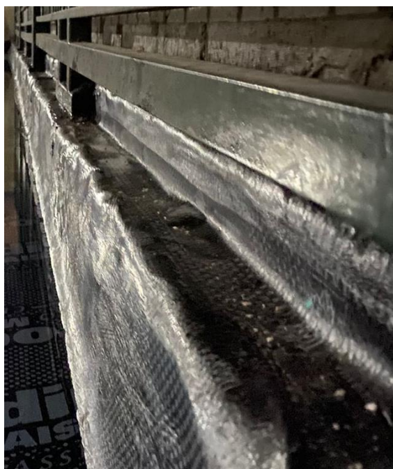
Figura 17: Detalhamento da ancoragem do rodapé
