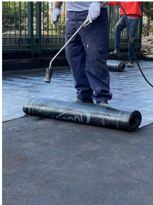
Figura 14: Aplicação da manta asfáltica com maçarico
