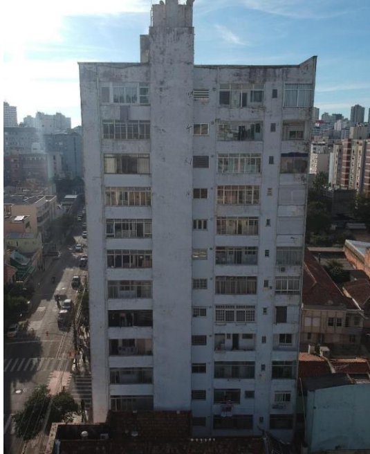
Figura 35 - Aspecto atual da fachada sul
