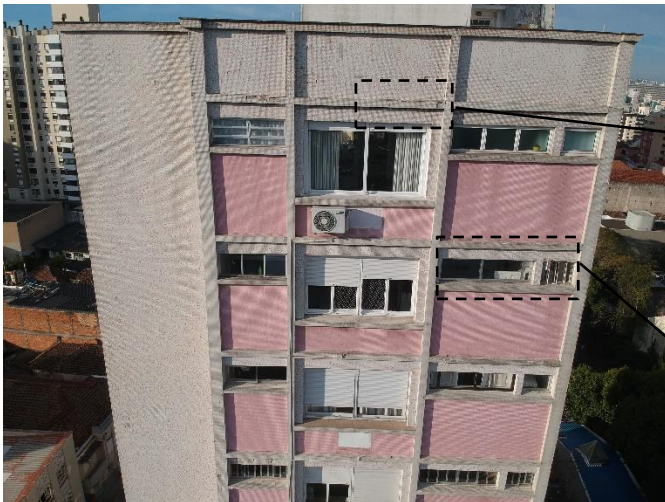
Figura 43 - Inspeção de deslocamento/descolamento.
