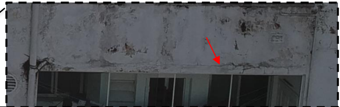
Figura 40 - Inspeção de fissuras
