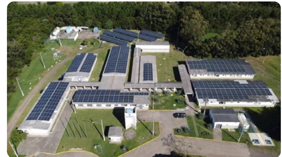
Usina de energia solar fotovoltaica no Campus Litoral Norte Foto: Fabiano Osiel Feitosa Passos - Jornal do Comércio
