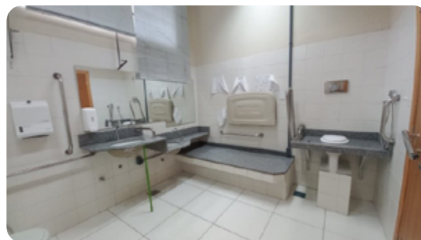
Sanitário Familiar Acessível. Foto: SUINFRA
