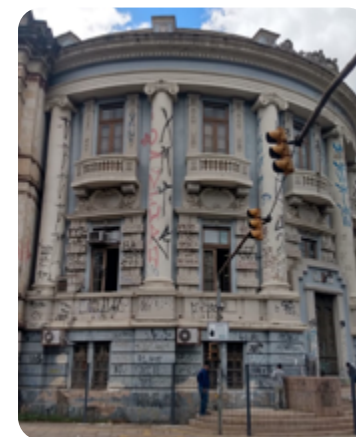
Obra de revitalização. Foto: SUINFRA
