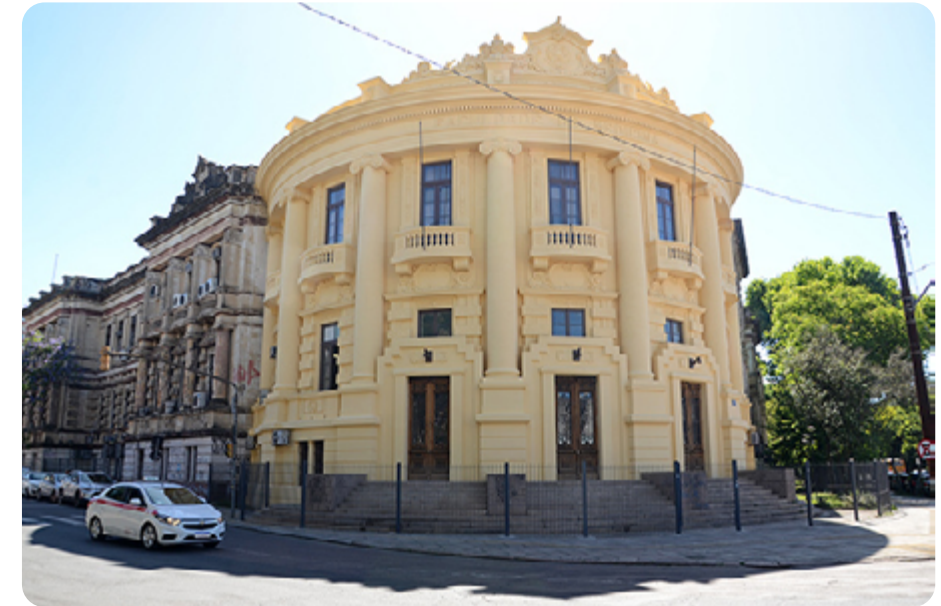
Fachada restaurada do antigo prédio da Faculdade de Medicina no Campus Centro. Foto: Gustavo Diehl
