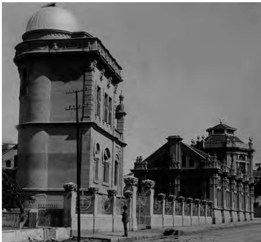
Figura 51: Vista frontal do Observatório Astronômico (E) e Castelinho (D)
