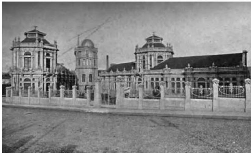
Figura 4: Castelinho (E), Observatório Astronômico (C) e Château (D): vista frontal década de 1900.
