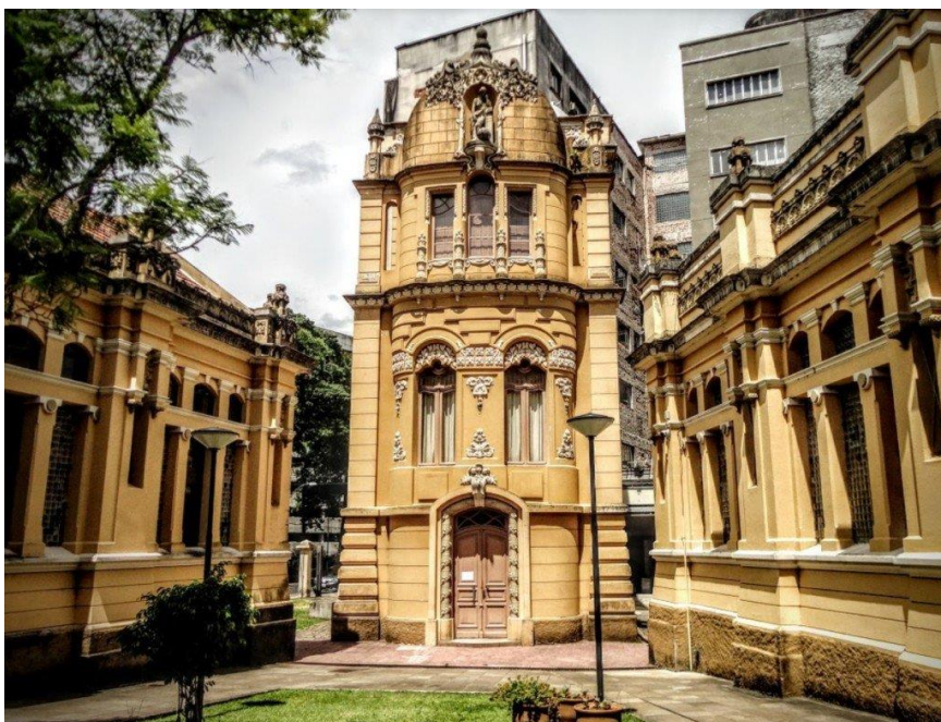
Figura 54: Observatório Astronômico: fachada frontal, após a restauração
