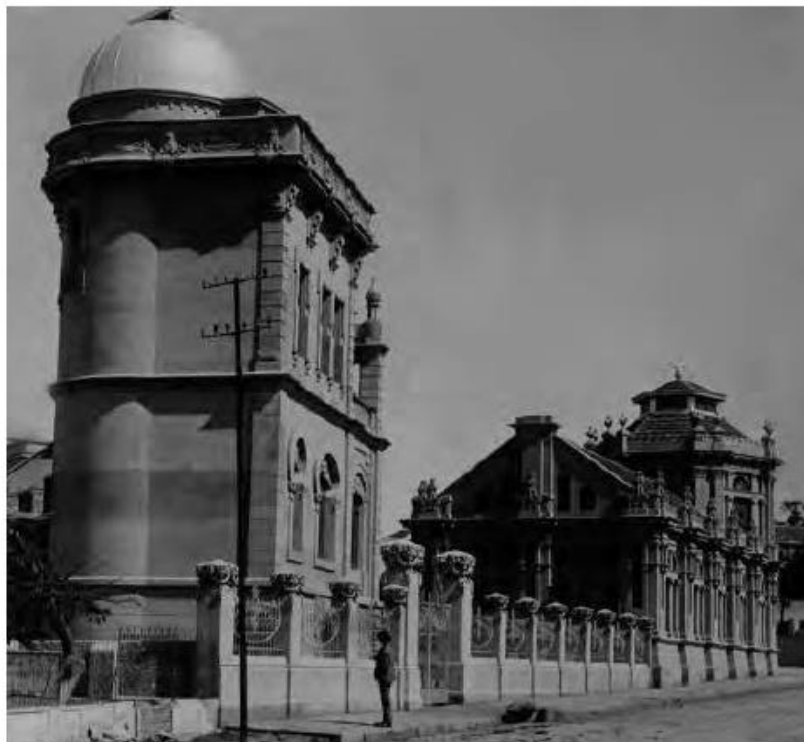
Figura 3: Vista frontal do Observatório Astronômico (E) e Castelinho (D).
