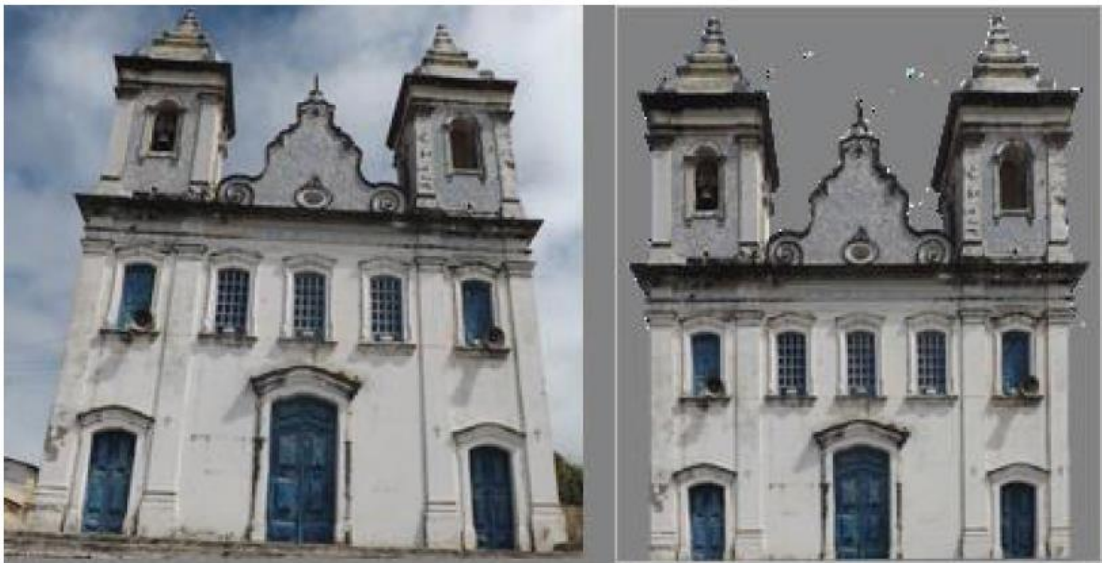
Figura 26: Tomada fotográfica in loco e retificação fotográfica
