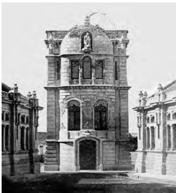
Figura 5: Fachada frontal do Observatório Astronômico: final da década de 1900.
