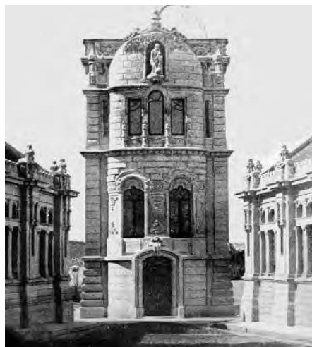
Figura 52: Fachada frontal do Observatório Astronômico: final da década de 1900.
