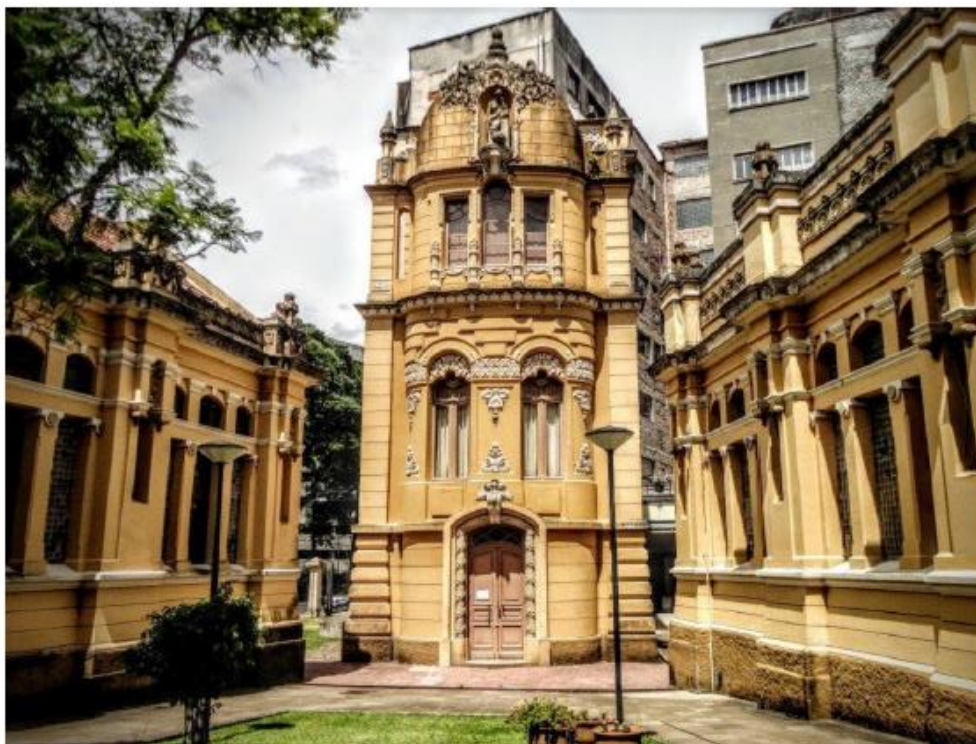
Figura 6: Observatório Astronômico: fachada frontal, após a restauração.
