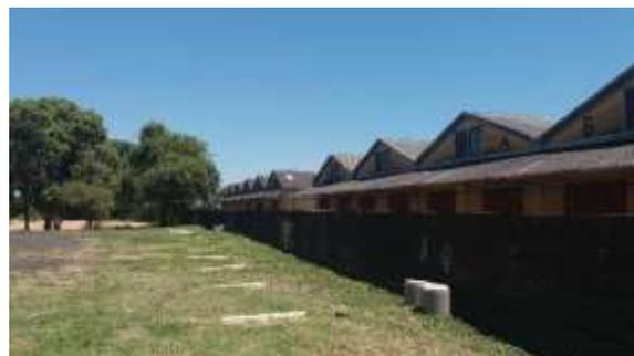
Figura 5.5 – Trecho do Muro da Mauá próximo a Usina do Gasômetro onde a altura é inferior a 3 m (altura registrada ao longo de grande parte do Muro)
