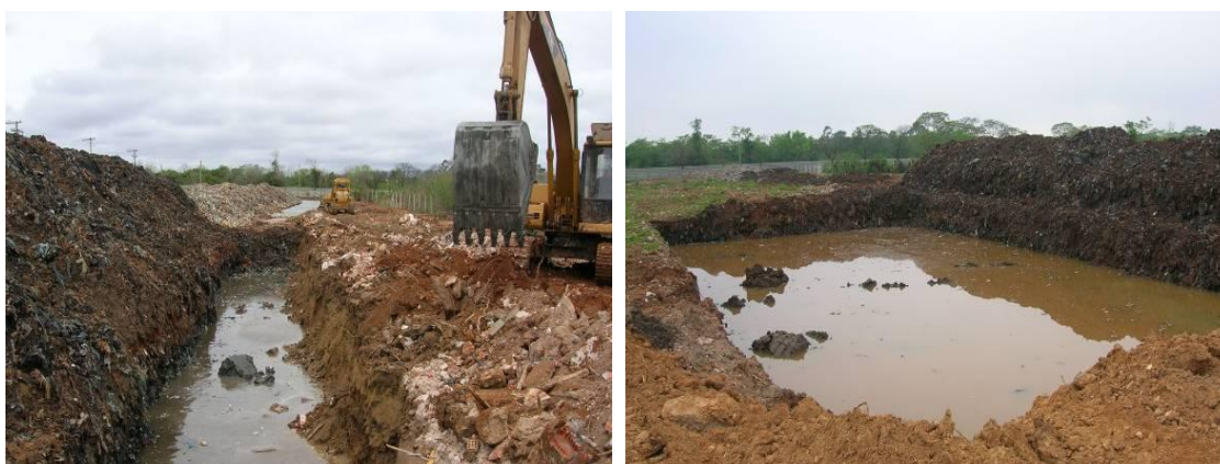
Figura 15 – Remoção dos resíduos no Terreno 4.
