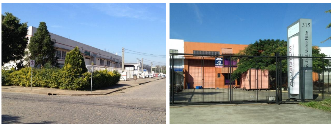
Fotografia 5 – Edificações comerciais e industriais da Quadra 4.
