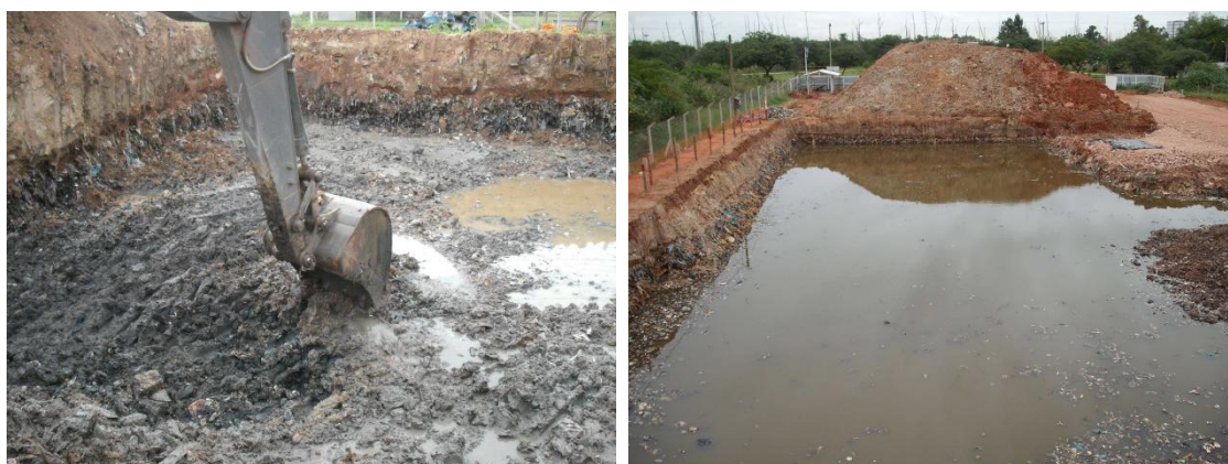
Figura 14 – Remoção dos resíduos no Terreno 3.
