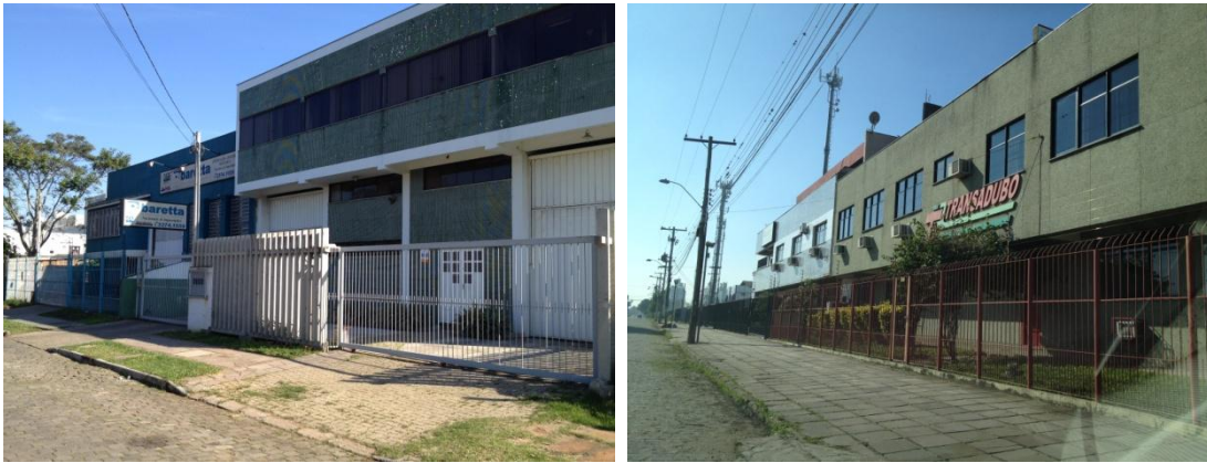
Fotografia 10 – Edificações comerciais e industriais da Quadra 8.
