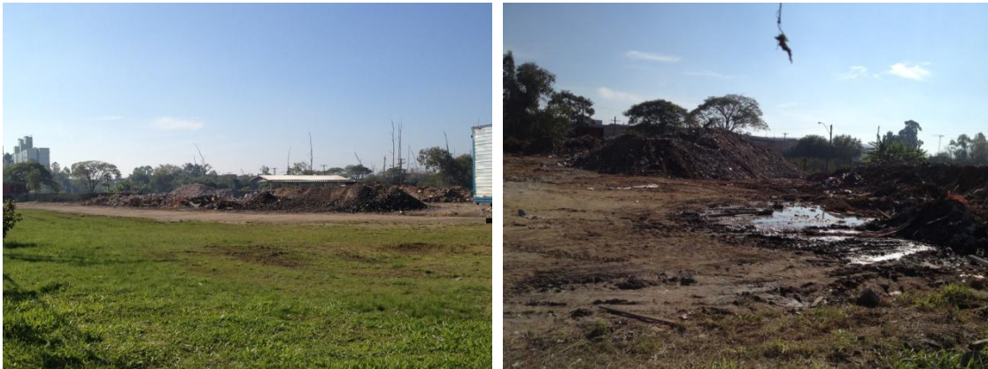
Fotografia 11 – Depósito de solo e materiais inertes da Quadra 9.
