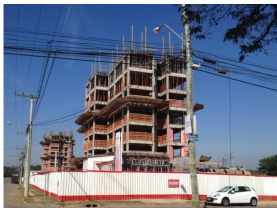
Fotografia 6 – Residencial em construção na Quadra 5.
