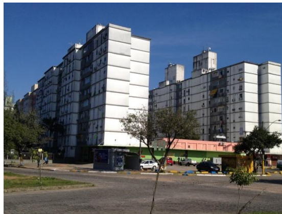
Fotografia 13 – Residencial Lá Spezia (Quadra 11).
