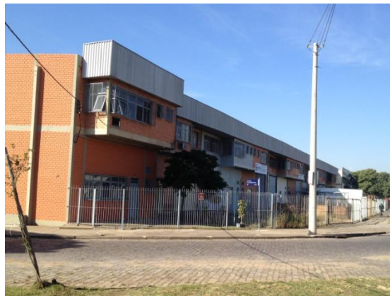
Fotografia 8 – Edificações comerciais e industriais da Quadra 5.
