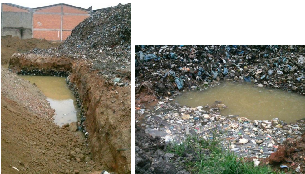
Figura 16 – Remoção dos resíduos no Terreno 5.
