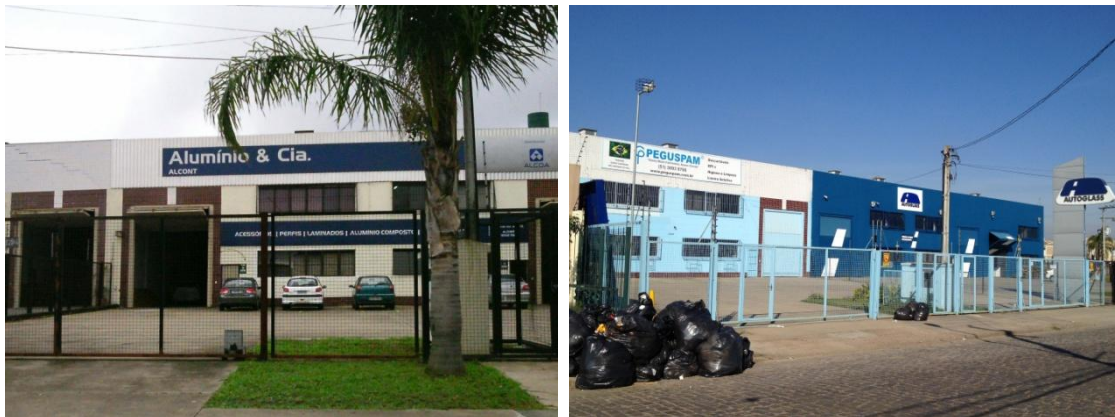
Fotografia 2 – Edificações comerciais e industriais da Quadra 1.
