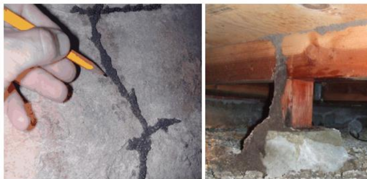
Figura 4 - Ataque de cupins de solo
