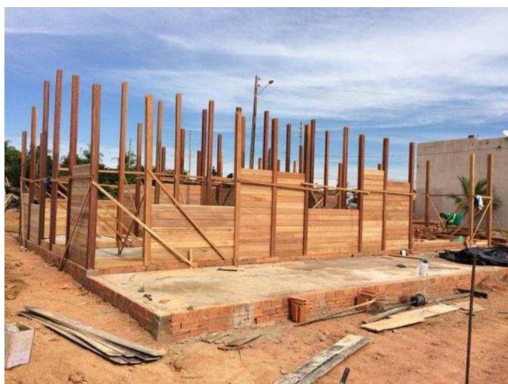
Figura 11 - Construção de casa de madeira sobre elementos impermeabilizados
