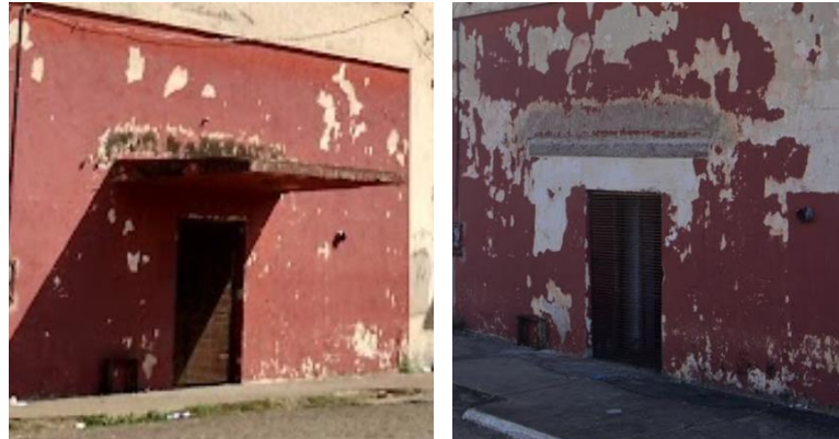
Figura 30 – Fachada leste antes (a) e após (b) retirada de marquise
