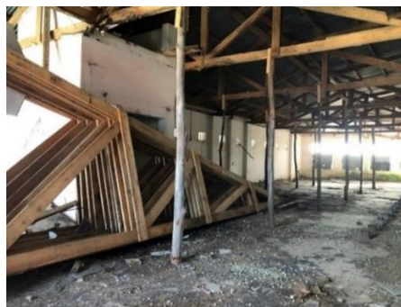
Figura 43 – Escoramento do telhado e armazenamento de treliças para substituição
