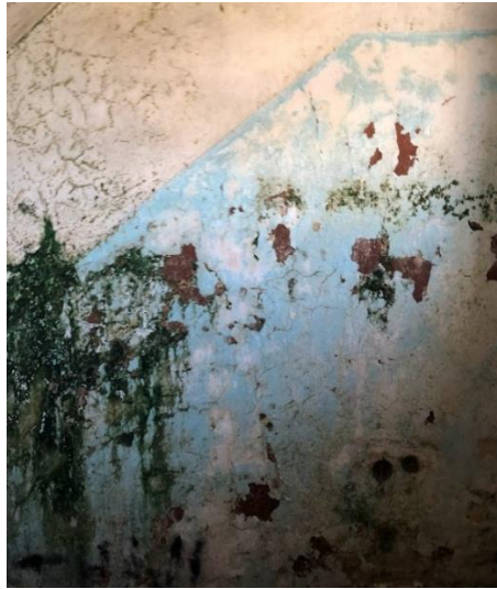
Figura 33 - Fissuras mapeadas em revestimento.
