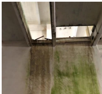
Figura 21 - Concentração de danos nas proximidades de aberturas na laje
