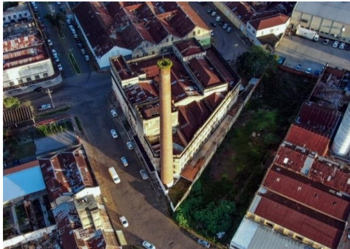
Figura 6 – Foto aérea da edificação do antigo engenho
