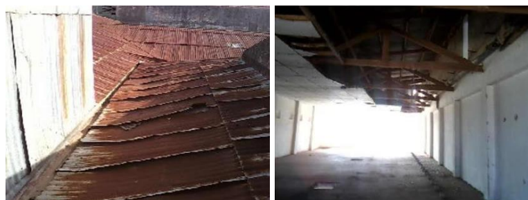
Figura 41 – Características da cobertura da edificação
