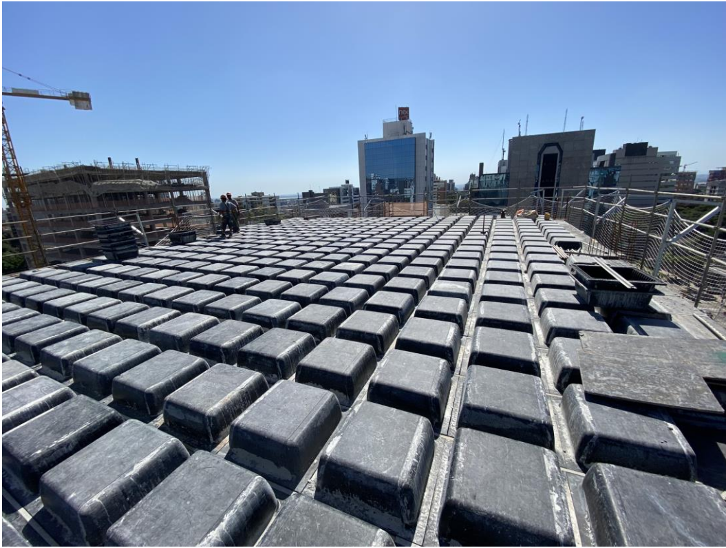
Figura 72 – Montagem das cubetas finalizada – C1
