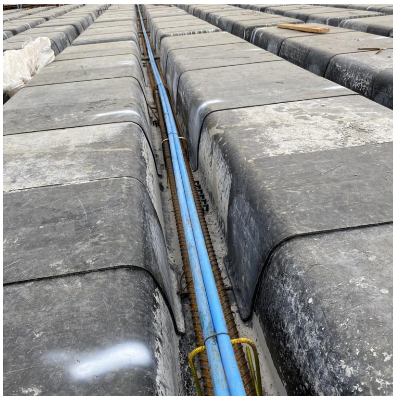
Figura 95 – Dupla de cabos posicionada na nervura e fixada nos suportes
