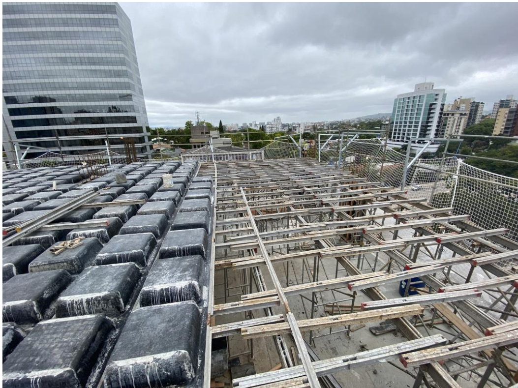
Figura 67 – Montagem das cubetas em execução – C2
