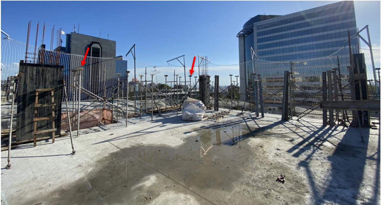
Figura 53 – Montagem do escoramento (torres de andaime) das vigas perimetrais – C1
