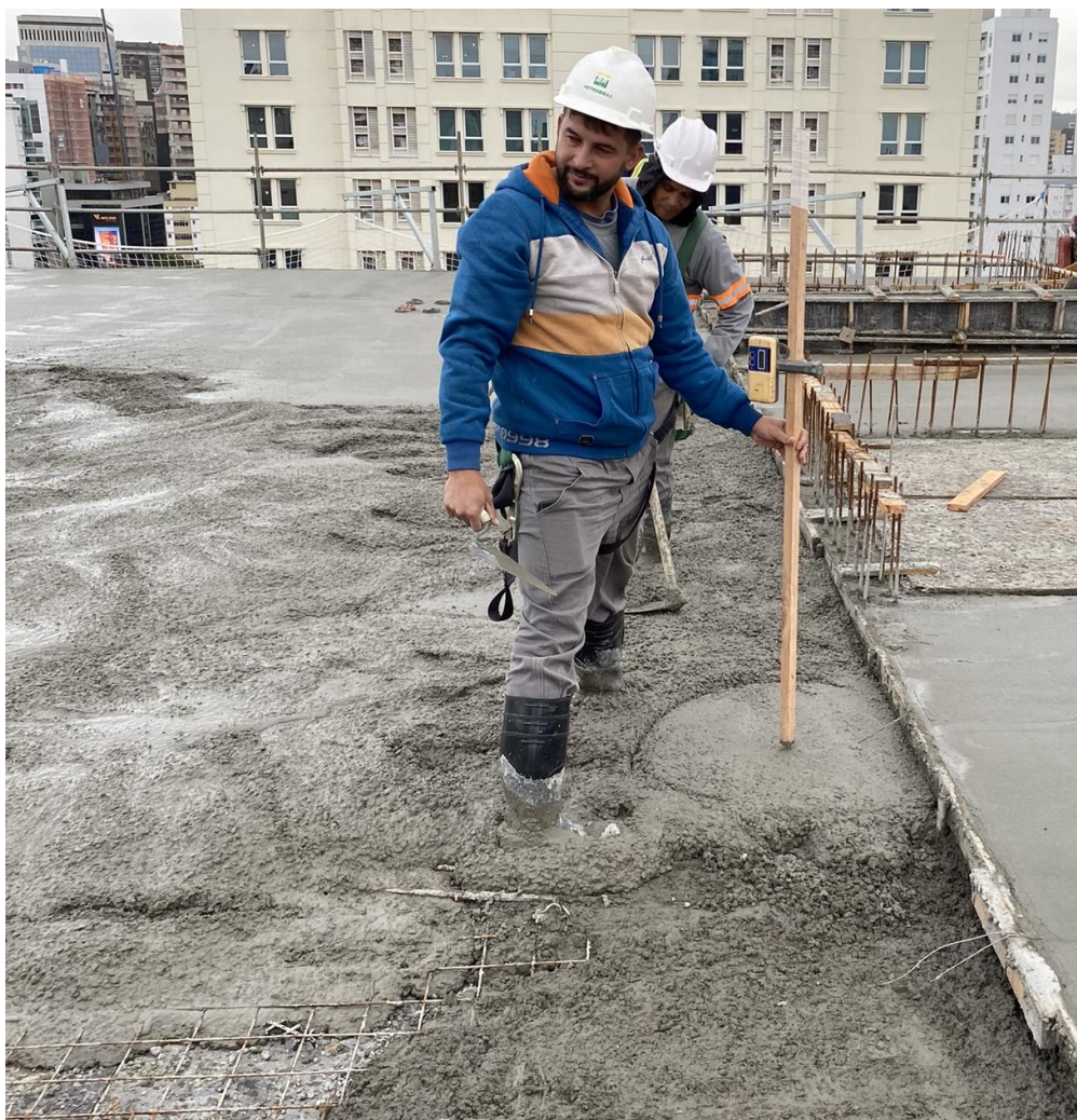
Figura 115 – Marcação dos pontos de referência de nível do concreto
