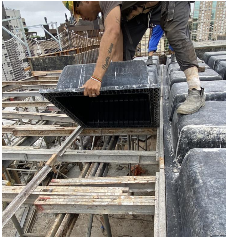
Figura 69 – Cubeta sendo encaixada durante a montagem
