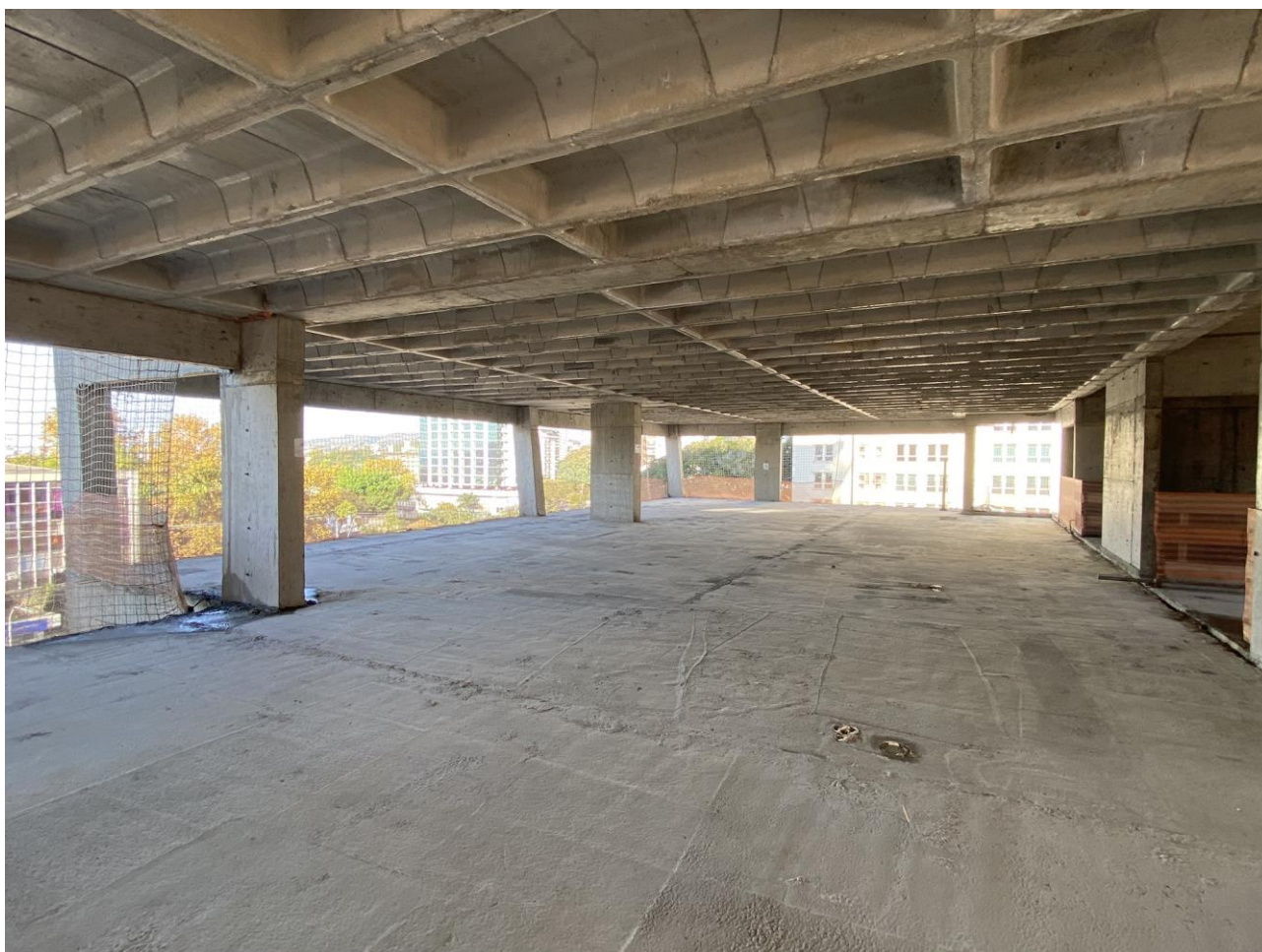
Figura 131 – Pavimento finalizado – Trecho C2 (vista 1)
