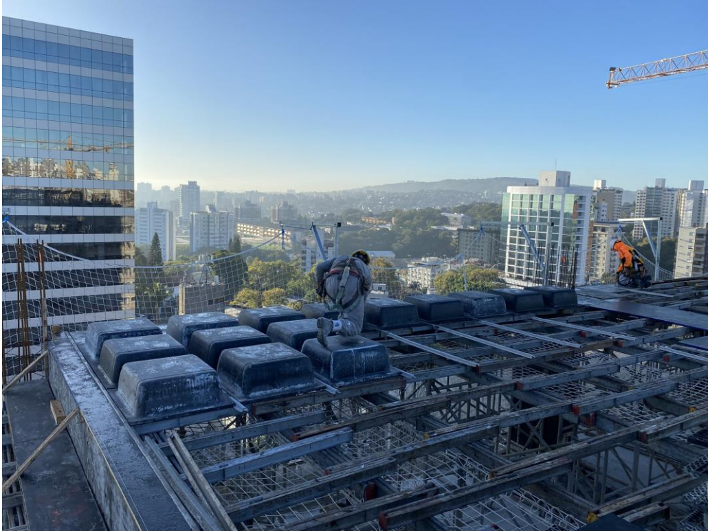
Figura 66 – Início da montagem das cubetas – C1
