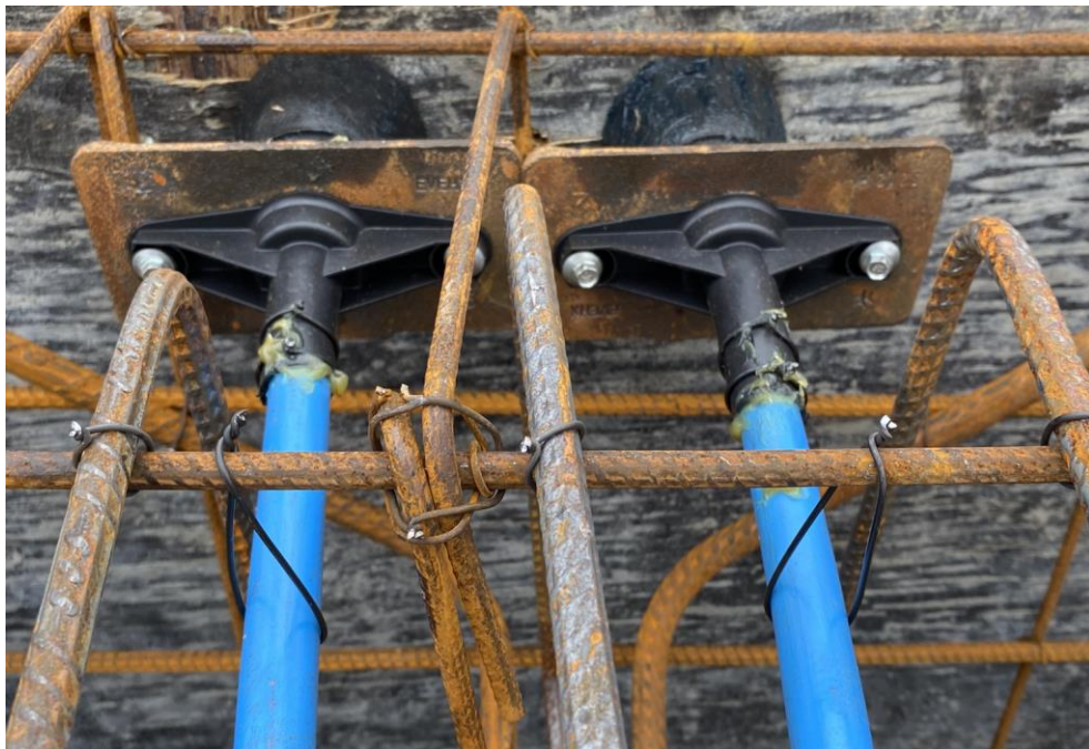
Figura 101 – Fixações adicionais pertinentes à ancoragem ativa
