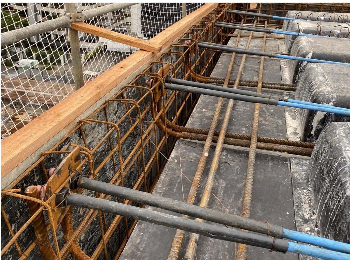
Figura 94 – Arranjo dos cabos na ancoragem passiva após finalização da montagem
