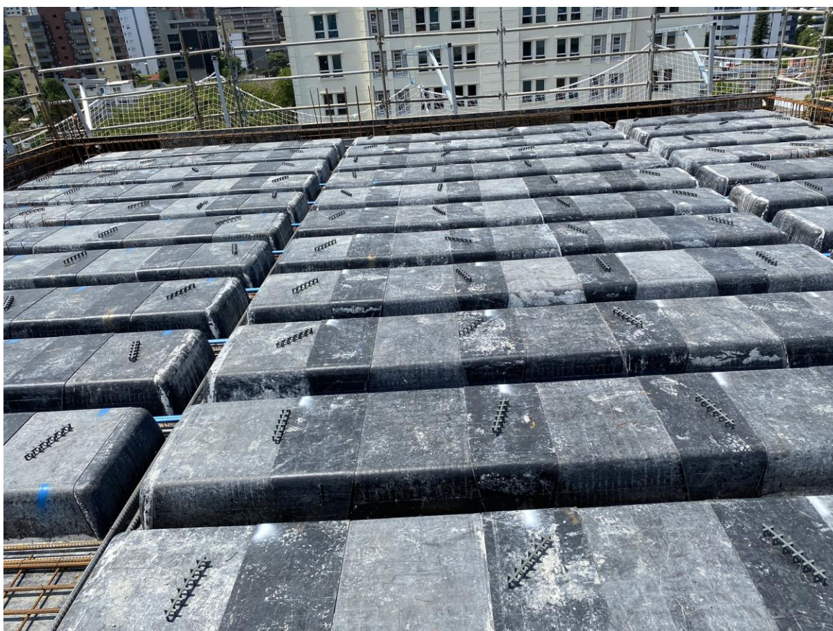
Figura 103 – Posicionamento dos espaçadores nas cubetas
