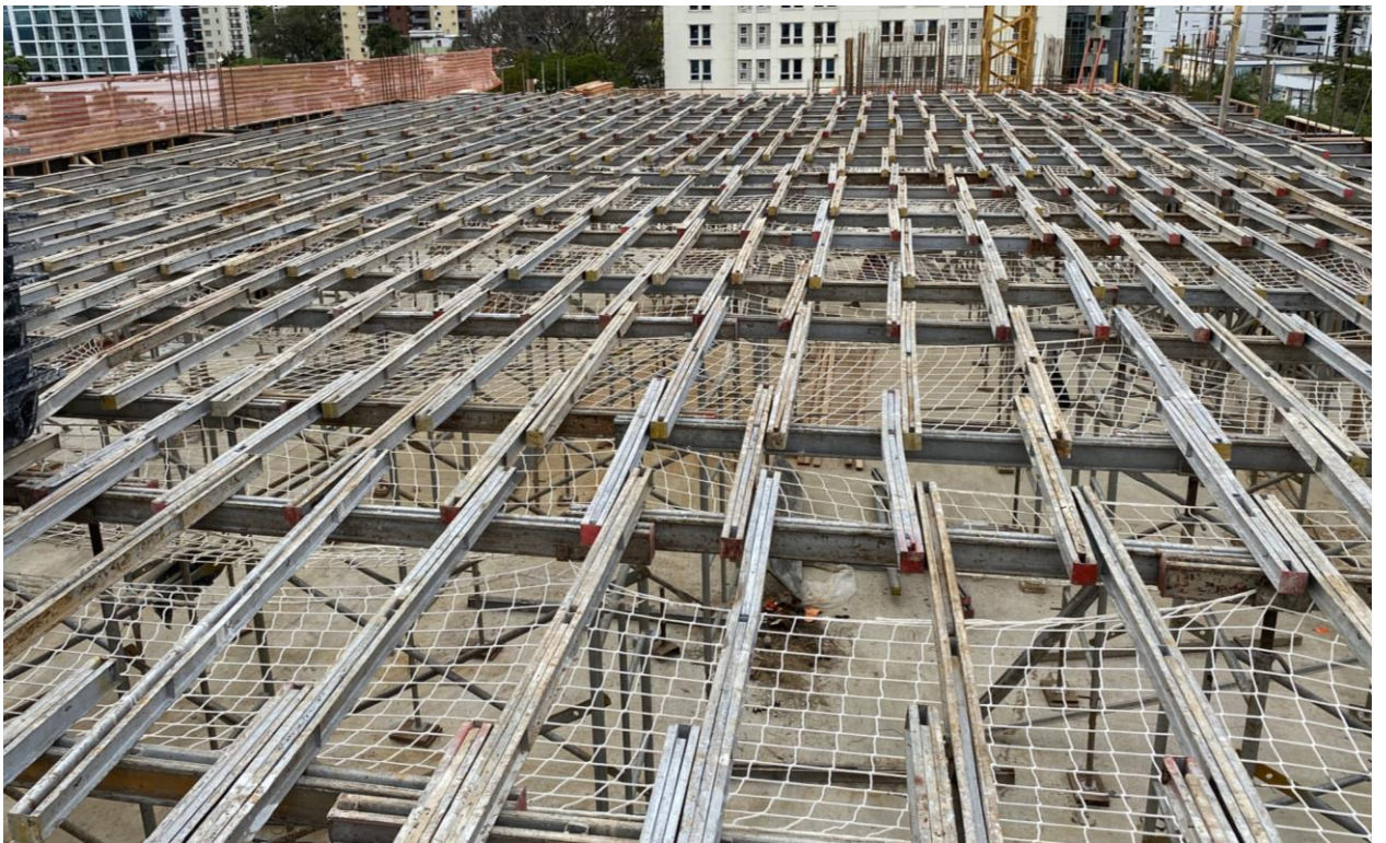
Figura 61 – Vista superior dos barrotes posicionados – C1
