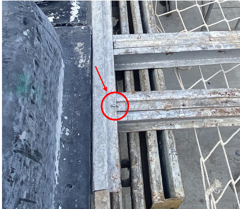
Figura 70 – Exemplificação do travamento das régua nos barrote com pregos
