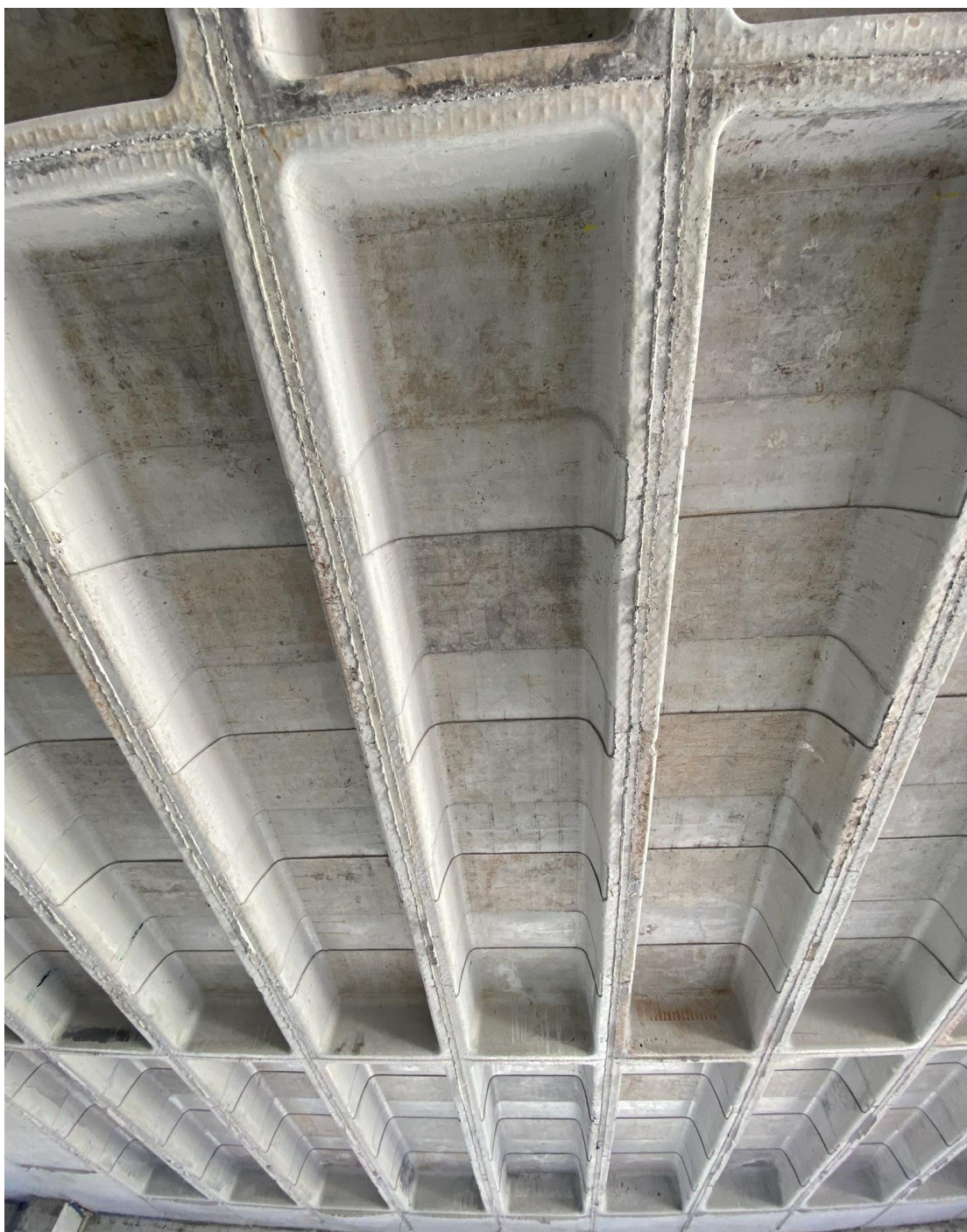
Figura 130 – Vista inferior do arranjo unidirecional em blocos formado pela laje nervurada – Trecho C1
