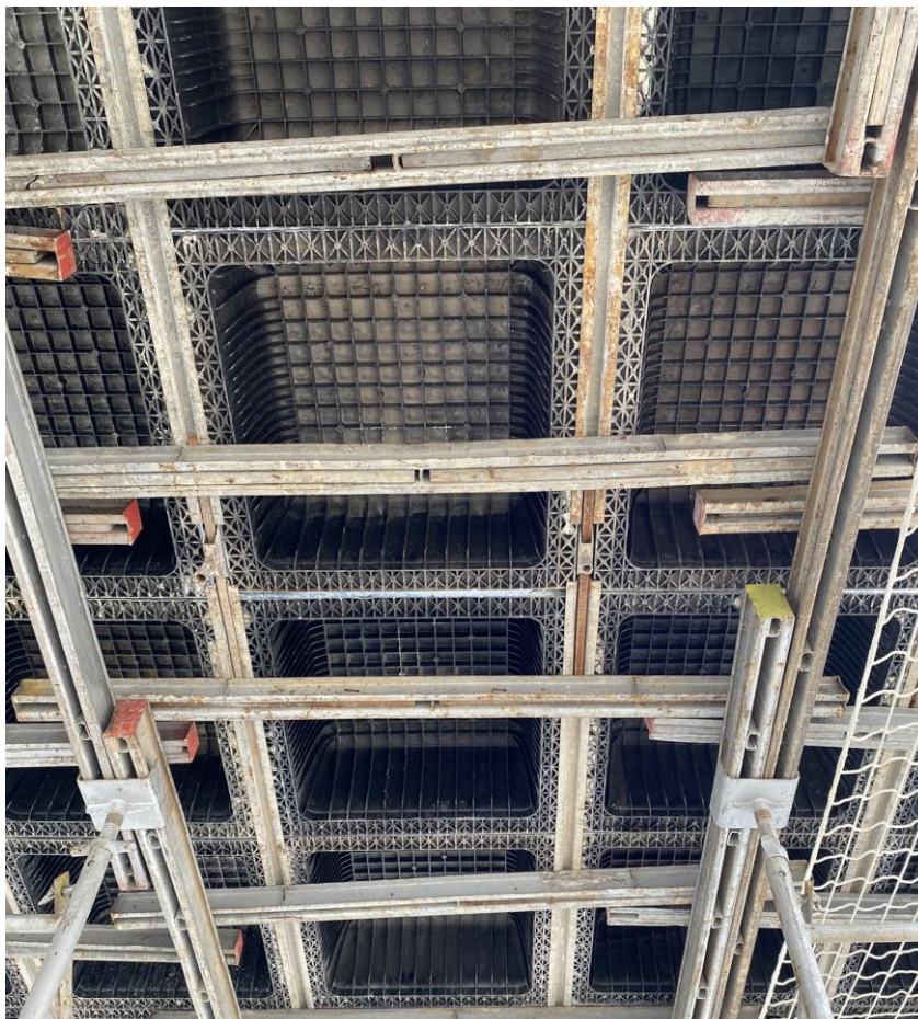
Figura 76 – Vista inferior do sistema de fôrmas após finalização da montagem
