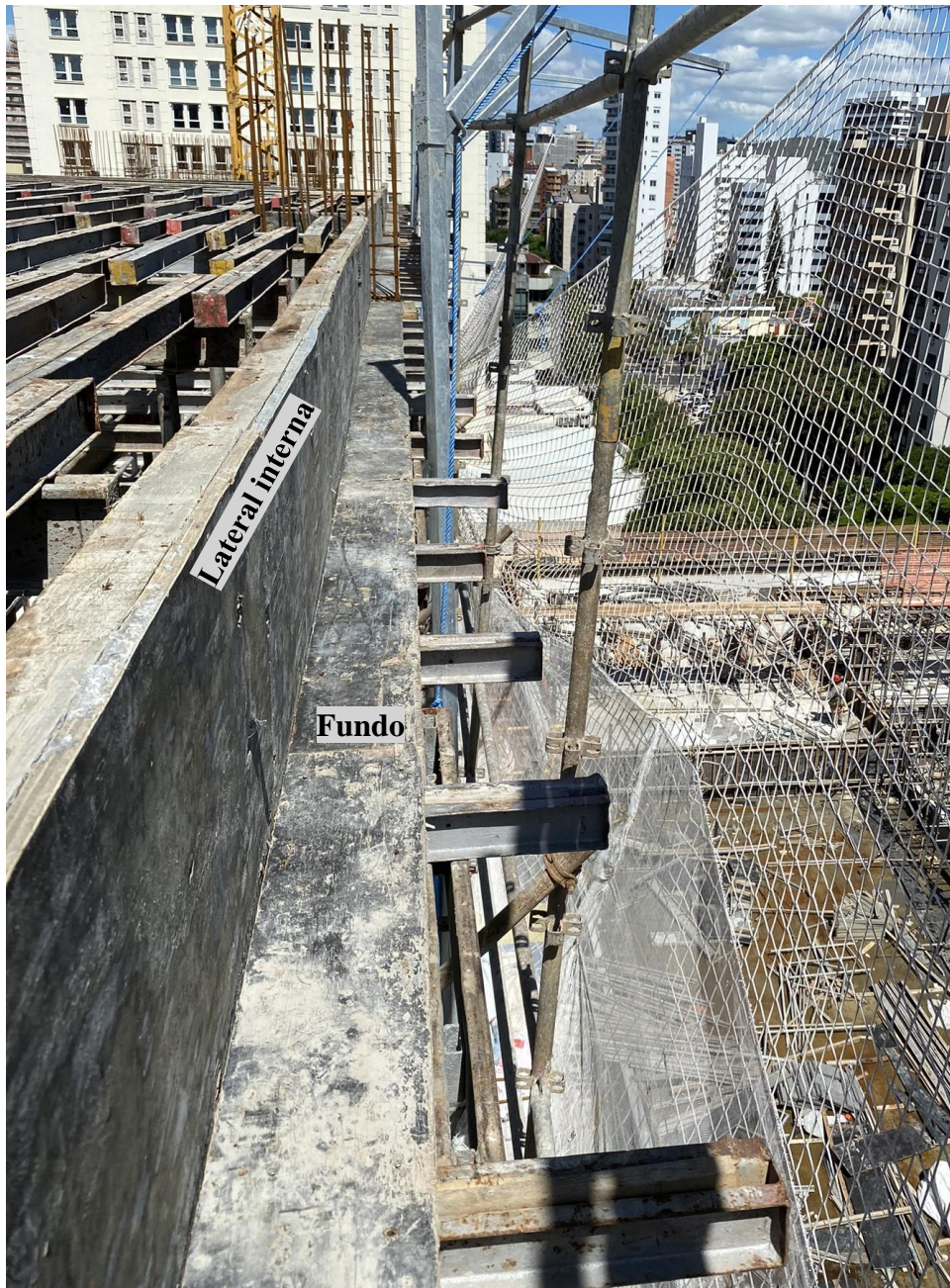
Figura 62 – Montagem do fundo e da lateral interna do molde das vigas – C1
