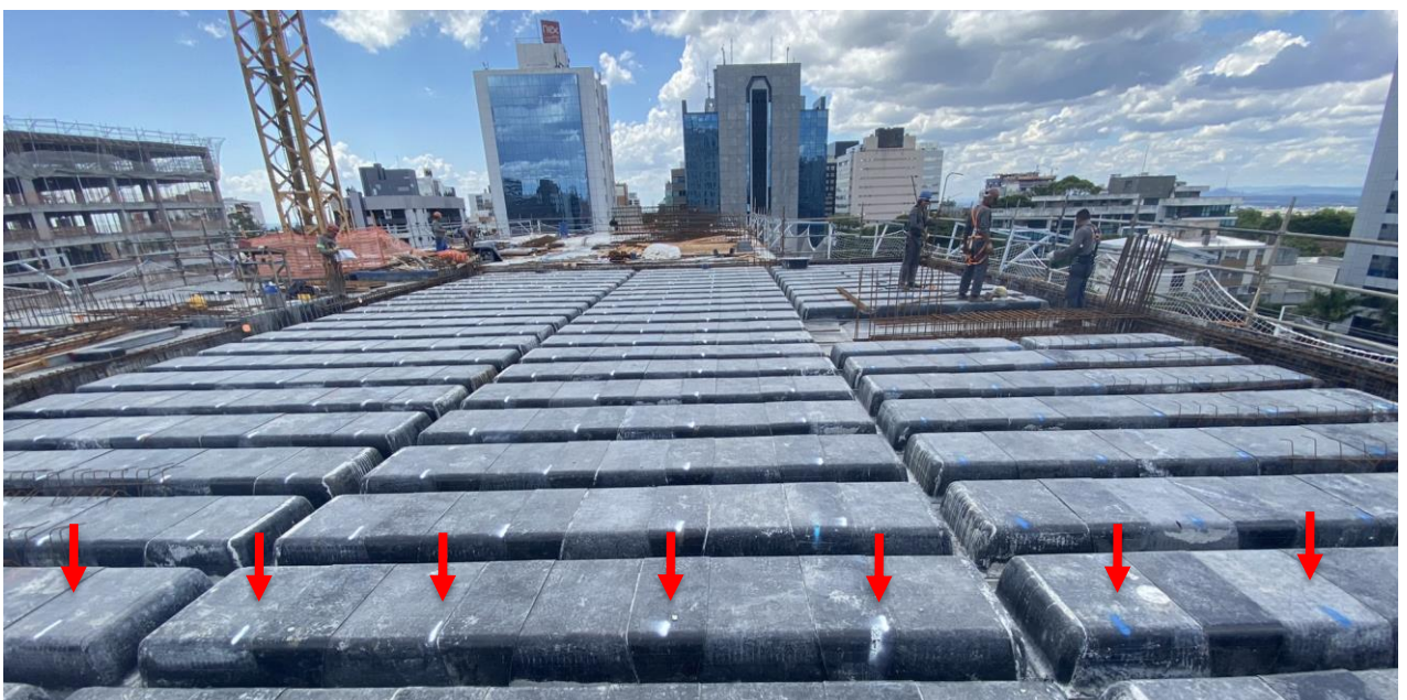
Figura 86 – Marcação horizontal dos suportes de fixação concluída – C2
