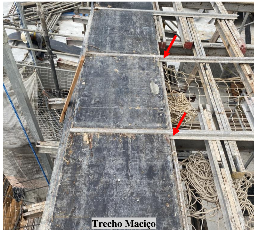
Figura 63 – Montagem do molde do trecho maciço da fachada principal – C1
