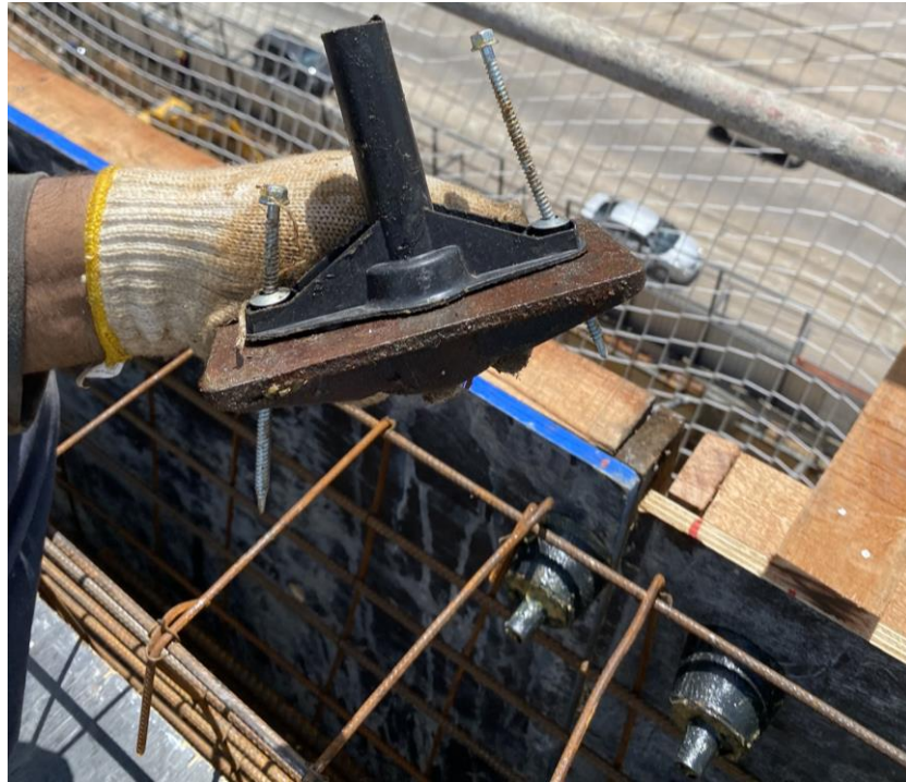
Figura 81 – Montagem da ancoragem ativa – parte 1
