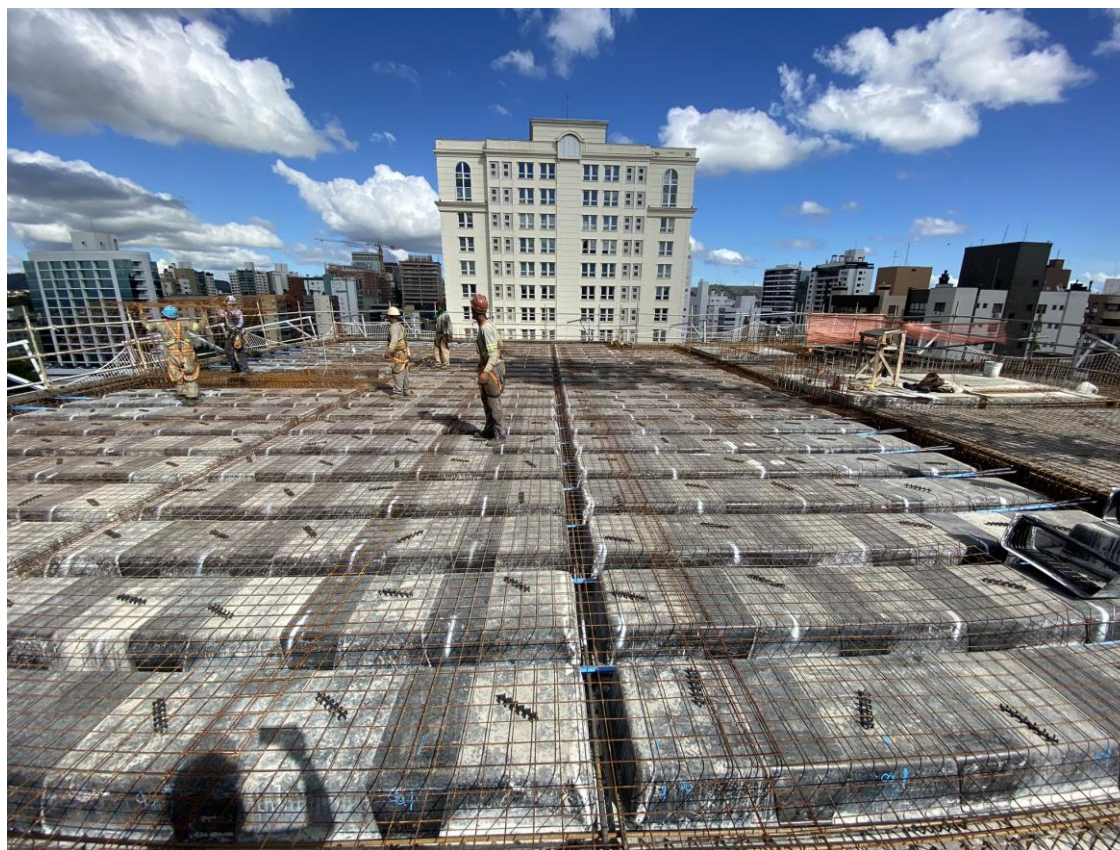
Figura 105 – Finalização do posicionamento das telas de distribuição
