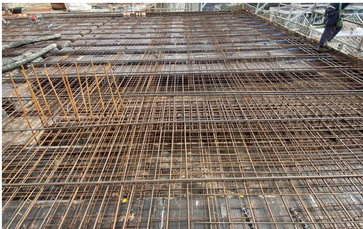
Figura 111 – Configuração final de trecho maciço antes da concretagem – C2
