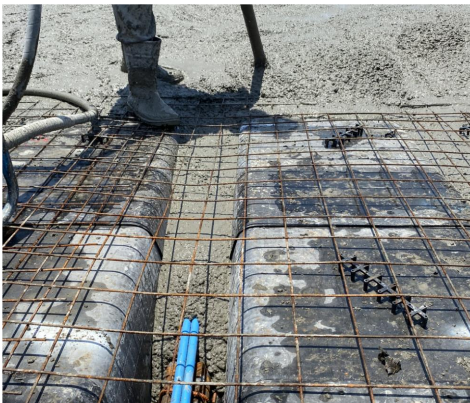
Figura 113 – Concreto preenchendo completamente a nervura após ser adensado
