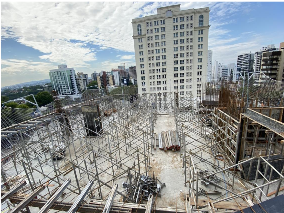
Figura 57 – Montagem do escoramento (torres de andaime) em finalização – C2
