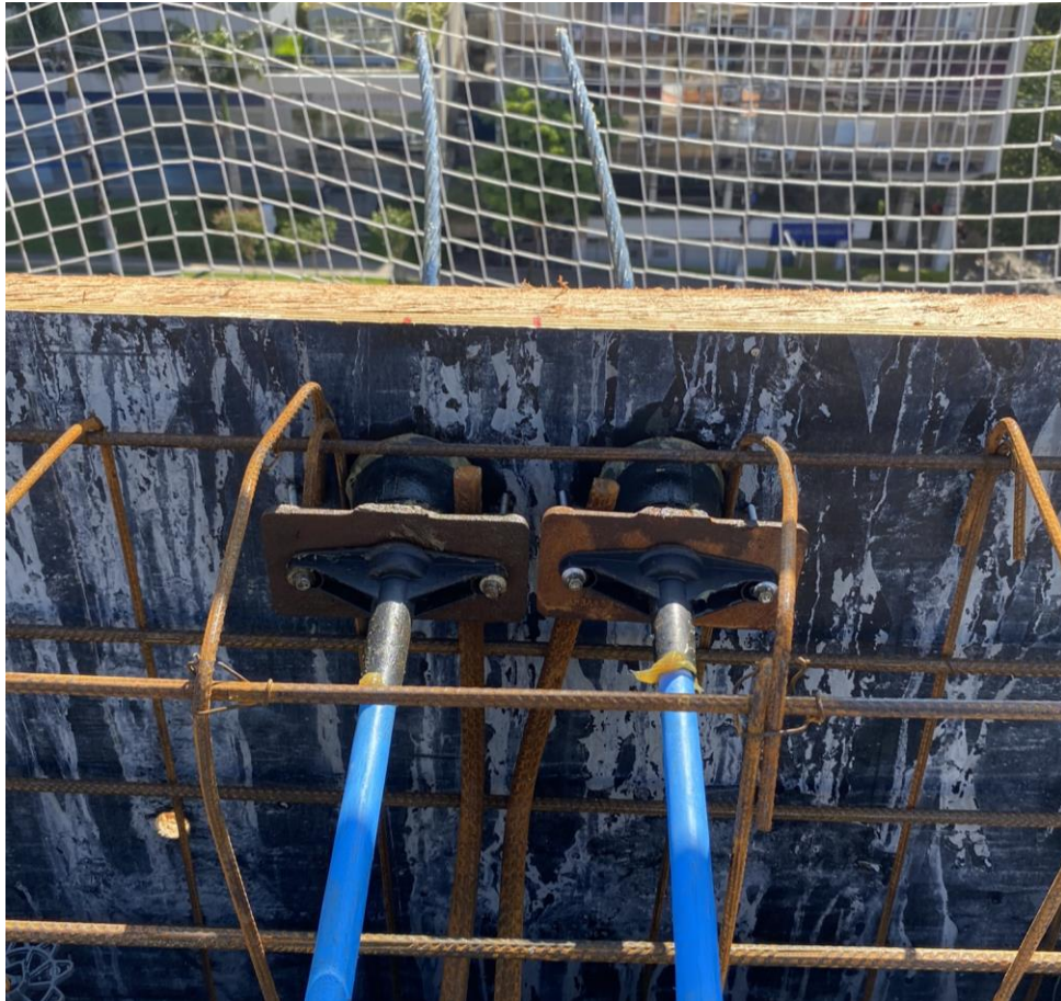
Figura 100 – Resultado da inserção dos cabos na ancoragem ativa
