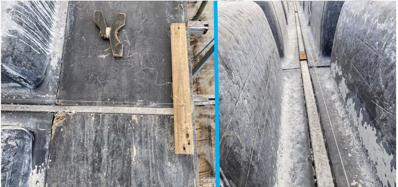
Figura 71 – Linhas mestras responsáveis pelo alinhamento final da laje
