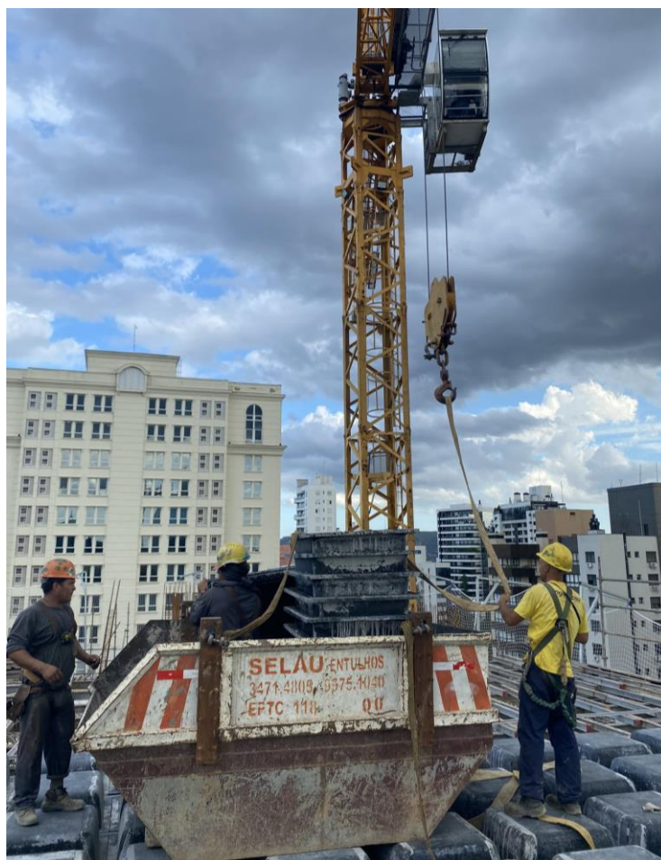
Figura 50 – Cubetas transportadas até a laje em execução
