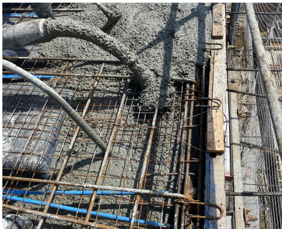
Figura 114 – Concretagem e adensamento em andamento em trecho maciço
