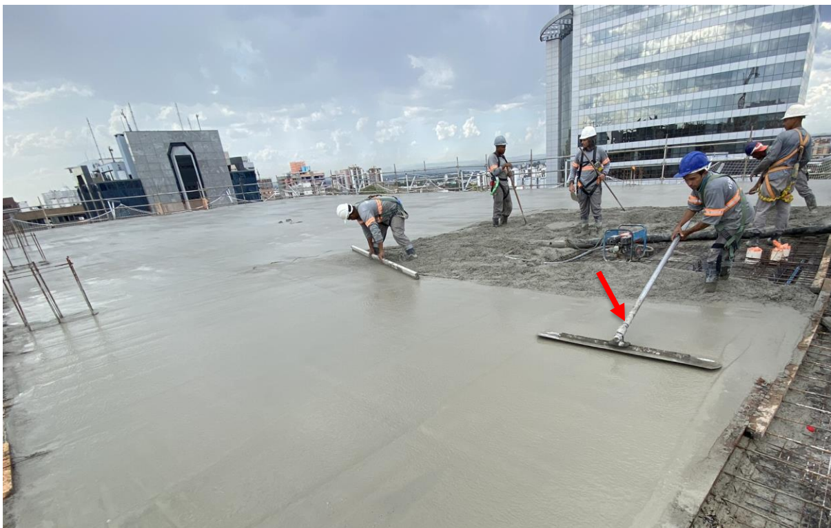
Figura 117 – Acabamento final floateado com o uso de float metálico
