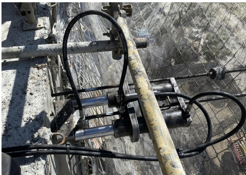
Figura 125 – Macaco hidráulico realizando a protensão dos cabos
