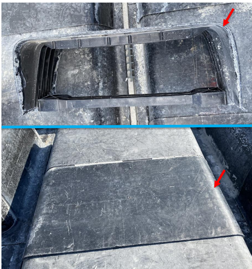
Figura 25 – Exemplificação do tapa nervura utilizado
