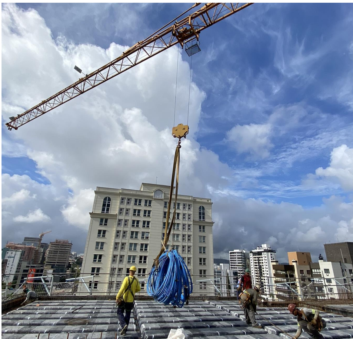
Figura 51 – Cabos de protensão sendo transportados até a laje em execução
