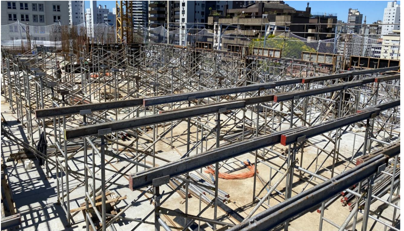
Figura 58 – Posicionamento das madres da laje em andamento – C1
