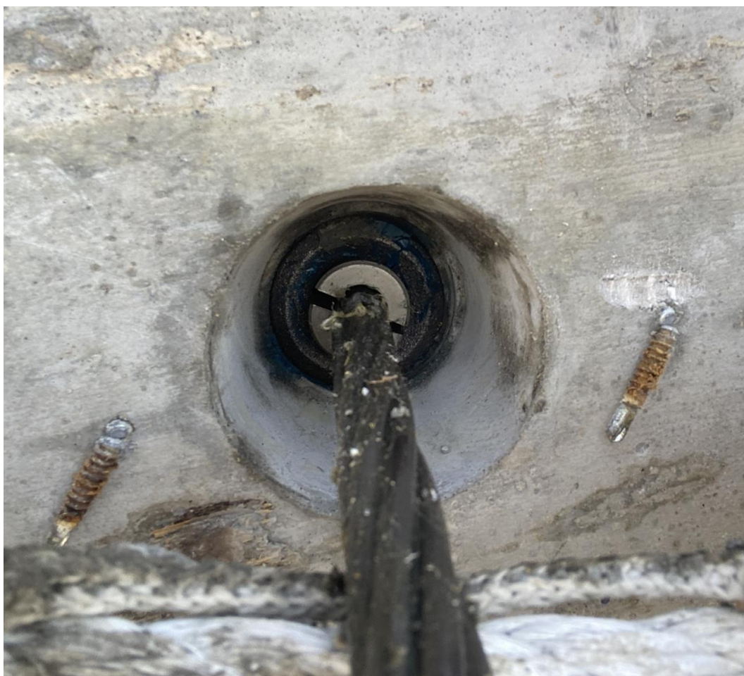
Figura 127 – Cordoalha após ser protendida e encunhada
