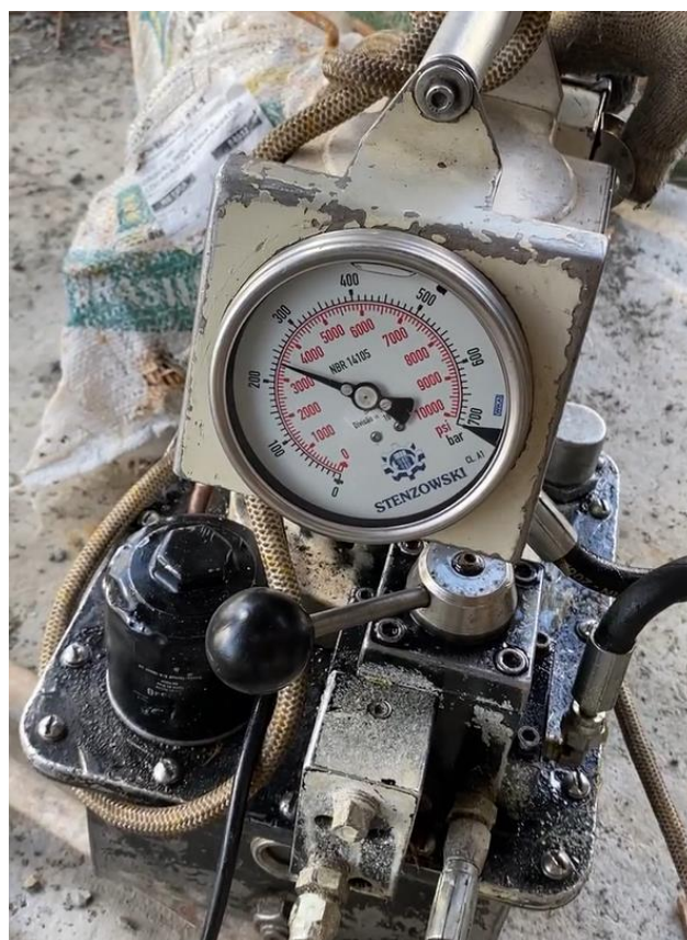
Figura 126 – Vista do manômetro acoplado à bomba do macaco durante a protensão
