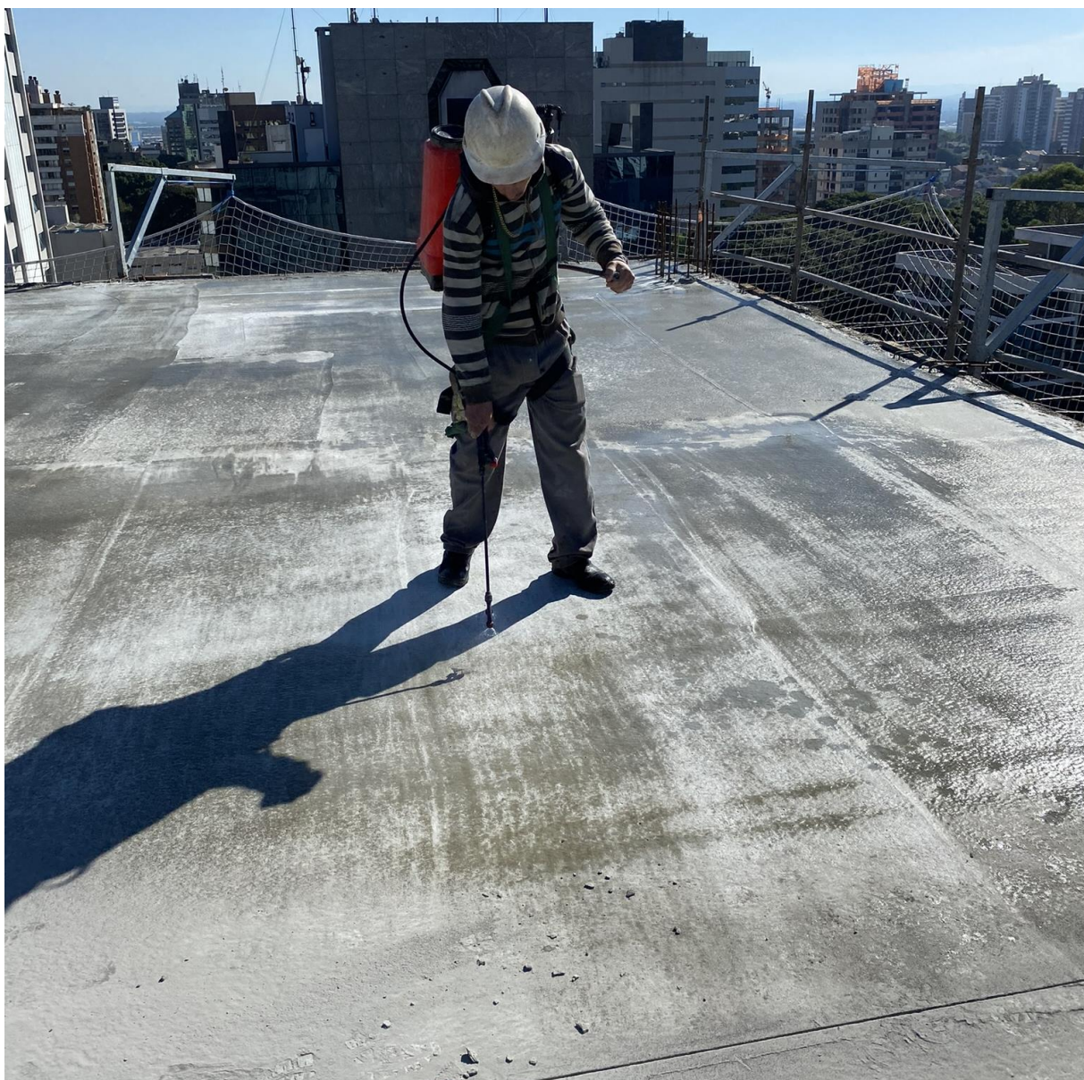
Figura 120 – Aplicação de produto para cura química do concreto
