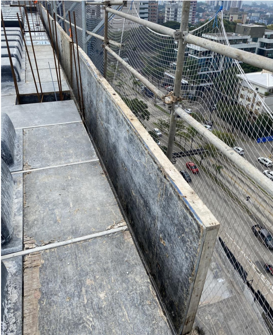
Figura 77 – Posicionamento dos painéis externos das vigas
