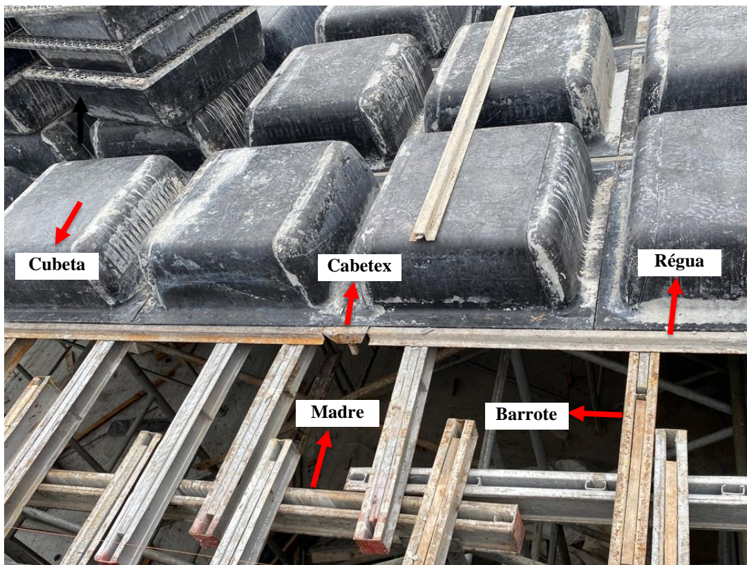
Figura 27 - Sistema de fôrma montado em obra
