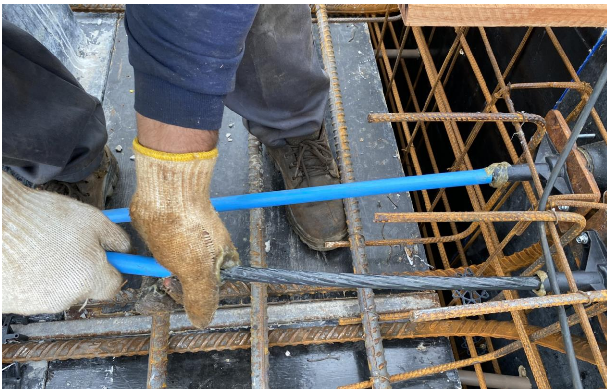
Figura 99 – Inserção das cordoalhas engraxadas expostas nos bicos da ancoragem ativa
