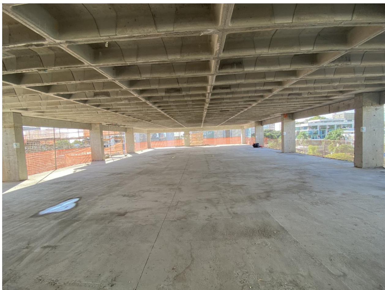
Figura 129 – Pavimento finalizado – Trecho C1
