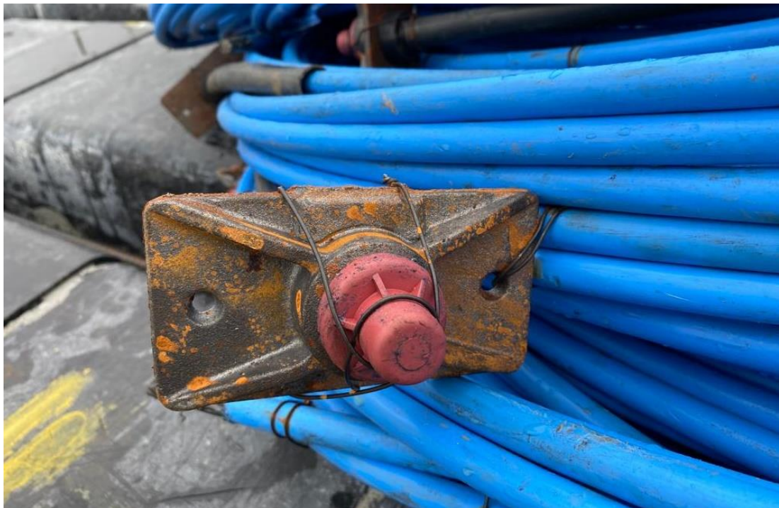
Figura 43 – Exemplo da ancoragem passiva
