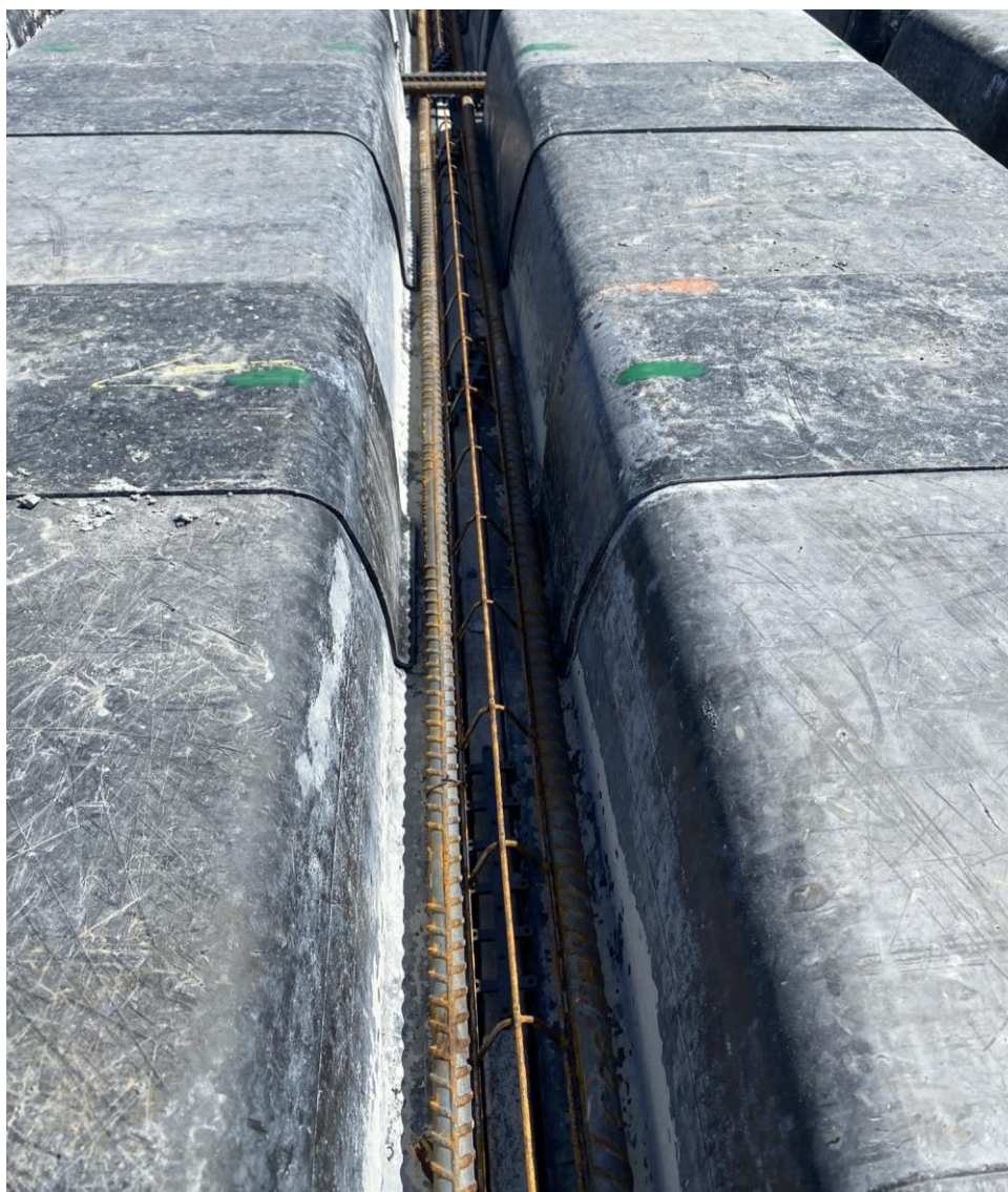
Figura 91 – Posicionamento e fixação dos suportes para os cabos (treliças)
