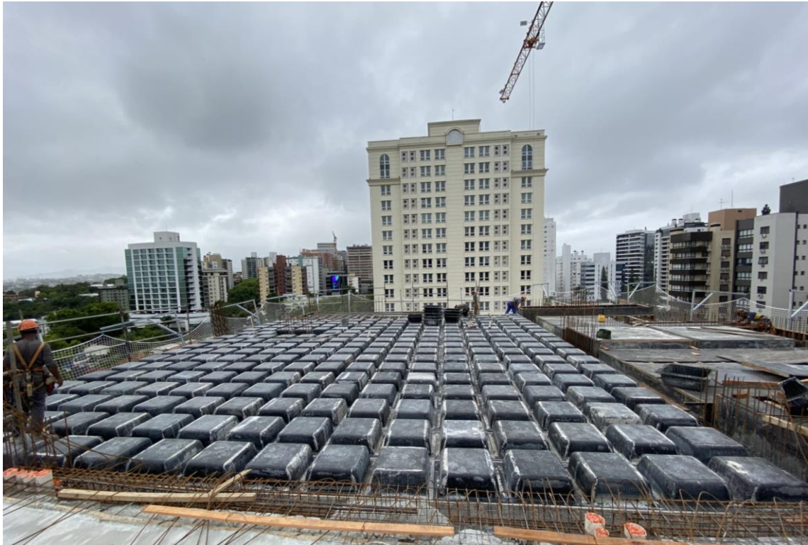
Figura 74 – Montagem das cubetas finalizada – C2
