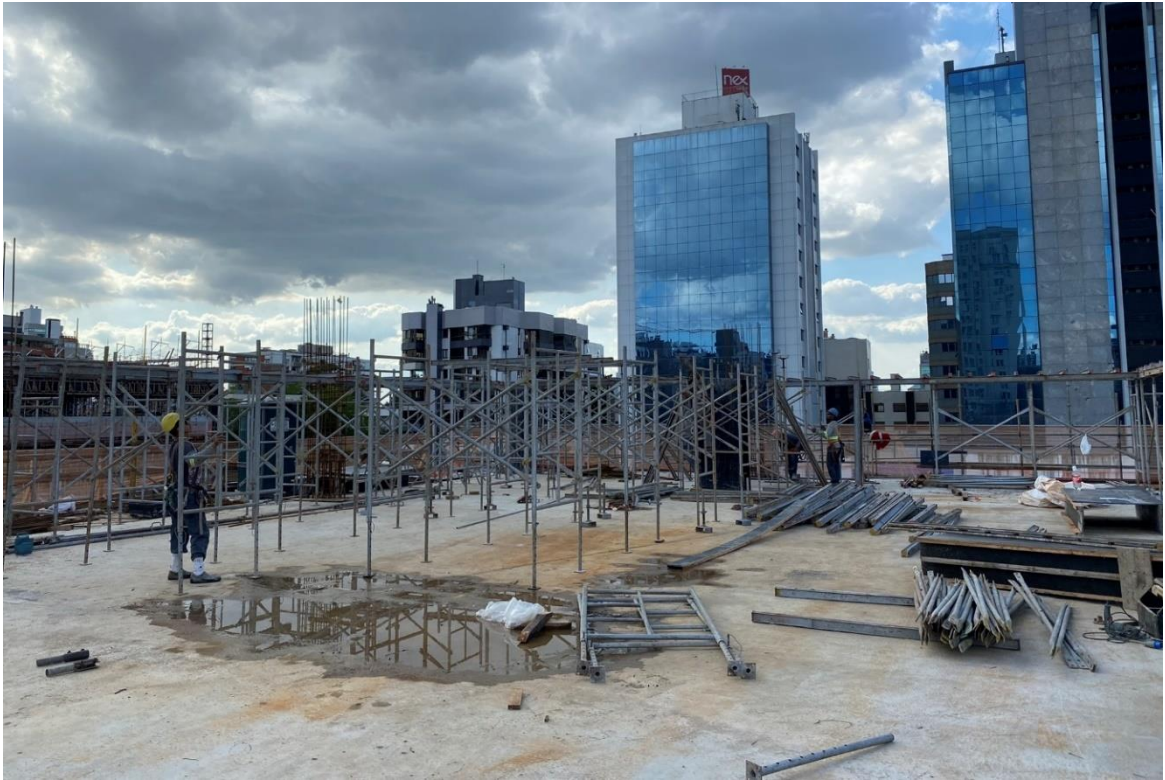
Figura 56 – Início da montagem do escoramento (torres de andaime) da laje – C1
