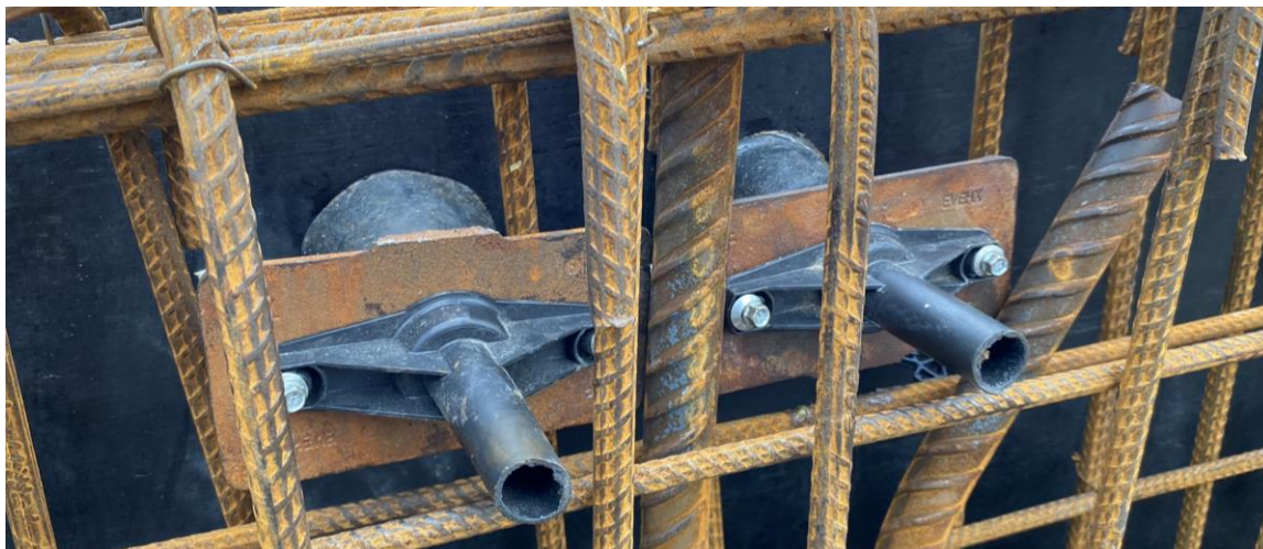
Figura 83 – Resultado final da ancoragem ativa para um par de cabos
