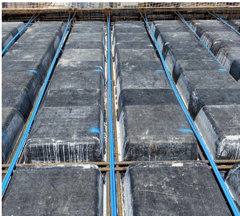
Figura 96 – Vista para ancoragem passiva dos cabos posicionados nas nervuras
