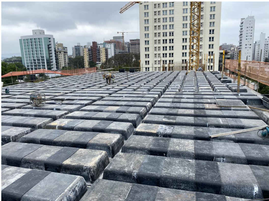
Figura 73 – Posicionamento dos tapa nervuras em execução – C1
