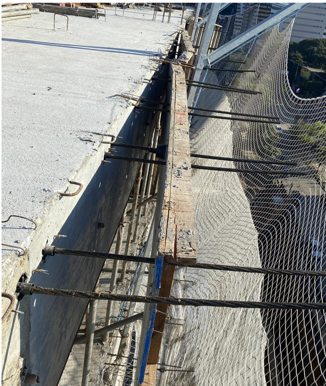
Figura 122 – Desforma dos painéis externos da viga na ancoragem ativa
