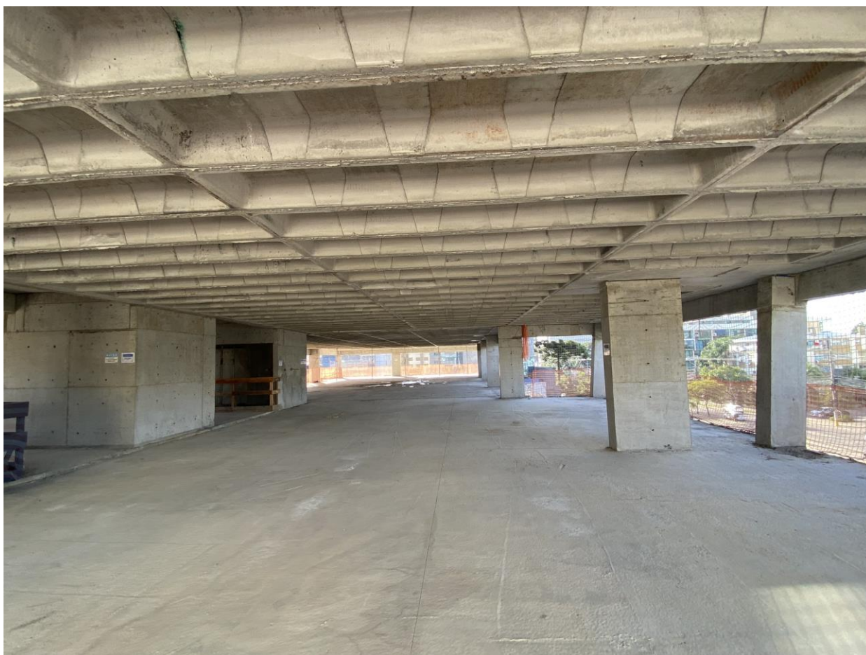
Figura 132 – Pavimento finalizado – Trecho C2 (vista 2)
