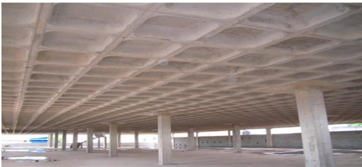
Figura 13 - Exemplo de laje nervurada.
