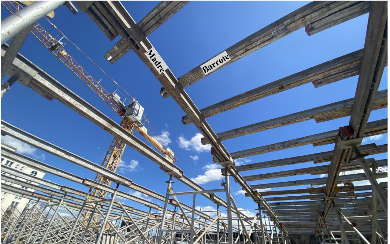
Figura 60 – Vista inferior do posicionamento dos barrotes em andamento – C1
