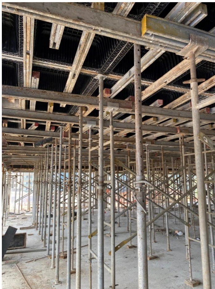
Figura 18 - Exemplo de cimbramento metálico nas lajes nervuradas
