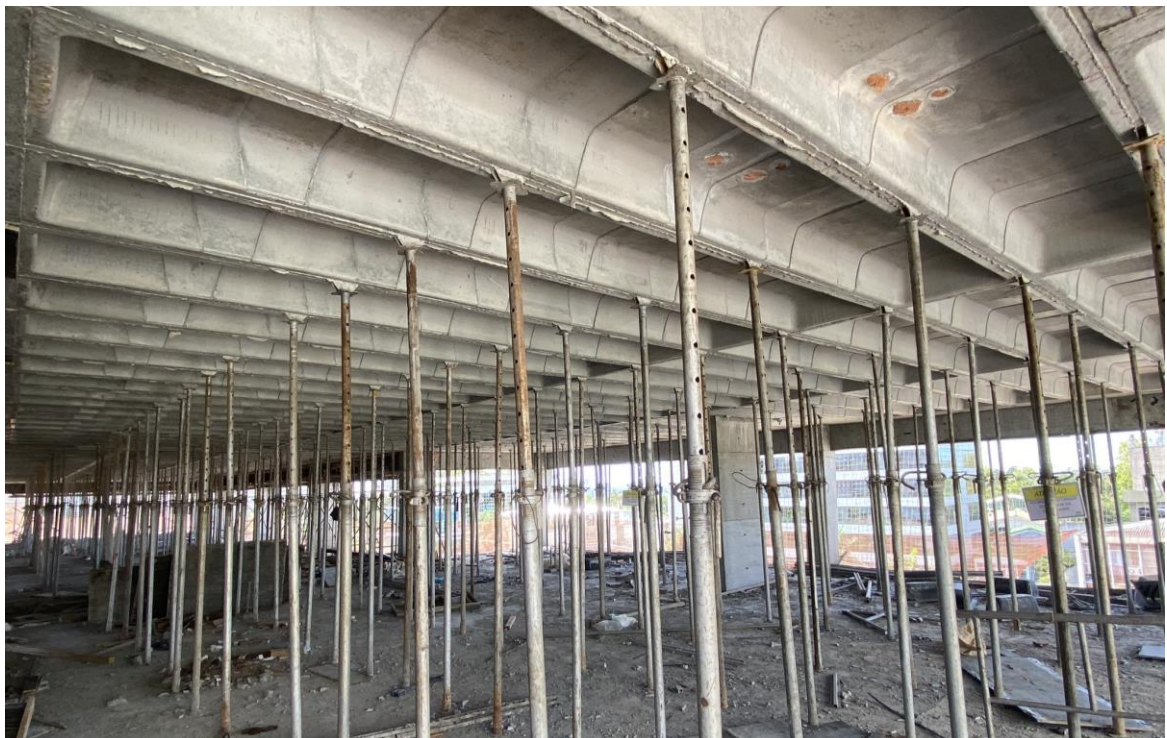
Figura 33 – Exemplo do reescoramento executado in loco – C1
