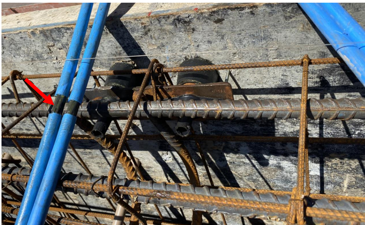
Figura 98 – Corte e remoção da bainha plástica protetora dos cabos
