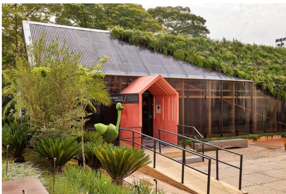
Figura 14: Telhado verde. Fonte: CASACOR, 2023.
