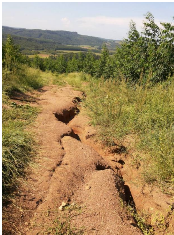
Figura 4 – Estrada entre talhões em horto florestal no município de Barão do Triunfo - RS.
