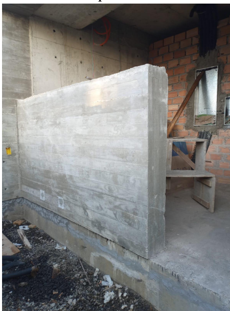
Figura 4: Uso de fitas para o fechamento dos furos
