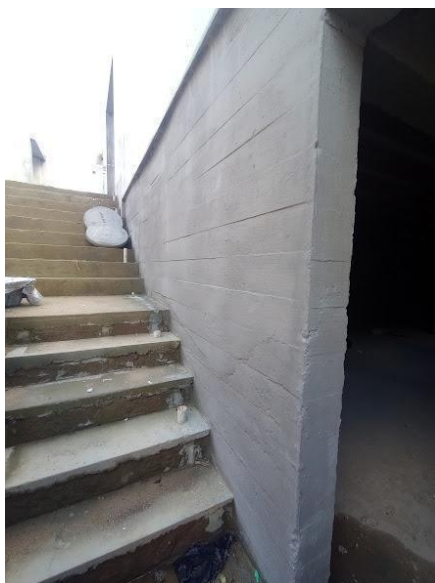
Figura 45 – Junta de concretagem cortina A
