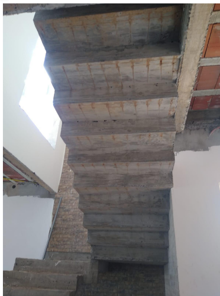
Figura 33 – Mancha devido ao óxido de ferro - Escada B
