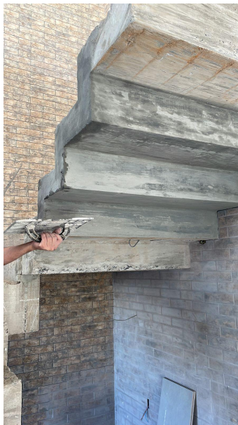
Figura 40 – Recuperação dos vértices da escada B
