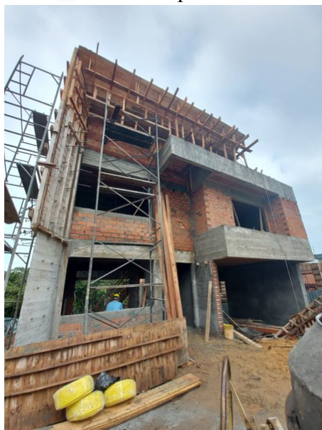
Figura 13 – Fôrmas do pórtico de fachada A
