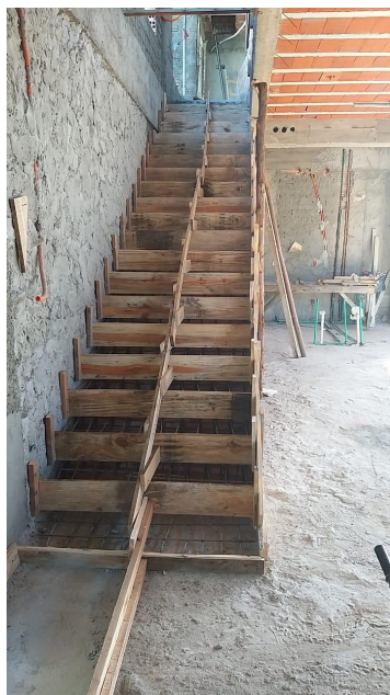
Figura 27 – Sistema de forma de escada reta C
