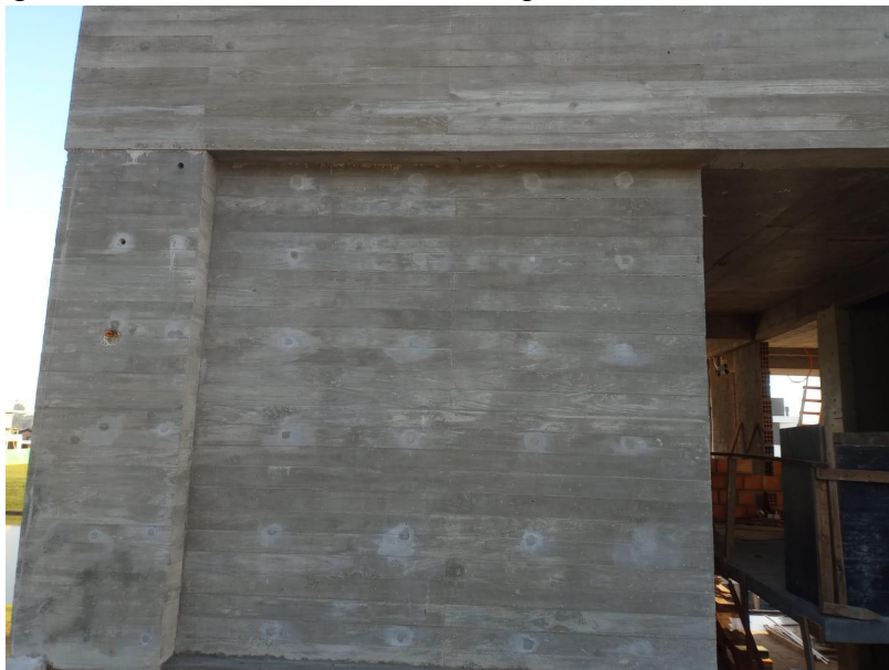
Figura 6 - Resultado do não usar fitas para o fechamento dos furos
