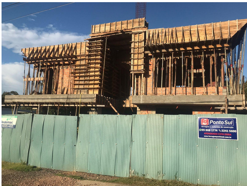
Figura 20 – Sistema de fôrmas pórtico casa E
