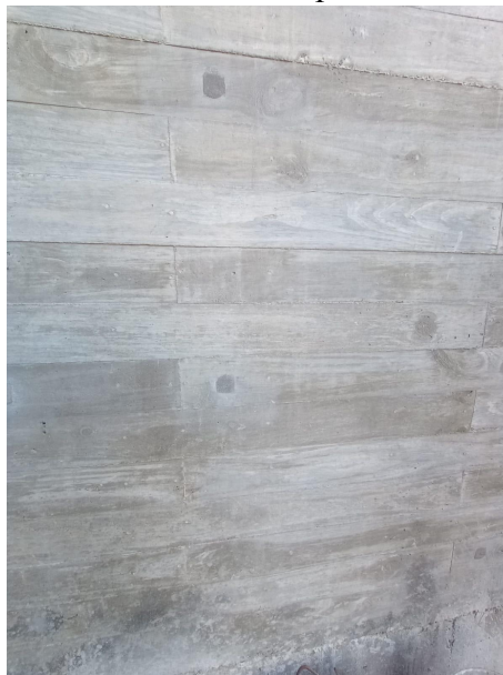
Figura 5 - Resultado do uso de fitas para o fechamento dos furos
