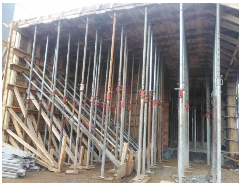
Figura 24 – Sistema de fôrmas - residência C
