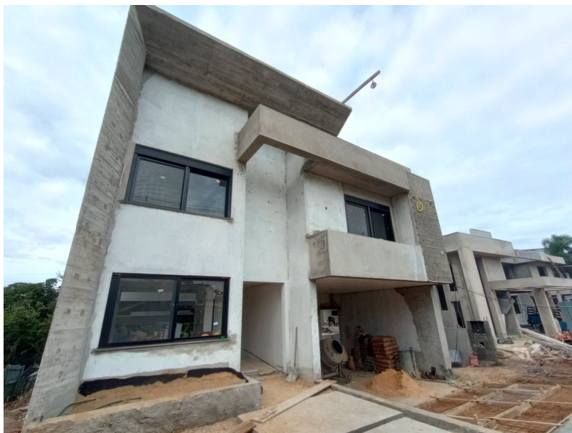
Figura 14 – Desforma pórtilco de fachada A
