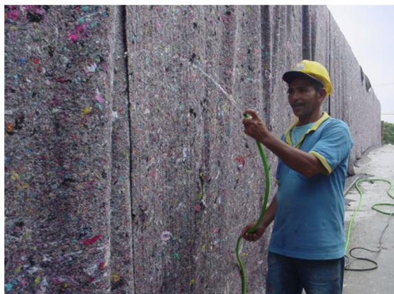
Figura 8 – Processo de cura de paredes de concreto utilizado no Museu Iberê Camargo
