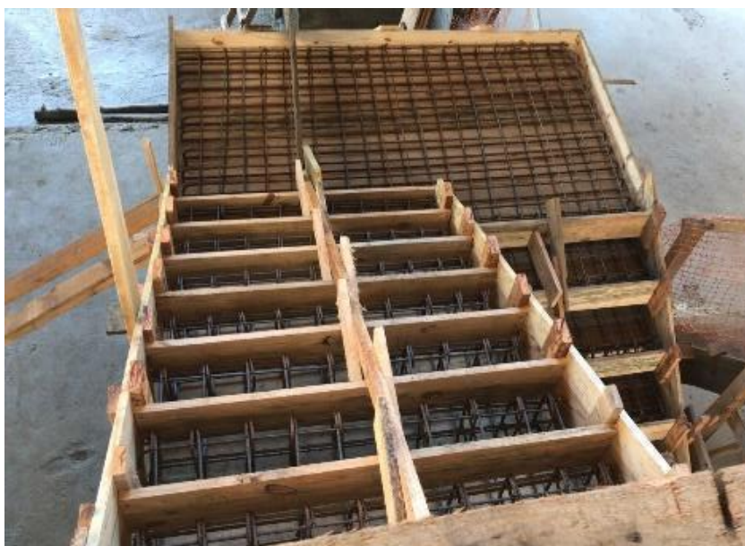
Figura 28 – Sistema de fôrmas - Escada E
