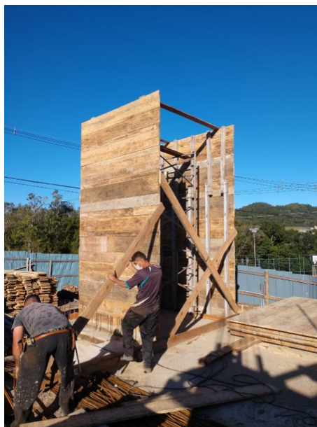
Figura 16 – Fôrmas pórtico fachada D
