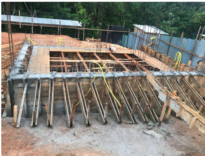
Figura 30 – concretagem cortina A
