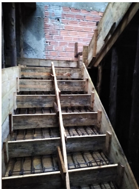
Figura 25 – Sistema de fôrmas -Escada B
