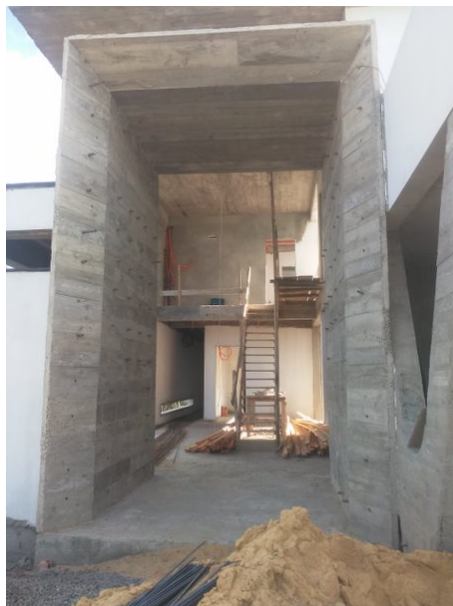
Figura 18 – Desforma pórtico casa D
