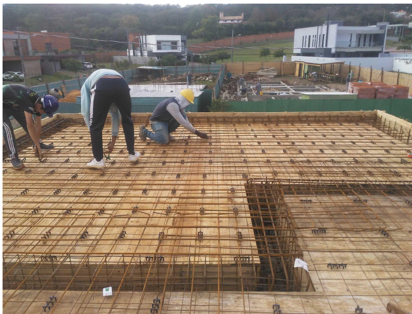
Figura 23 – Fôrmas da laje em concreto aparente com espaçadores plásticos
