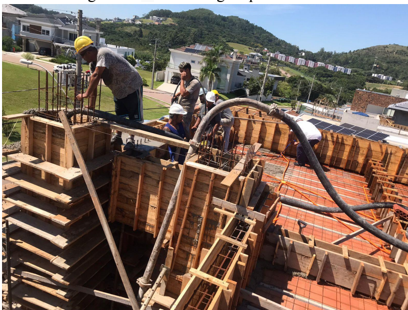
Figura 21 – Concretagem pórtico casa E
