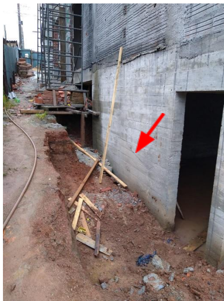
Figura 44 – Junta de concretagem cortina A
