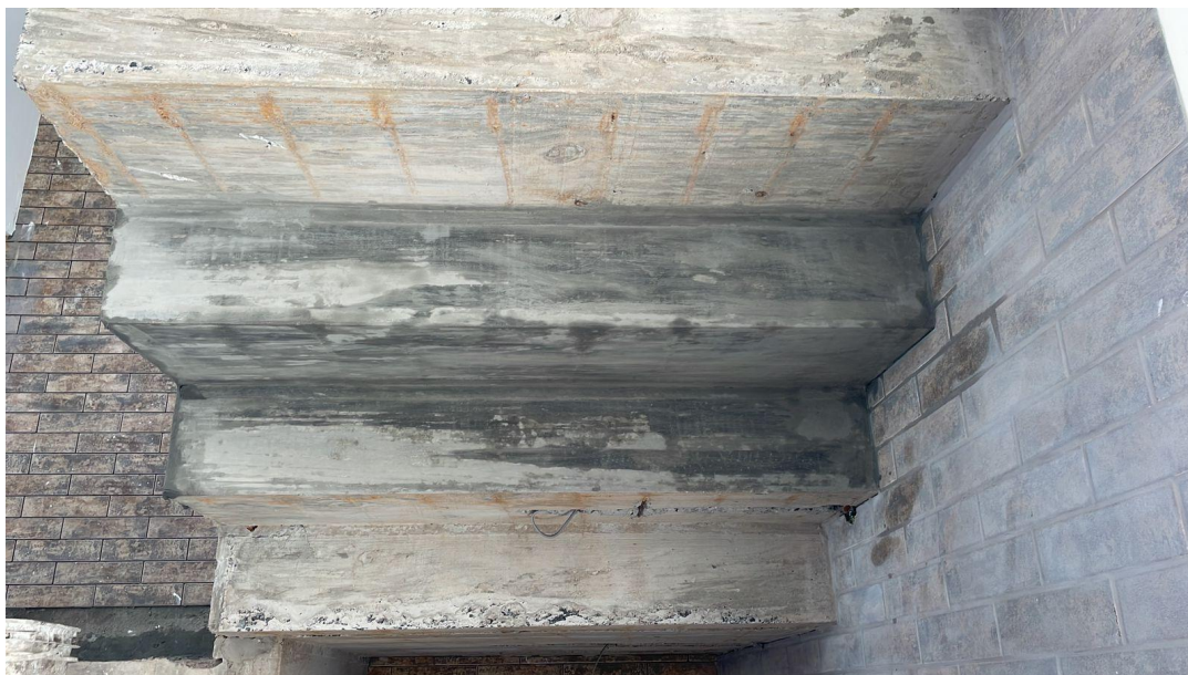
Figura 34 – Recuperação parcial da escada B
