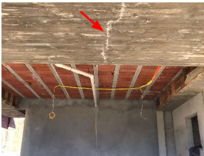
Figura 49 – Eflorescência - fachada E
