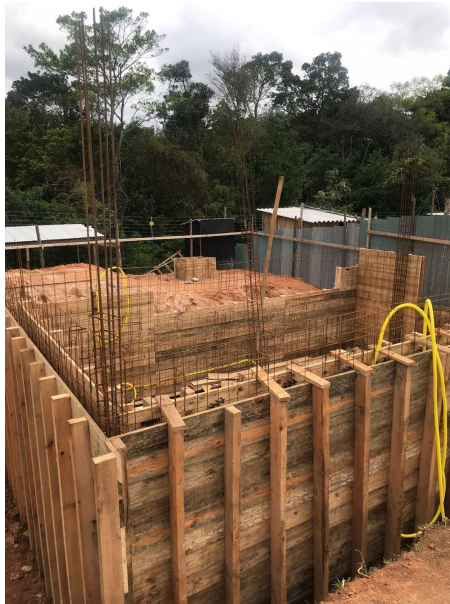
Figura 29 – Sistema de fôrmas cortina A
