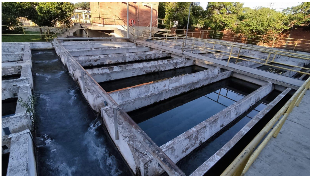
Figura 3 - Decantador lamelar por contato em manto de lodo da ETA
