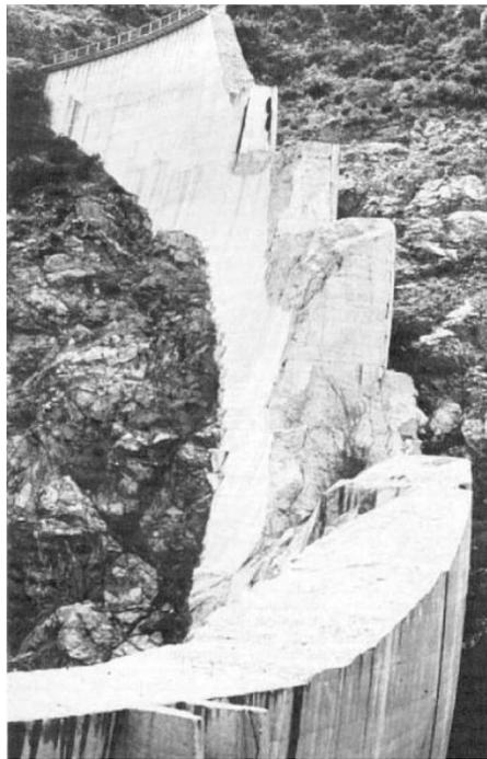
Figura 5 - Seção do vale (ombreira direita) onde se localizava a barragem de Malpasset após o acidente de 1959, Rio Rayran, França (JANSEN, 1983).
