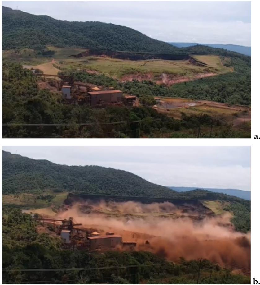
Figura 13 - Barragem de Brumadinho. a. Antes do rompimento; b. Após o rompimento. Disponível em:<<https://www.mg.gov.br/pro-brumadinho/pagina/historico-do-rompimento-das-barragens-da-vale-na-mina-corrego-do-feijao>>. Acesso em: 09 jun. 2022.
