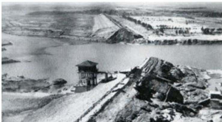
Figura 8 - Barragem de Banqiao após o acidente de 1975, Rio Huai, China (Zhang et al., 2009).
