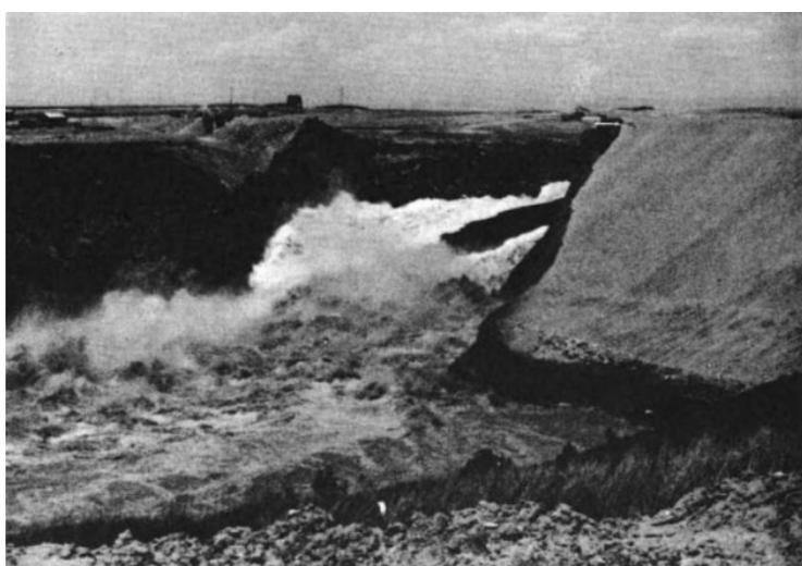
Figura 9 - Barragem Teton após o acidente de 1976, Rio Teton, Estados Unidos (JANSEN, 1983).
