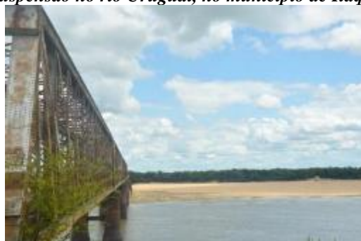
Figura 109. Localidade c: Ponte sobre o rio Ibicuí
