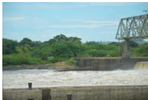
Figura 78. Localidade i: Rio Jacuí, no município de General Câmara, imagem da Eclusa de Amarópolis
