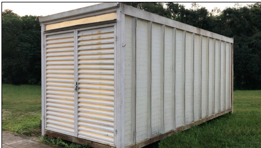
Figura 5.13 – Fotografia externa do contêiner que abriga o simulador solar.
