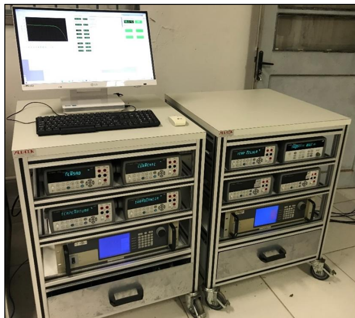
Figura 5.21 – Imagem da instrumentação do sistema de aquisição e tratamento de dados.
