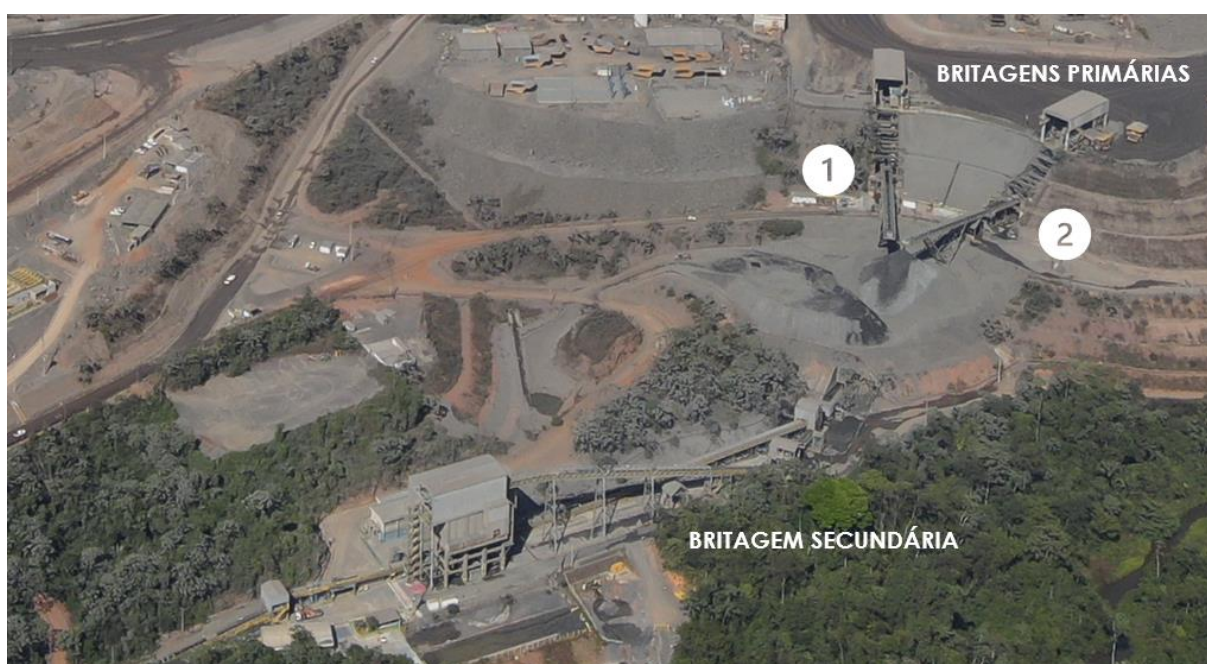
Figura 31 - Vista geral da área de britagem.
