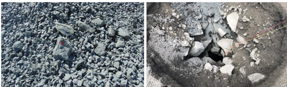
Figura 20 – Material de tamponamento contaminado por blocos (esquerda) e blocos soltos no colar de um furo (direita).
