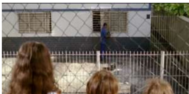
Figura 28 - Homem faz obras no filme O Som ao redor
