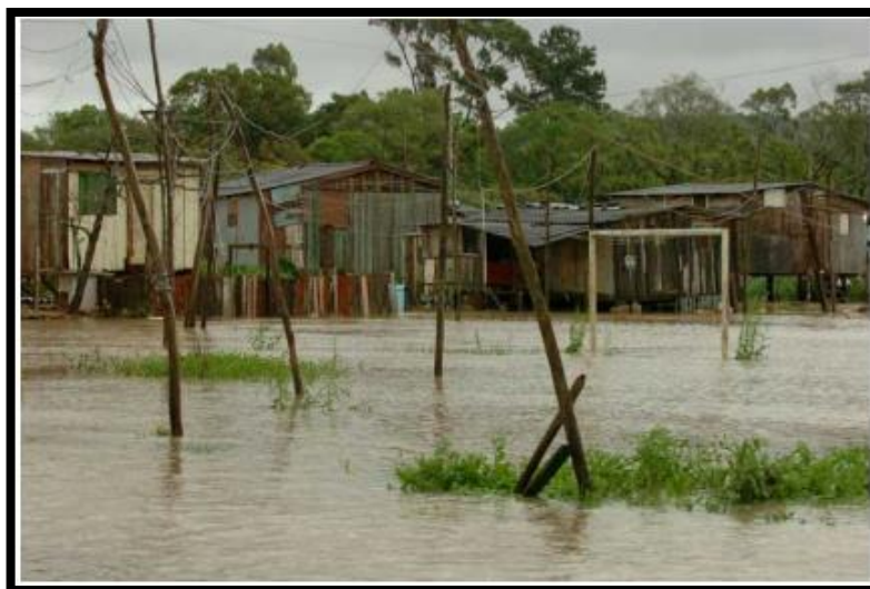
Figura 46 - Área Inundada na Rua Túnel Verde 28/09/2009.
