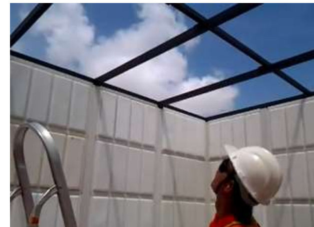
Figura 4: Placas instaladas e guias metálicas para instalação do forro de PVC e travamento da estrutura
