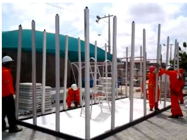
Figura 3: Vista do piso e dos perfis metálicos
