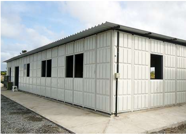
Figura 1 Aberturas para a colocação de esquadrias
