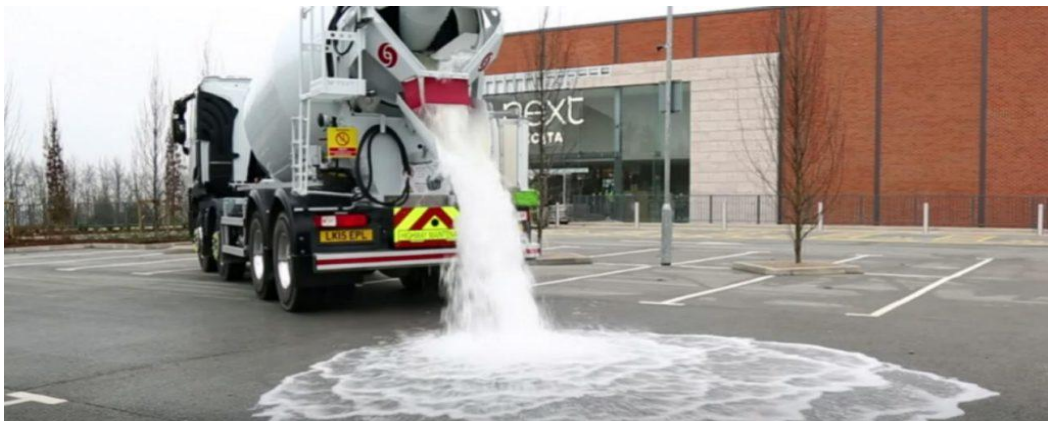
Figura 29. Teste realizado pela Lafarge Tarmac, na Inglaterra, que mostrou a eficiência do asfalto poroso para absorção rápida da água.
