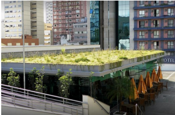
Figura 23. Detalhe de Telhado Verde intensivo em edifício.
