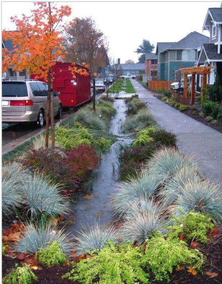
Figura 31. Biovaleta de Infiltração entre o passeio público e a via de carros.
