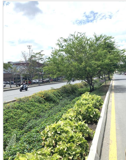
Figura 32. Valeta de Infiltração em canteiro central.
