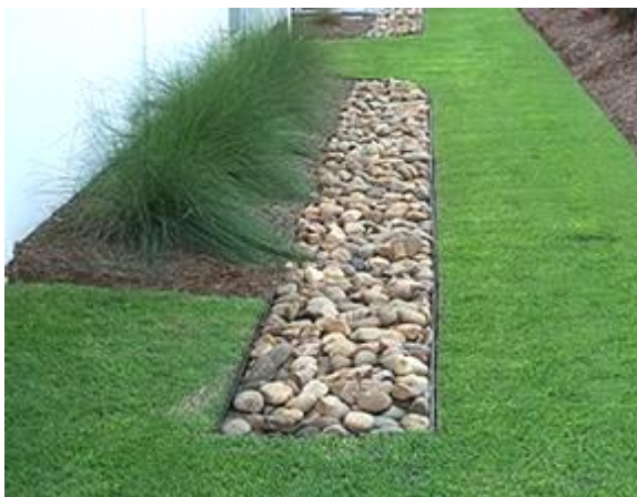
Figura 41. Trincheira de Infiltração em jardim. Fonte: Aquafluxus (2012).
