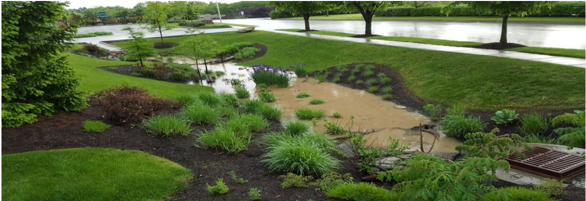
Figura 30. Biovaleta de Infiltração em área pública.
