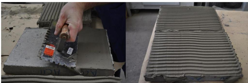
Figura 6: Aplicação da argamassa colante, utilizada como chapisco
