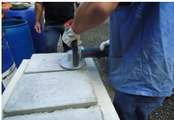
Figura 7: Lixando o substrato (Fonte: Próprio autor).
