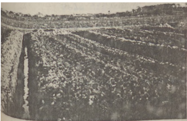
3 - Trincheiras para instalação de drenos fechados com brita
