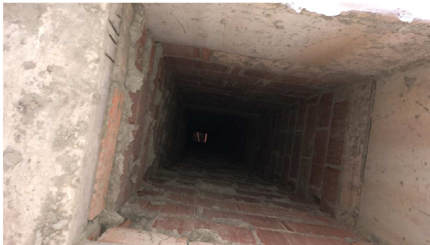
Figura 15: Shaft executado em todos os pavimentos
