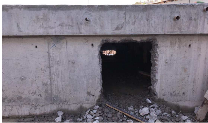
Figura 24: Alteração na estrutura original da piscina para criação de acesso à galeria.
