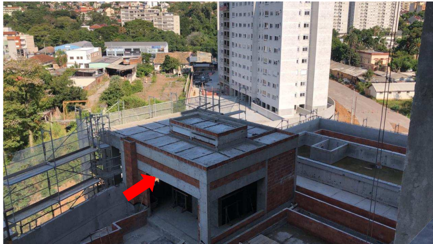
Figura 25: Adequação de estrutura para instalação de esquadria de alumínio e apoio da alvenaria superior
