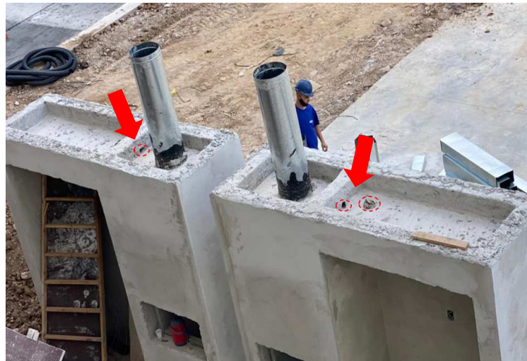
Figura 41: Cobertura dos quiosques com ralos e drenos executados
