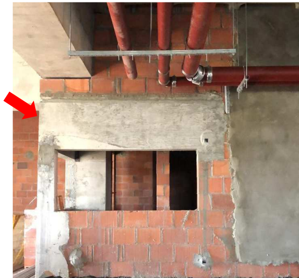
Figura 21: Adequação vão para esquadria blindada
