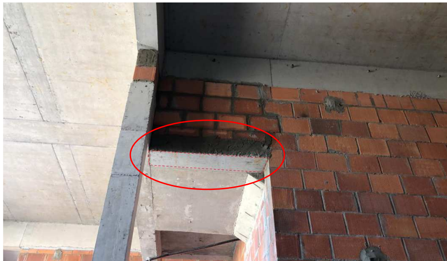
Figura 27: Complemento de patamar executado e alvenaria apoiada no mesmo
