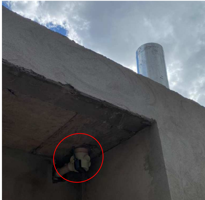
Figura 42: Vista inferior do ralo do quiosque
