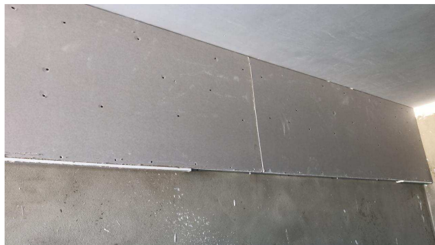
Figura 29: Solução adotada para esconder as tubulações elétricas
