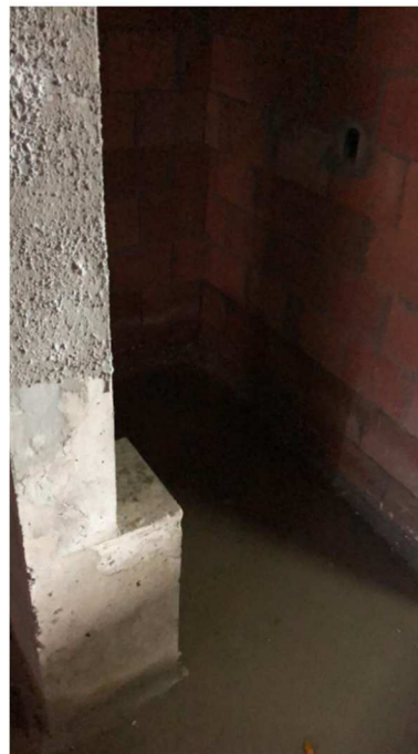
Figura 20: Ajuste feito em pilar que avançava sobre a área de cadeirante
