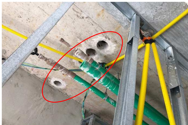
Figura 31: Furação para passagem de instalações hidráulicas do reservatório superior reposicionada na projeção do banheiro da unidade 1311
