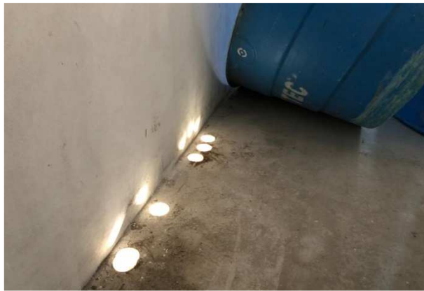
Figura 30: Furação original para passagem de instalações hidráulicas do reservatório superior na projeção da sala da unidade 1311
