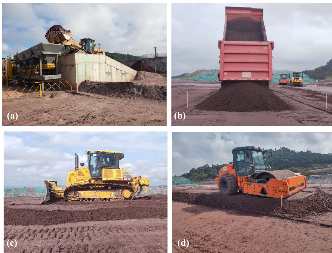
Figura 3.11 – Etapas da execução das pilhas experimentais de misturas de rejeito e cimento Portland CPV – ARI: (a) abastecimento da usina de solos; (b) descarregamento da mistura; (c) espalhamento e nivelamento da camada; (d) compactação da camada
