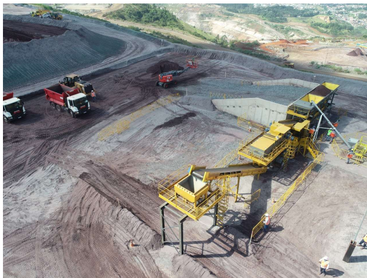
Figura 3.10 – Imagem da usina de mistura e dosagem de solos utilizado na construção da pilha
