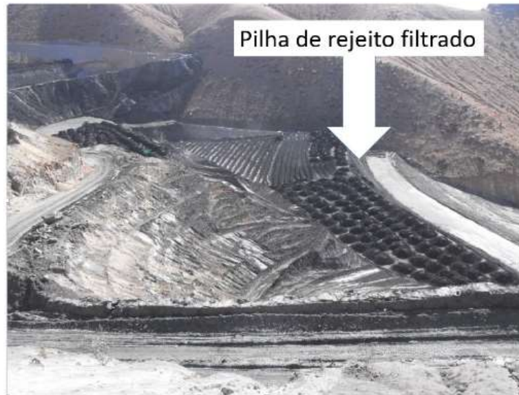
Figura 2.5 – Exemplo de pilha de rejeito filtrado (ALVES, 2020)
