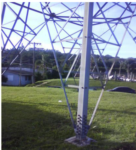
Figura 1: Torre de Transmissão de energia. Figura 2: Pontos de contato dos coupons à torre.
