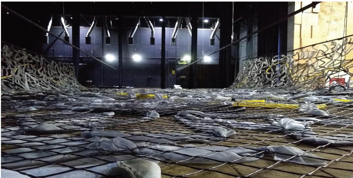
FIGURA 8: Estrutura cenográfica sendo fixada na primeira e na última vara cênica, por meio de fios de nylon pretos. Fonte: Stefanello Studio.
