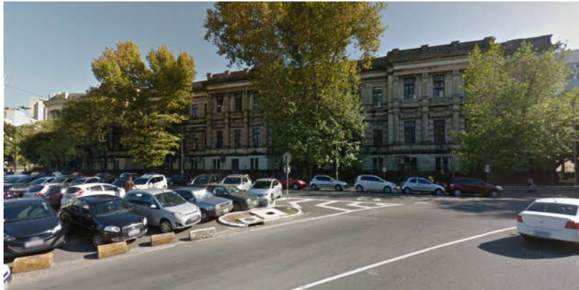
Figura 20- Fachada sul do prédio do ICBS
