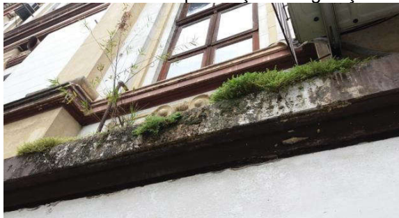
Figura 6- Manchamento e presença de vegetação
