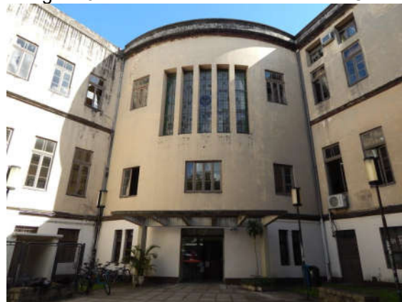
Figura 9- Fachada leste do Prédio do ICBS
