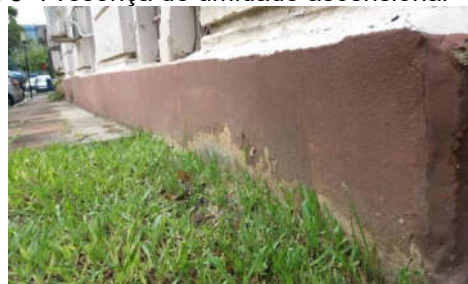
Figura 4- Formação de bolhas e descolamento de pintura Figura 5- Presença de umidade ascensional
