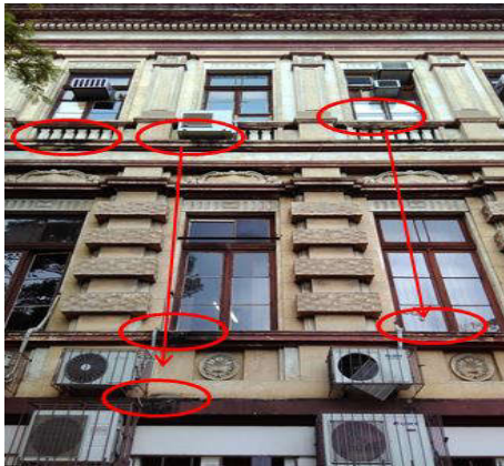
Figura 18- Fissuras decorrentes de problemas estruturais
