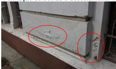
Figura 4- Formação de bolhas e descolamento de pintura Figura 5- Presença de umidade ascensional
