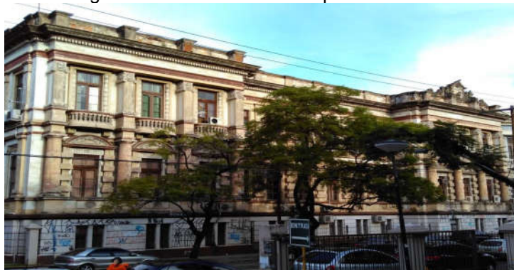
Figura 13- Fachada oeste do prédio do ICBS
