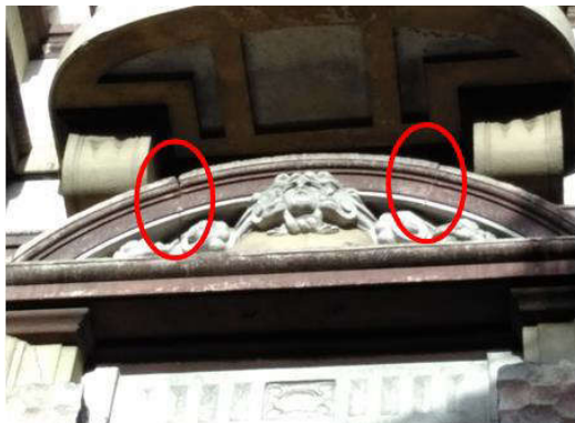
Figura 18- Fissuras decorrentes de problemas estruturais
