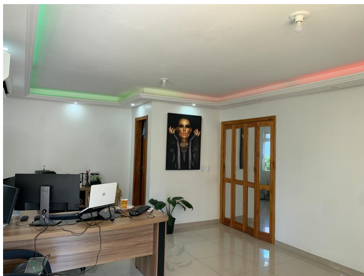
Figura 19 - Visão ampla do forro de gesso na sala
