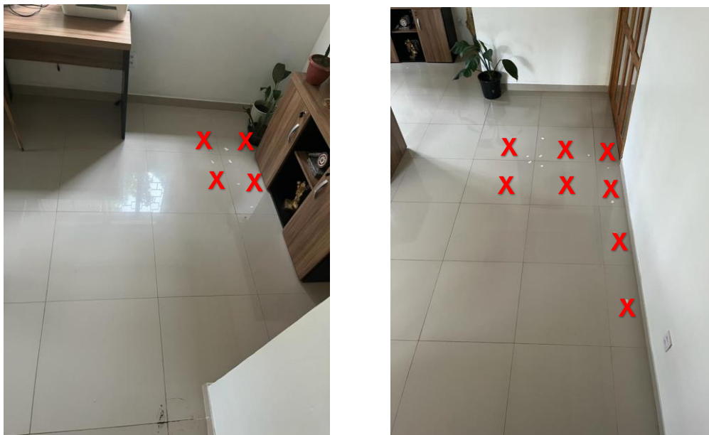
Figura 12 – demarcação das peças ocas na região da sala
