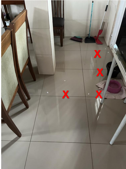
Figura 17 – Detalhes das peças ocas na cozinha
