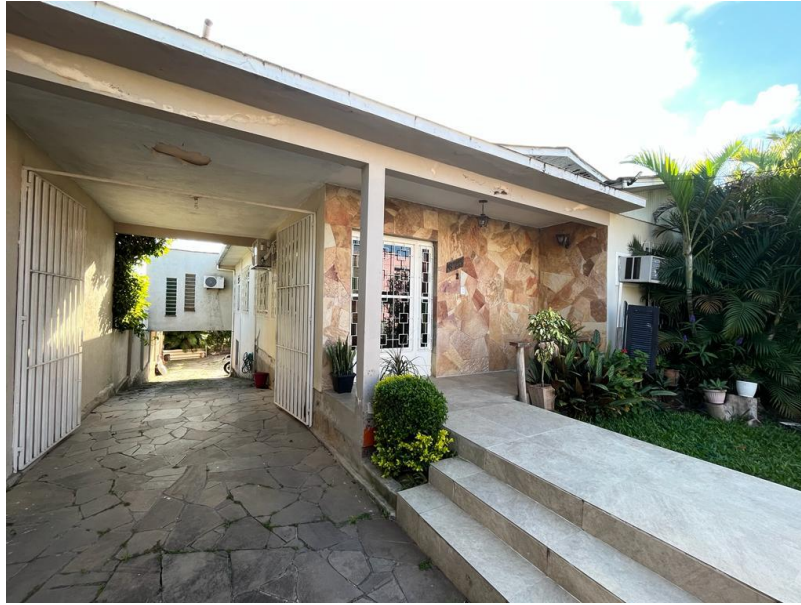
Figura 3 – Fachada Leste da residência
