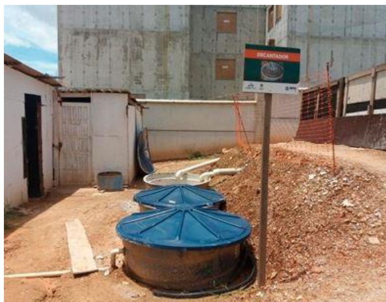
Figura 21 - Sistema de captação de água da chuva pela construtora MRV.
