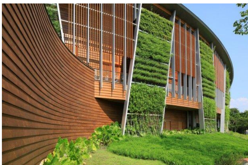
Figura 13 - Pavilhão da Expo Flora de Taipei, em Taiwan, projetado pelo escritório Bio-architecture Formosana.
