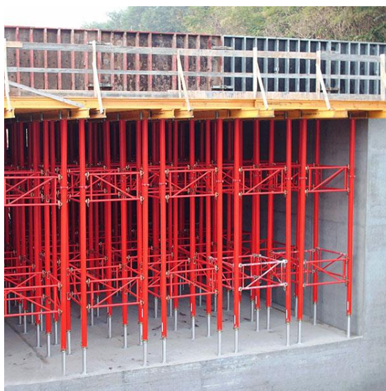
Figura 20 - Escoramentos metálicos.
