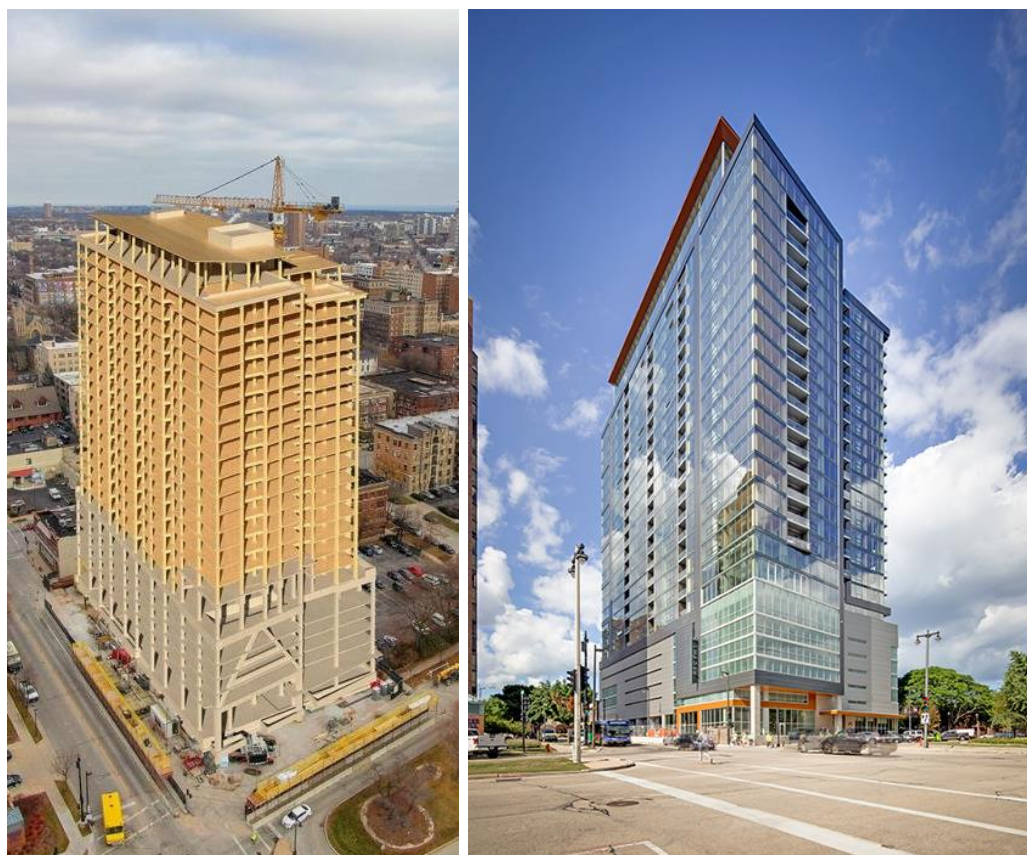
Figura 18 – Edifício Ascent, nos Estados Unidos, com estrutura em madeira engenheirada, projetado pelo escritório Korb + Associates Architects.
