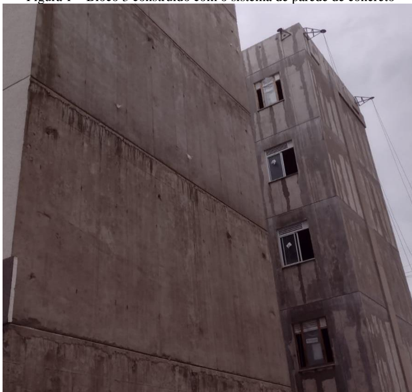
Figura 1 – Bloco 3 construído com o sistema de parede de concreto
