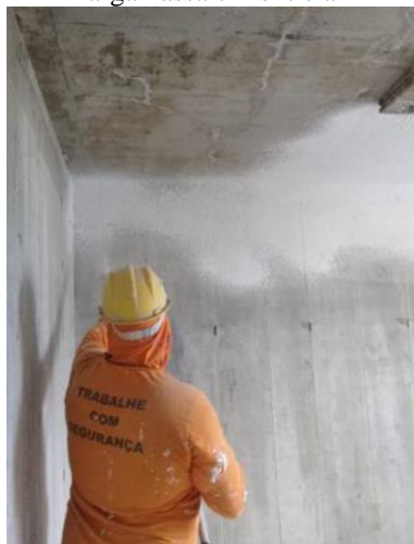
Figura 8 – Início da aplicação da argamassa cimentícia
