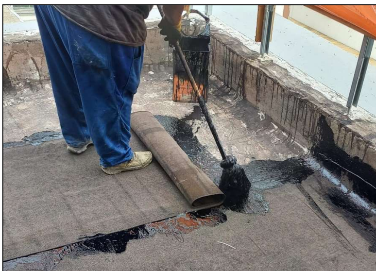
Figura 47 - Colagem da Manta
