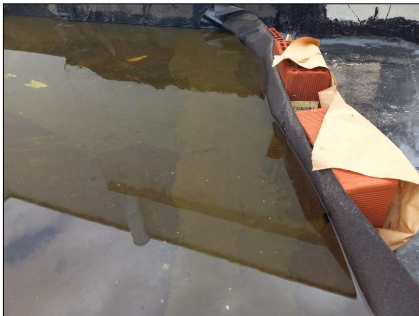
Figura 48 – Barreira provisória para teste da impermeabilização
