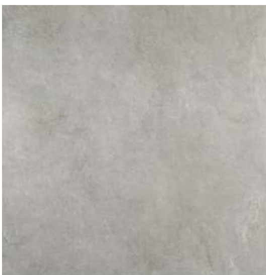
Figura 51 - Placas cerâmicas das varandas e terraço condominial
