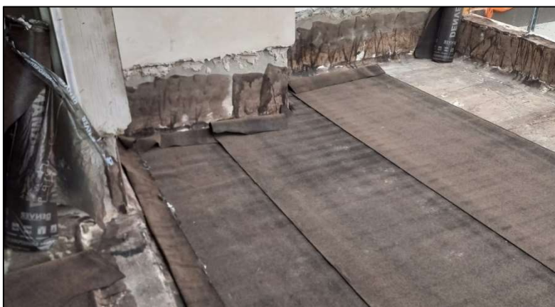
Figura 46 - Alinhamento da Manta
