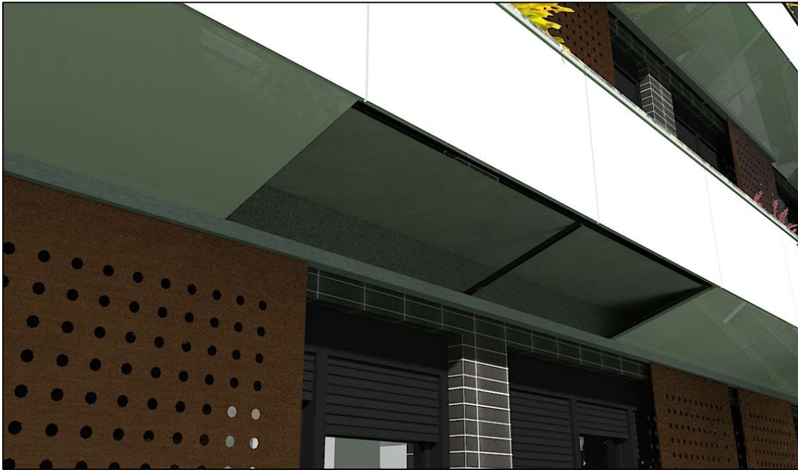
Figura 42 - Fundo falso em ACM sob as abas
