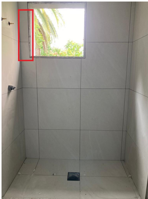
Figura 33 – Banheiro final 12 com nova paginação, indicação no canto esquerdo superior do local onde seria registrado o filete caso fosse seguida a paginação de projeto
