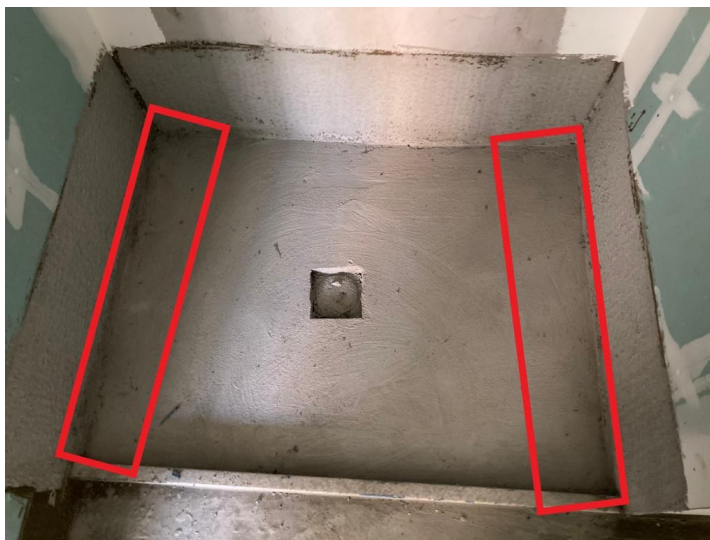
Figura 31 – Mapeamento das regiões que apresentam som cavo
