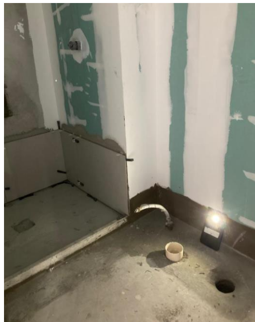
Figura 17 – Perda por making-do registrada na categoria “Instalações provisórias”
