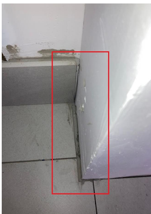
Figura 23 – Encontro cerâmica com carenagem com junta muito larga e imprecisa, diferenciando do encontro do rodapé
