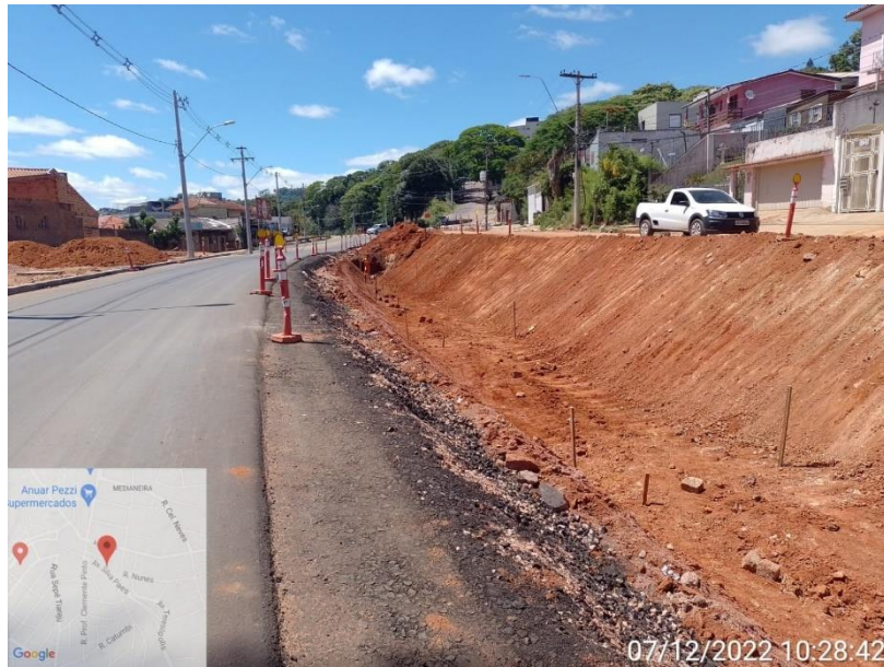
Figura 4- Início da execução do muro de arrimo dezembro/2022 Fonte: Autor
