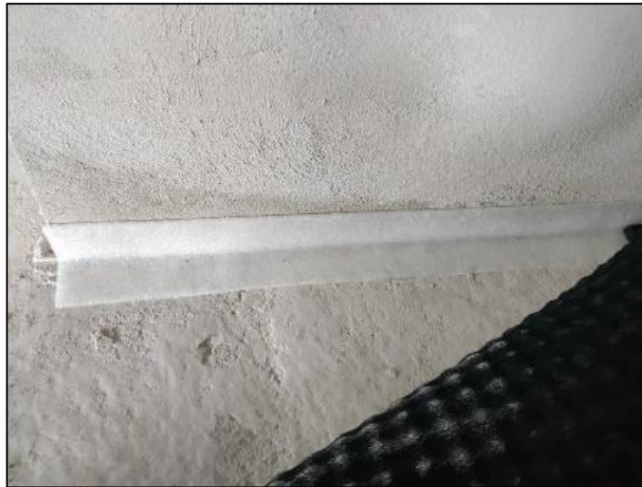
Figura 35 - Rodapé instalado com virada na laje adequada
