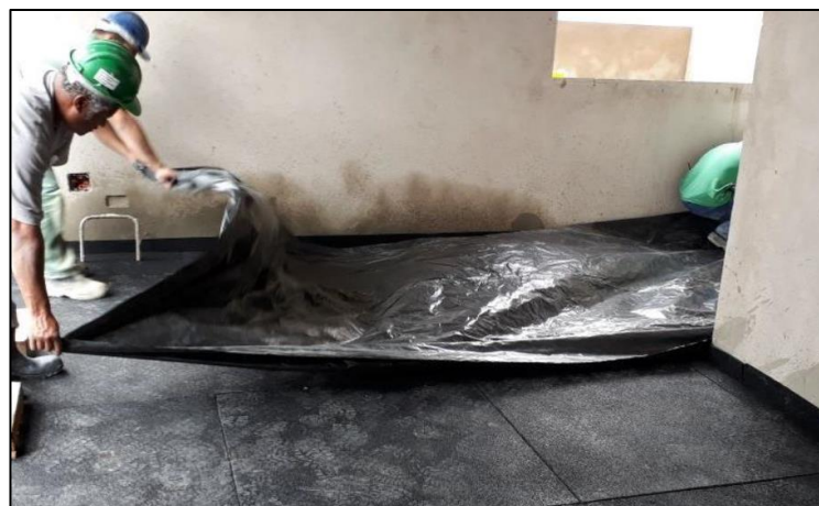
Figura 47 - Colocação de lona 60 micras sobre manta acústica
