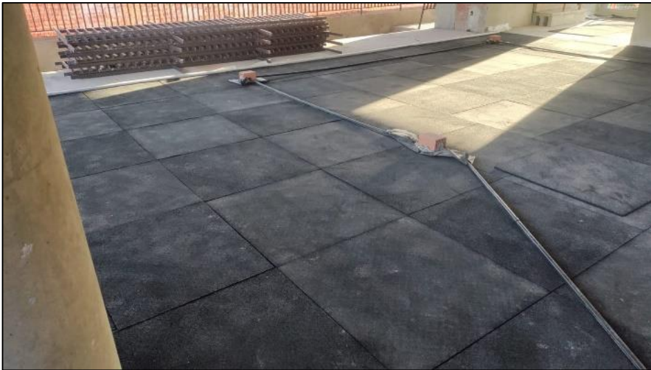
Figura 37 - Ambiente da sala com manta acústica colocada
