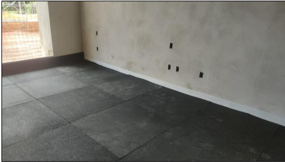
Figura 38 - Ambiente de dormitório com manta acústica colocada
