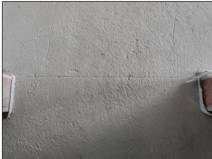
Figura 56 - Junta de separação de ambientes
