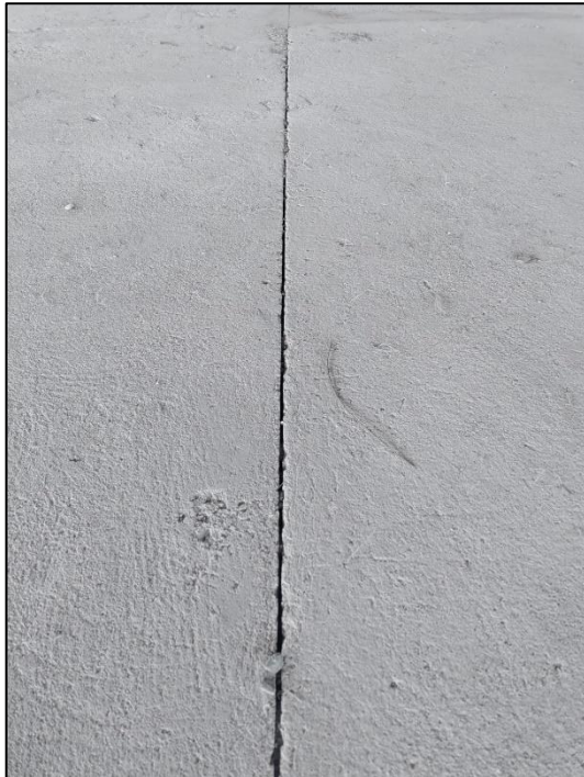
Figura 54 - Junta de dilatação do contrapiso de dormitório
