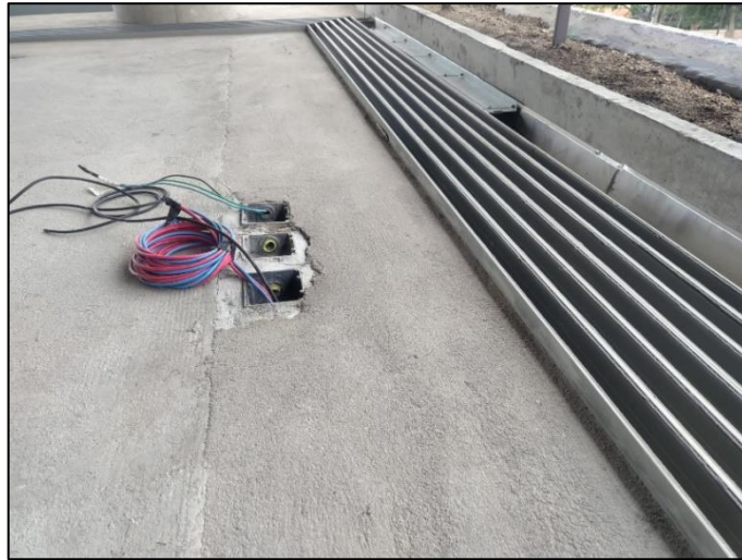
Figura 76 - Faixa de contrapiso executada de forma aderida
