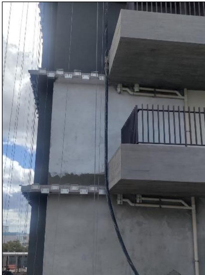
Figura 29 - Transporte vertical da argamassa através de mangotes
