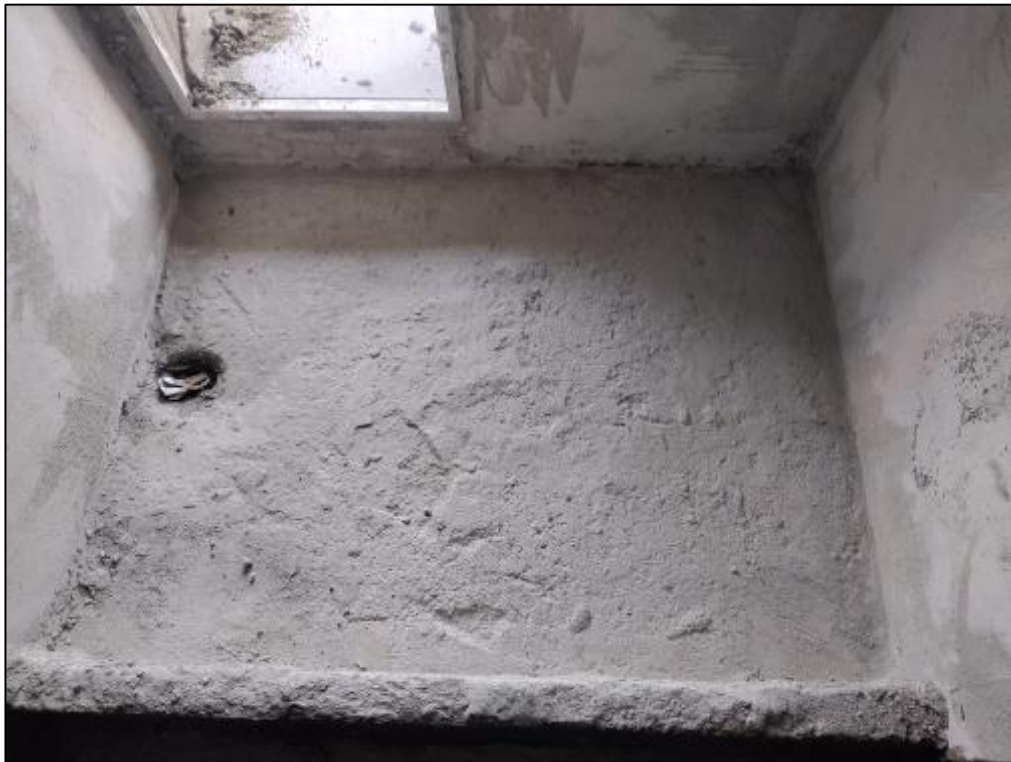
Figura 48 - Box preparado para execução do contrapiso
