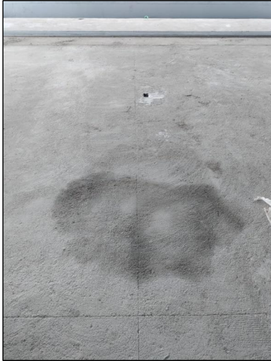
Figura 53 - Junta de dilatação do contrapiso da sala de estar
