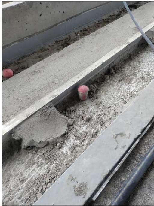
Figura 69 - Grapa chumbada do contramarco voltada para o lado interno
