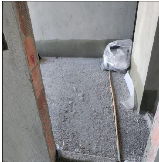
Figura 49 - Lavanderia preparado para execução do contrapiso
