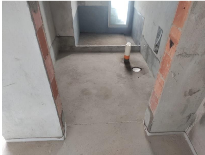
Figura 60 - Banheiro com junta de dilatação acústica
