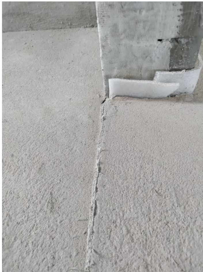
Figura 61 - Detalhe de impermeabilização entre banheiro e dormitório
