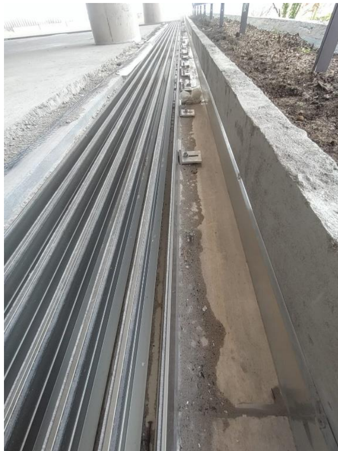
Figura 66 - Drenagem da esquadria substituindo o ralo sekapiso
