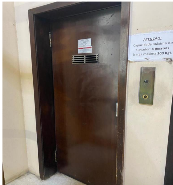
Figura 7 - Elevador do prédio do curso de Engenharia Elétrica da UFRGS
