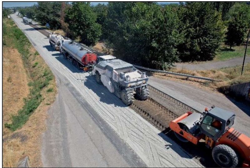
Figura 9 - Equipamentos executando uma FDR com adição de emulsão asfáltica.
