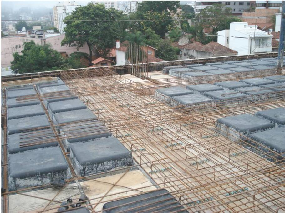
Figura 6: disposição das armaduras na laje
