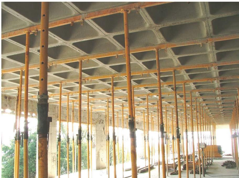
Figura 7: aspecto final da laje nervurada após a retirada das cubetas
