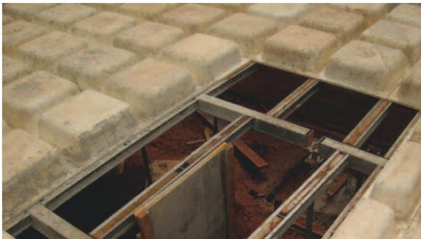
Figura 20: sistema específico para lajes nervuradas com cubetas (SH FÔRMAS, ANDAIMES E ESCORAMENTOS LTDA., 2009, p. 8)
