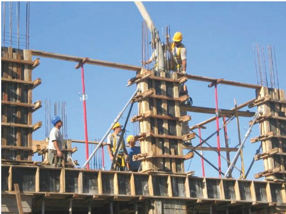
Figura 3: concretagem do pilar antes da execução das demais fôrmas
