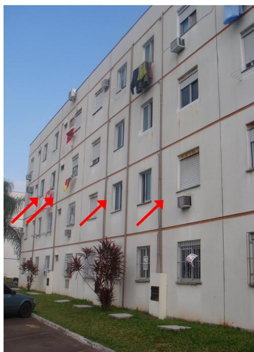
Figura 6: colunas de alimentação de água - condomínio 2
