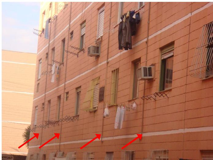
Figura 5: colunas de alimentação de água - condomínio 1
