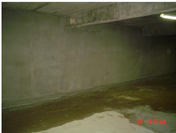
Figura 14: impermeabilização da cortina com cimento polimérico
