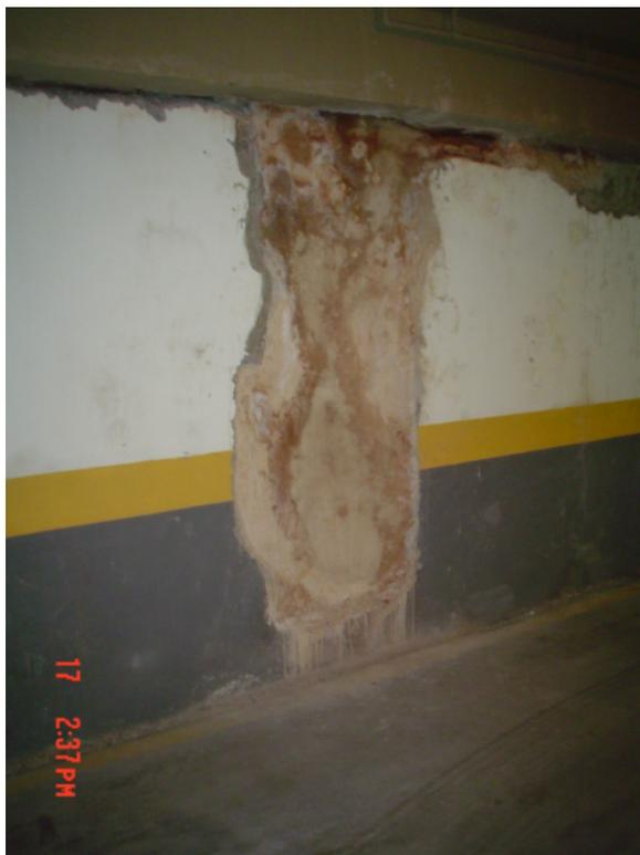
Figura 24: infiltração de água com areia
