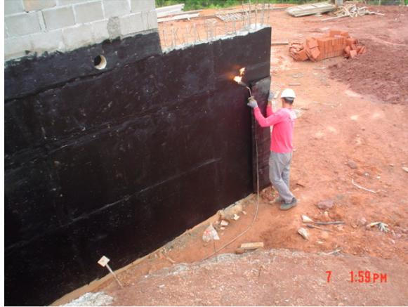
Figura 16: posicionamento da manta asfáltica
