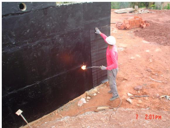
Figura 21: manta asfáltica aderida na superfície
