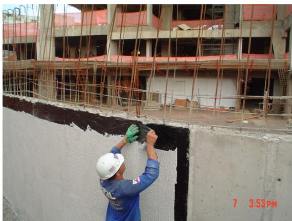
Figura 9: colocação de lona plástica para retomada
