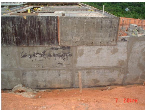
Figura 15: cortina com o preenchimento dos furos dos tubos de PVC
