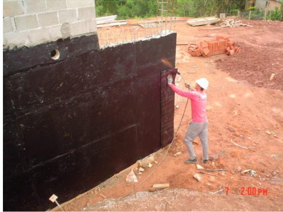
Figura 18: aplicação de manta asfáltica lado direito
