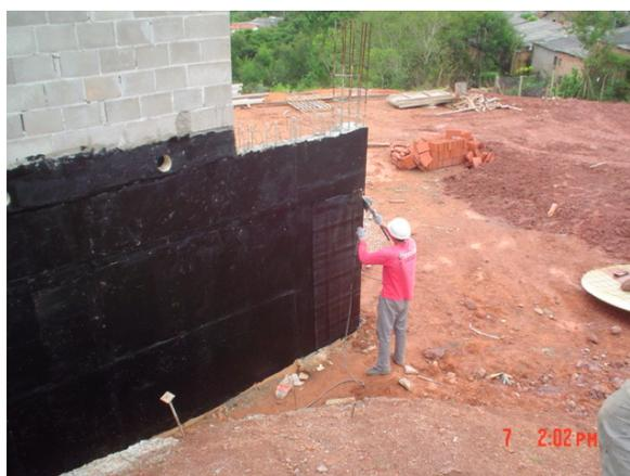
Figura 22: biselamento da manta asfáltica
