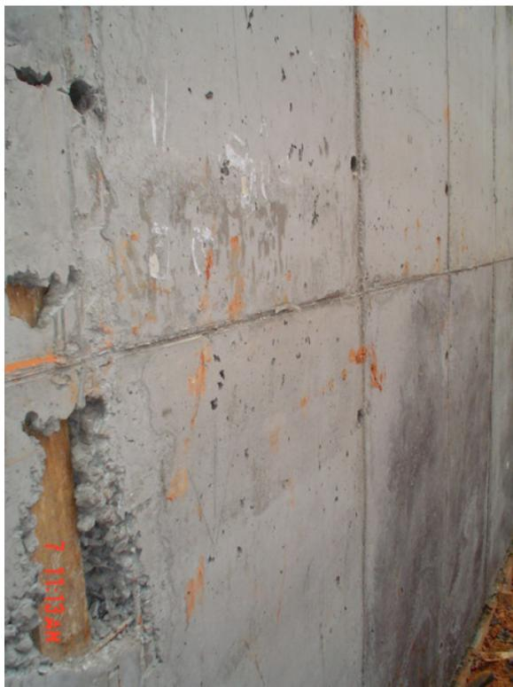
Figura 7: cortina com falhas de concretagem e com tubos de PVC embutidos na mesma
