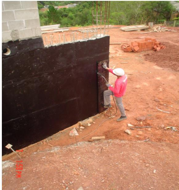
Figura 17: fixação parcial da manta asfáltica
