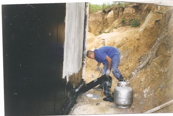
Figura 3: aplicação de reforço com manta asfáltica (trabalho não publicado)<sup>2</sup>
