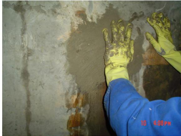
Figura 26: aplicação do Xypex® Patch'n plug
