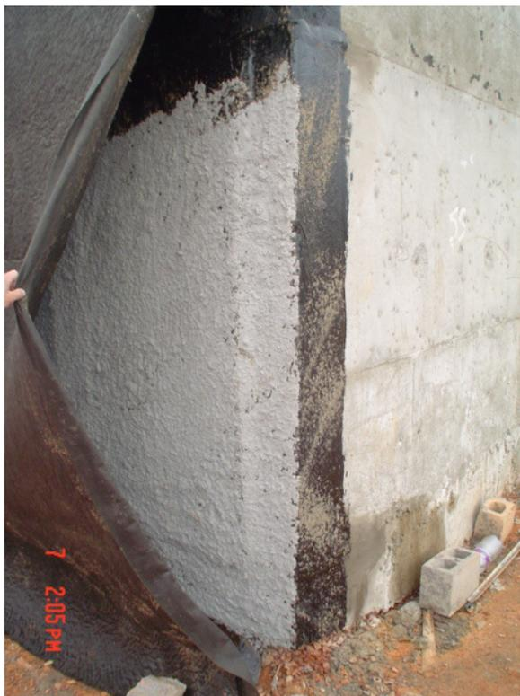
Figura 23: cortina com proteção mecânica e geocomposto para drenagem
