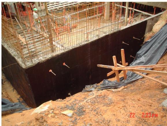
Figura 11: cortina perfurada após impermeabilização
