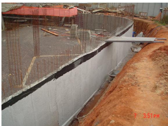
Figura 5: proteção mecânica com chapisco de cimento e areia (trabalho não publicado)<sup>6</sup>
