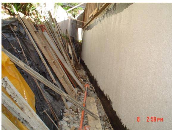
Figura 10: aplicação de impermeabilização na base da cortina, após a proteção mecânica
