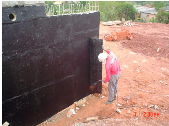
Figura 19: aplicação de manta asfáltica lado esquerdo
