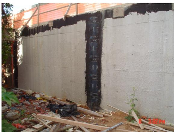
Figura 12: tratamento da junta de dilatação com dupla manta asfáltica
