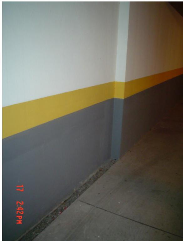
Figura 28: parede diafragma e parede de placa cimentícia
