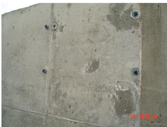
Figura 4: furos com tubo de PVC utilizados para travamento de formas
