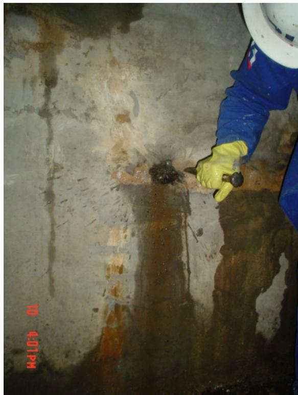
Figura 25: escarificação do concreto
