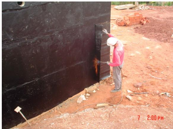
Figura 20: aplicação de manta asfáltica
